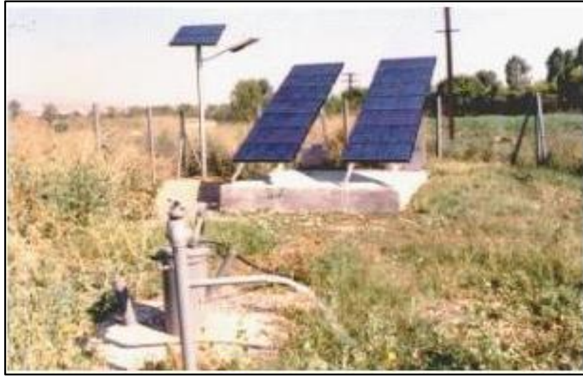
Şekil 1.9 Güneş enerjili sulama sistemi.
