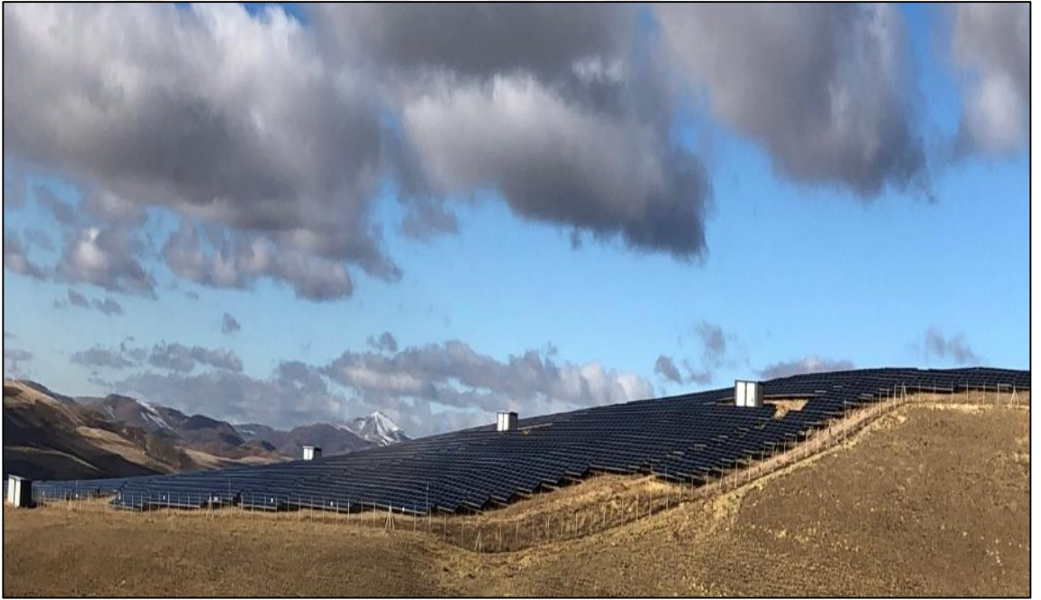
Şekil 53. Güneş enerji santralinin görüntüsü-2
