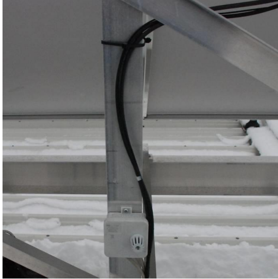
Şekil 4.20. Ortam sıcaklık sensörünün montajı.
