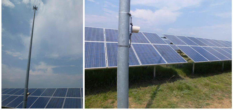
Şekil 4.10. Paratonerin FV modülleri gölgelemesi.
