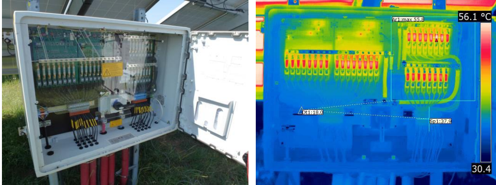
Şekil 4.14. d.a dağıtım panosunun, dijital ve kızılötesi kamera ile fotoğraf çekimleri.
