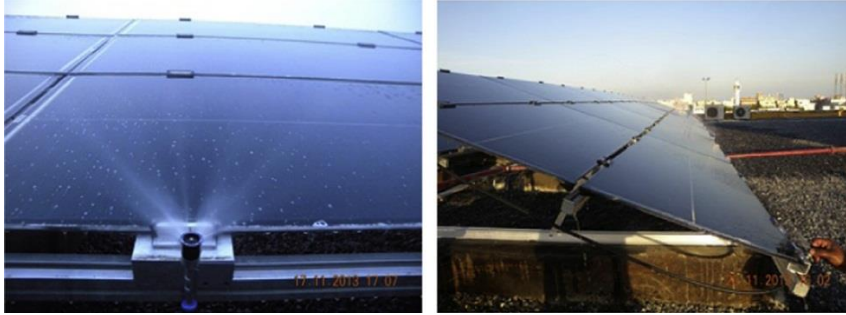
Şekil 2.1. Otomatik FV modül temizleyici sistemi.
