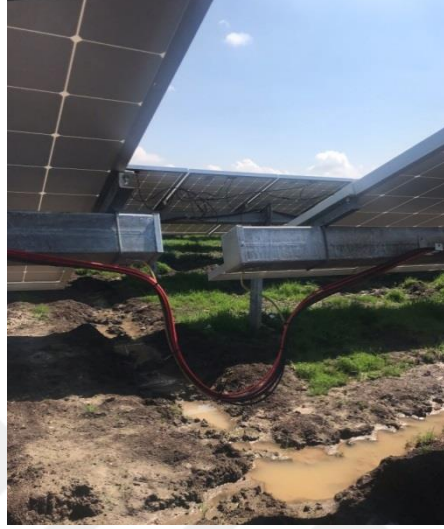
Şekil 5.9: Sehpalar Arasında ki DC Kablo Geçişi
