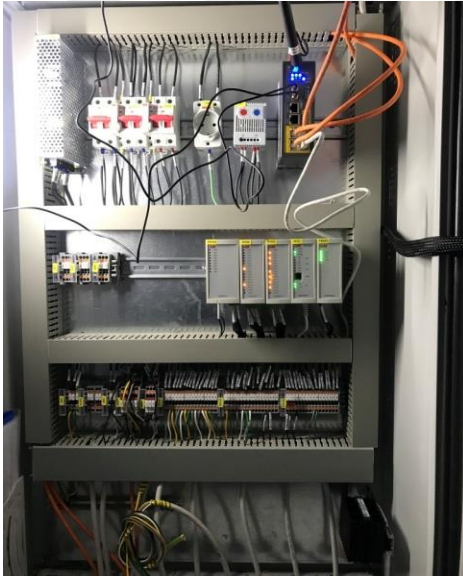
Şekil 5.20: Topraklama Kablosu Bulunmasına Rağmen Metalleri Topraklanmayan Otomasyon Panosu
