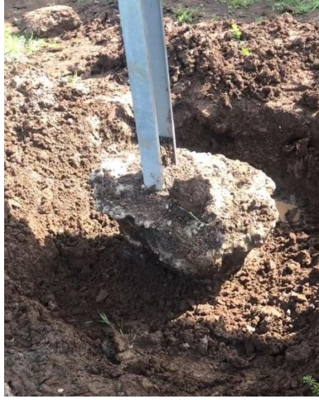
Şekil 5.15: Konstrüksiyon Bacağı Kazılmış Beton Görüntüsü
