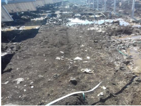
Şekil 5.18: Topraklama Şeritleri Dışarıda Kalmış FV Paneller
