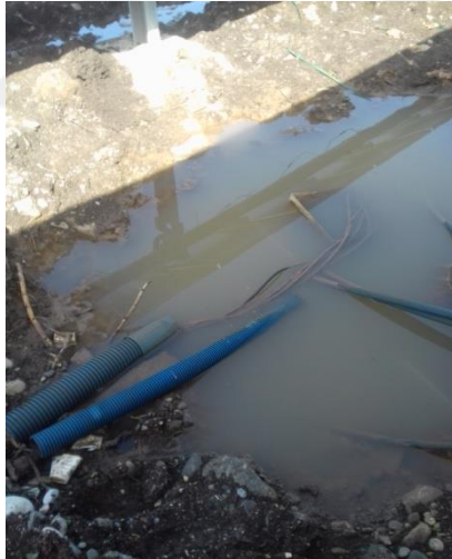
Şekil 5.8: GES-9 Kabloları Dışardan Giden AC ve DC Kablolar
