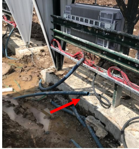
Şekil 5.4: Kablo Tava Kapakları Açık İnverterler
