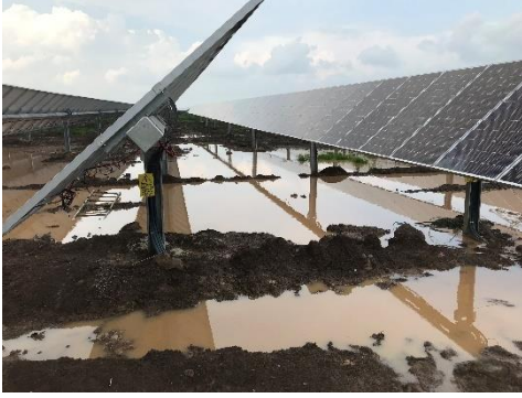
Şekil 5.1: Drenajı Yetersiz Yerler
