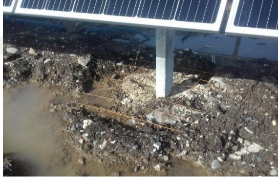
Şekil 5.16: Hasır Demirleri Dışarıda Kalmış Konstrüksiyon Bacağı
