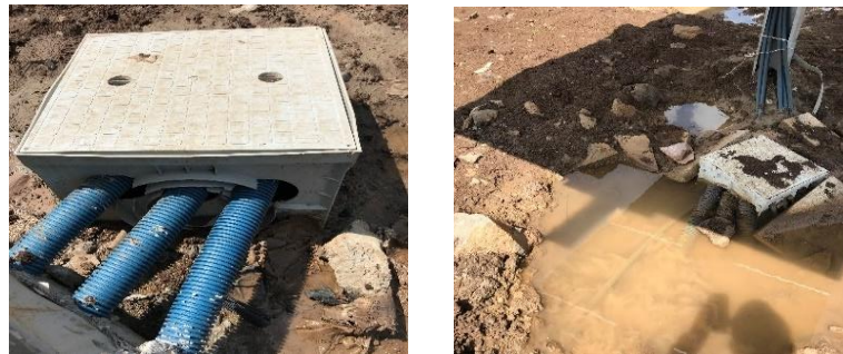
Şekil 5.11: Kırık ve Açıklık Olan Menholler
