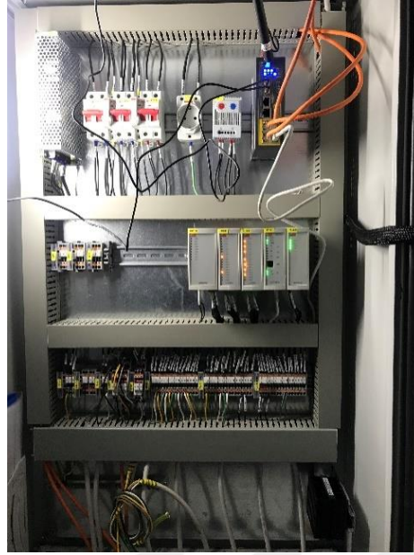
Şekil 5.37: Otomasyon Panosu
