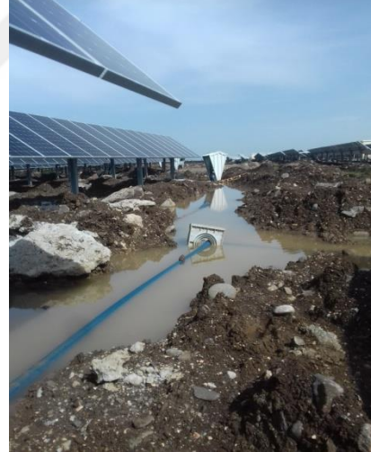
Şekil 5.8: GES-9 Kabloları Dışardan Giden AC ve DC Kablolar
