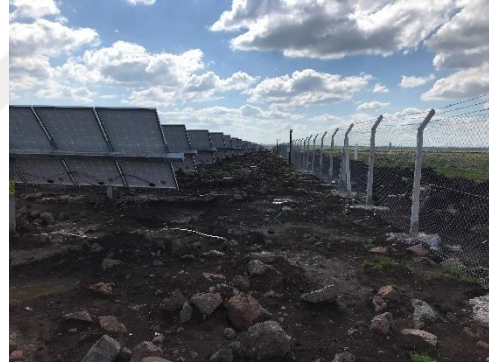
Şekil 5.18: Topraklama Şeritleri Dışarıda Kalmış FV Paneller
