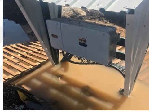
Şekil 5.1: Drenajı Yetersiz Yerler
