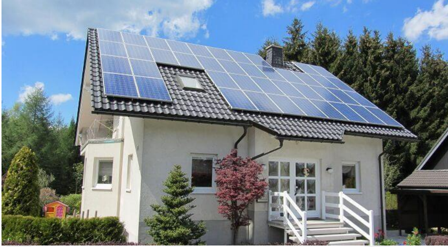
Şekil 3.86 Örnek bir off-grid uygulaması
