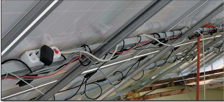
Şekil 3.12. Panel altı sıcaklık elektrik tesisatı
