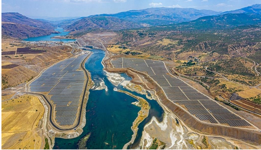
Şekil 4.1. Aşağı Kaleköy Yardımcı Kaynak Güneş Enerji Santrali
