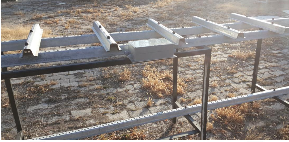
Şekil 3.8: Bağlantı kutusunun taşıyıcı sistem üzerine montajı
