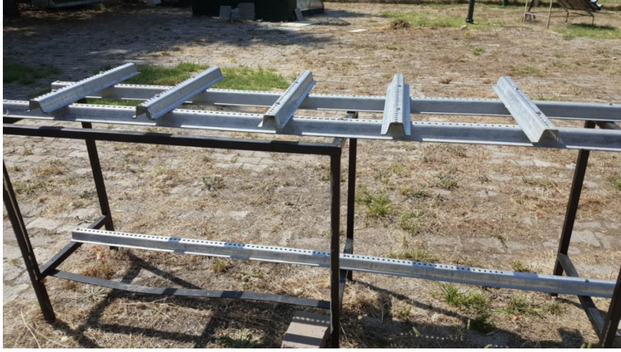
Şekil 3.5: Panel-taşıyıcı sistem bağlantı elemanlarının yerleştirilmesi
