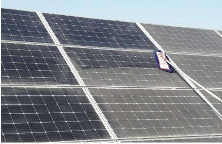
Şekil 1.23. Güneş Panellerinde Tozlanma Sorunu (Anonim, 2021n)
