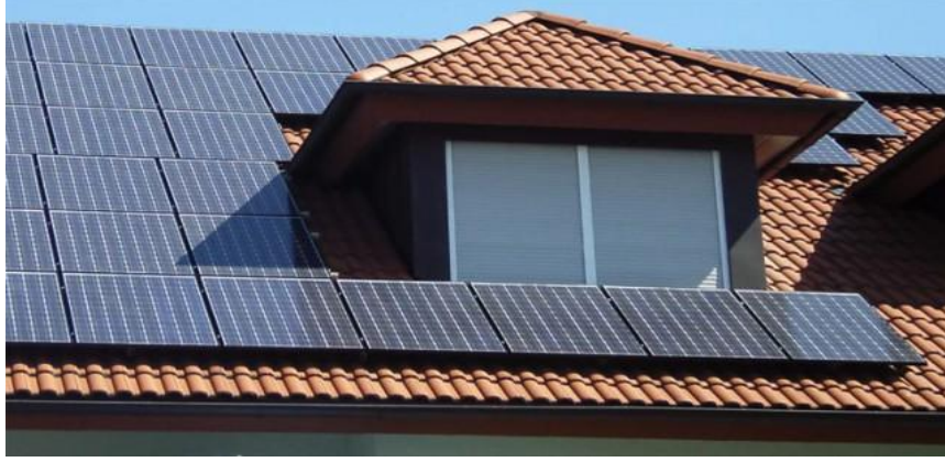
Şekil 1.22. Güneş Panellerinde Gölgeleme Sorunu (Anonim, 2021m)
