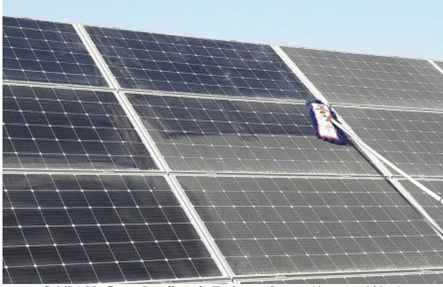
Şekil 1.23. Güneş Panellerinde Tozlanma Sorunu (Anonim, 2021n)
