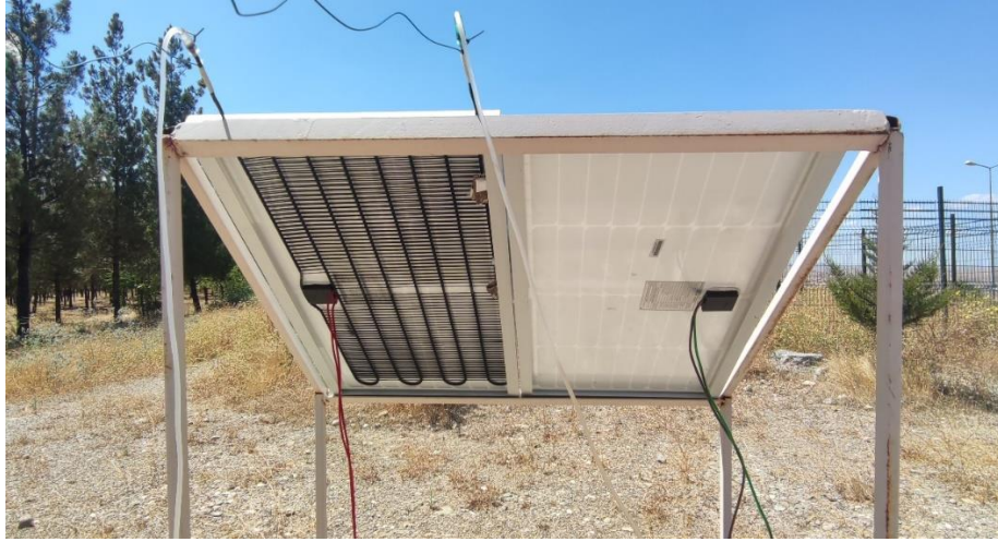
Şekil 3.2. Güneş paneli ve boruların montaj hali
