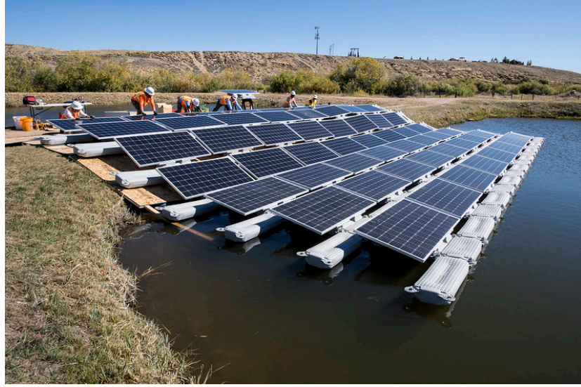
Şekil 5.4. Su ile pasif soğutma – yüzdürme yöntemi [157]
