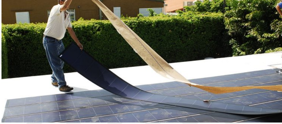
Şekil 3.8. Amorf silisyum ince film modül uygulaması [124]
