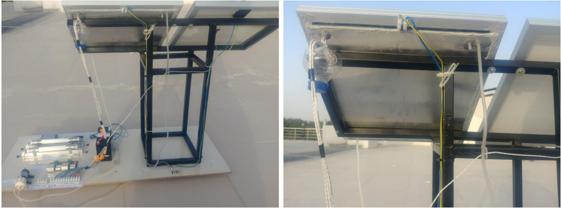
Şekil 6.4. PV modüllerin tamamlanmış montaj görüntüleri
