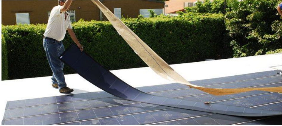
Şekil 3.8. Amorf silisyum ince film modül uygulaması [124]
