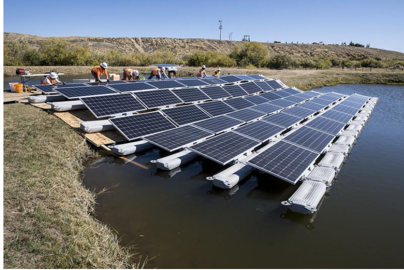
Şekil 5.4. Su ile pasif soğutma – yüzdürme yöntemi [157]
