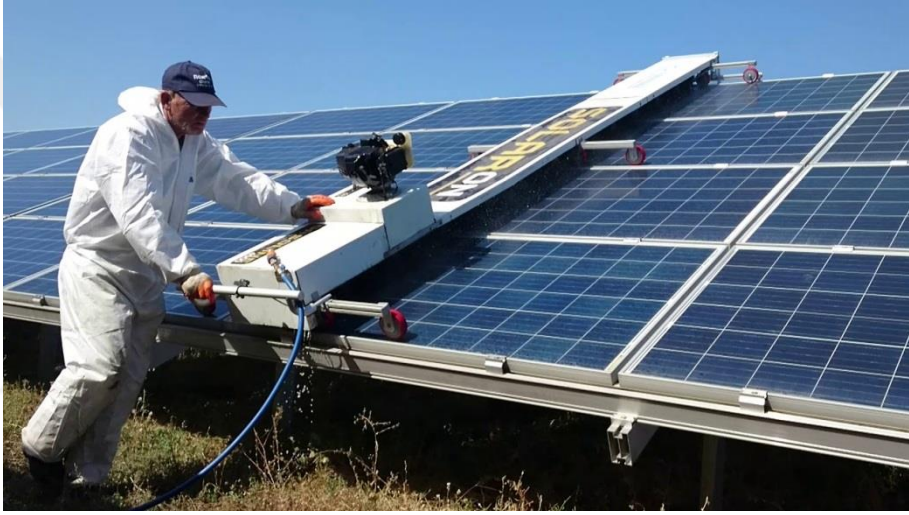
Şekil 4.5. Tozlanmanın mekanik bir aparatla temizlenmesi (URL-27, 2022)
