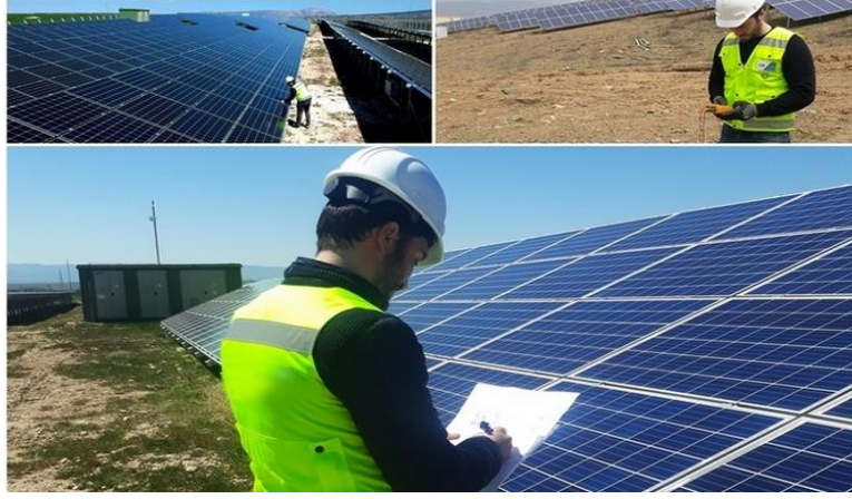
Şekil 3.11. Santral kontrol testleri
