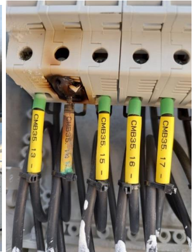
Şekil 4.11. Kablolama hatası sonucu oluşan yanmalar
