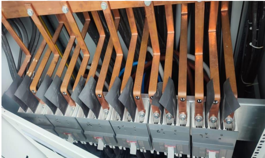
Şekil 4.27. Doğru yapılmış bara bağlantısı
