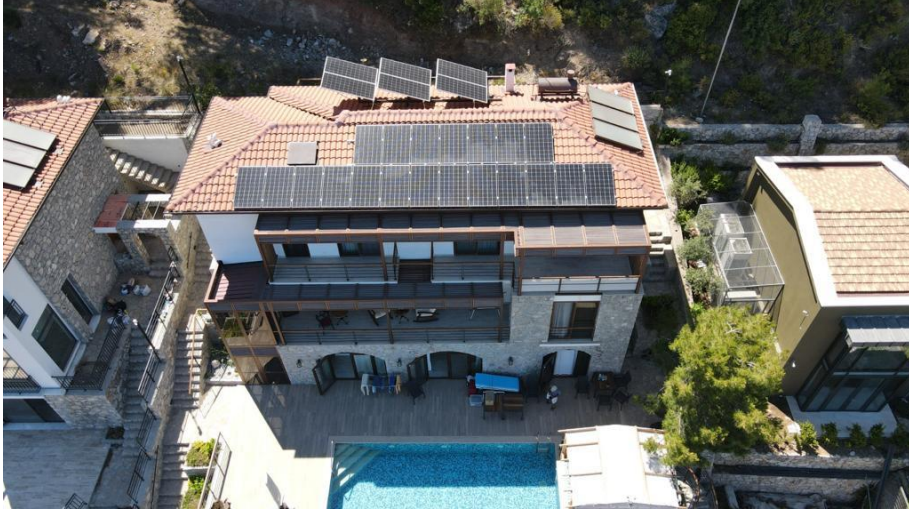
Şekil 4.8. Gölgelemenin olmaması için parçalı yerleşim
