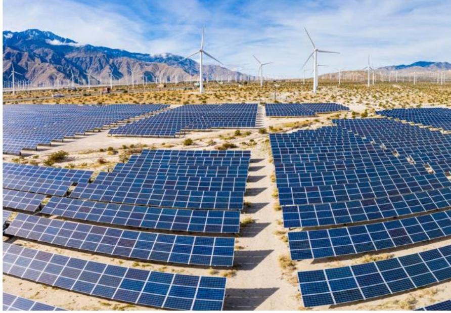
Şekil 2.6. Güneş enerji tarlası [68]
