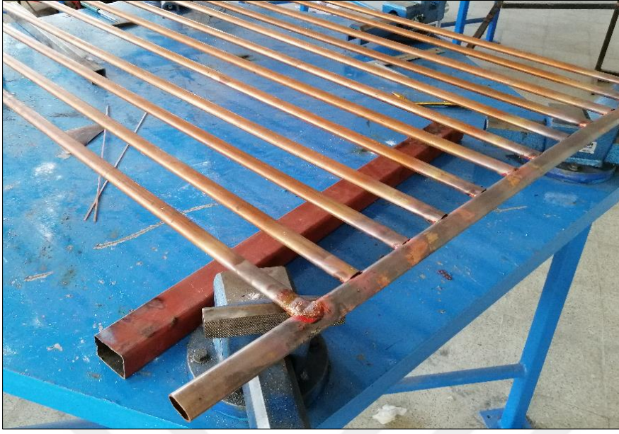
Resim 4.1. Soğutucu serpantin borularının kaynak ile bağlantı süreci
