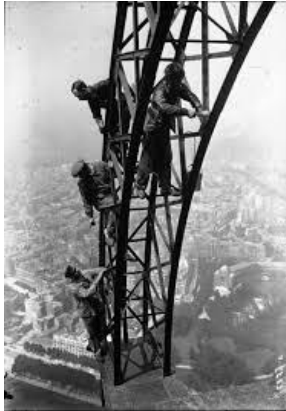
Şekil 4.26 : Kulenin Yapım Sürecine Dair Bir Fotoğraf (Url-30).
