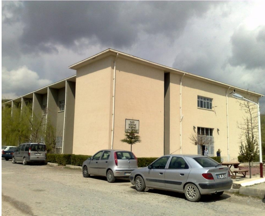
Fotoğraf 4.1. F.Ü. Teknoloji Fakültesi İnşaat Mühendisliği Bölümü Ek Binası
