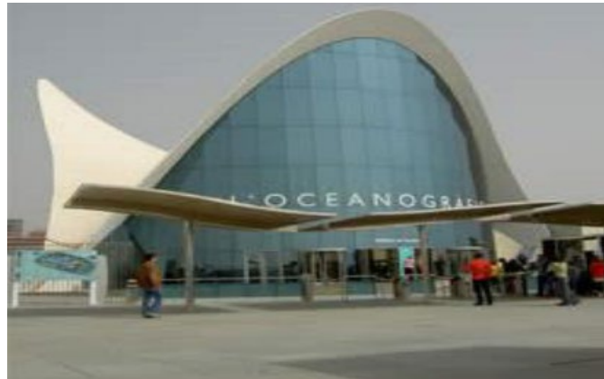
Şekil 1.2. Çelik lifle yapılan Valencia’daki Avrupa Oşinografi Park Binası (Blaszczynski ve Przybylska-Falek, 2015)
