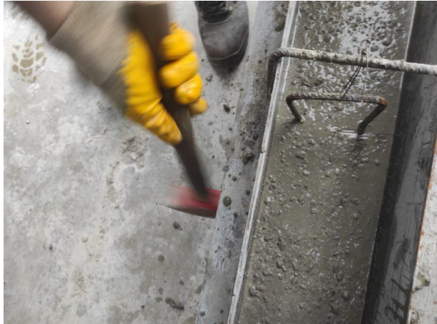
(h) Betonun yerleştirilmesi
