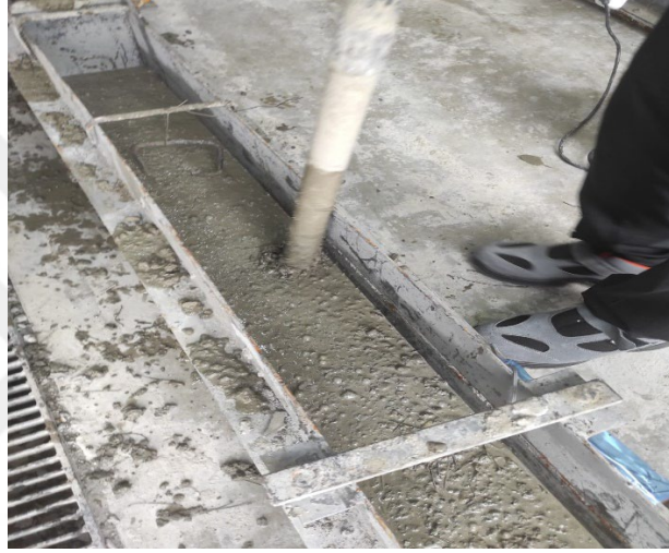
(g) Betonun vibratörle sıkıştırılması
