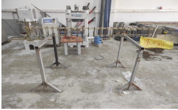
Şekil 3.7. Donatıların hazırlanması
