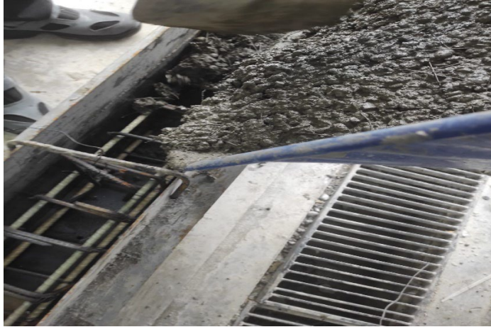
(e) Betonun kalıba dökülmesi
