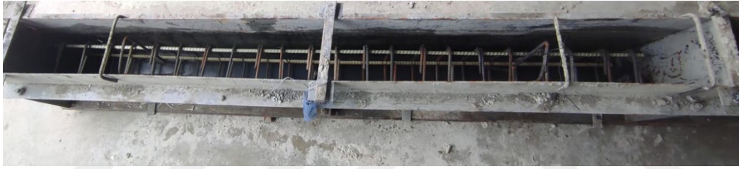
Şekil 3.14. Donatıların kalıba yerleştirilmesi
