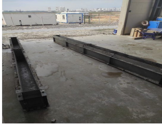
Şekil 3.12. Kiriş kalıplarının kurulması
