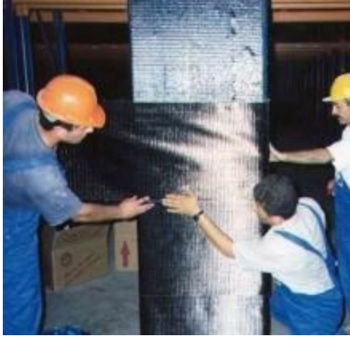
a) FRP ile kompozitlerin Dikdörtgen kesitli kolonlarda uygulanması
