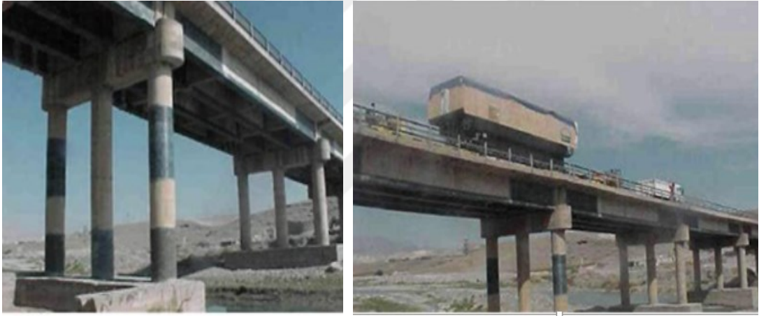
Şekil 1.4. Göksu köprüsü güçlendirme çalışması
