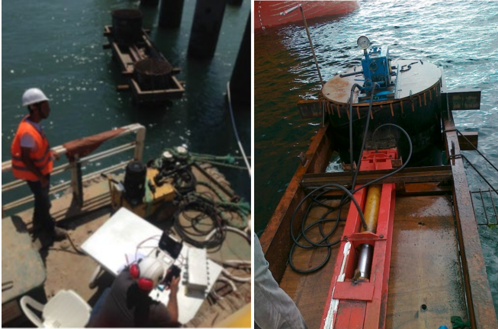
Şekil 3.18. Kazık Yükleme Testi Kurulumu
