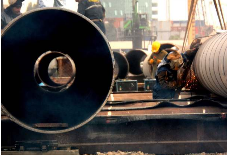
Şekil 3.1. Çelik Kazıklar Kaynak İşleri
