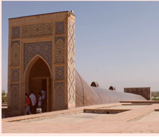
Şekil 2.5: Solda Uluğ Bey'in Semerkant'taki gözlemevinin restore edilmiş binaları, sağda ise yıldızların ve gezegenlerin pozisyonlarını ölçmekte kullanılan 40 m'lik kuadrant 1 .
