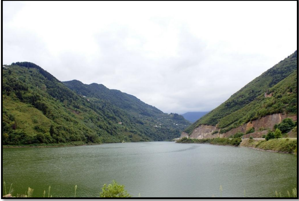
Şekil 3. Atasu barajından bir görünüm
