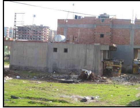
Resim.5.8. Müştemilat yapımında kullanılan malzeme [Özen, N., 2007 ]
