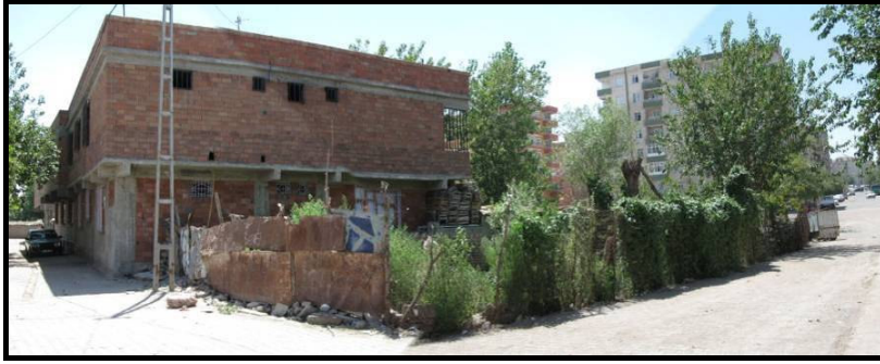
Resim 4.22. 3.adanın kuzeyinden bir görünüm [Özen, 2007]
