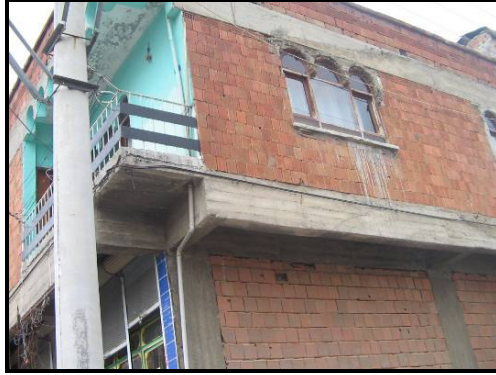
Resim 5.4. Dış duvarlarda tuğla kullanımı [ Özen, 2007]
