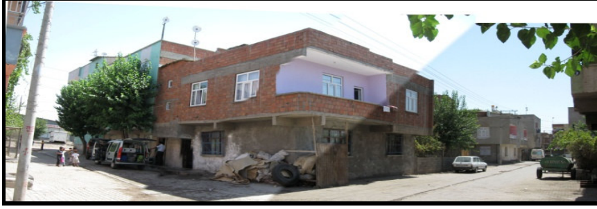
Resim 4.5. 1.adanın kuzeybatıdan görünümü [Özen, 2007]
