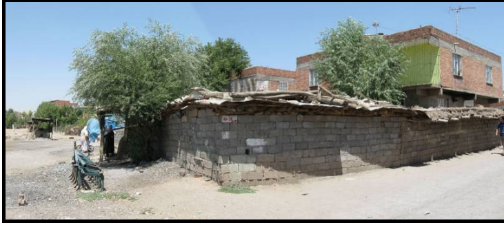
Resim 4.18. 3.adanın güneybatısından bir görünüm [Özen, 2007]
