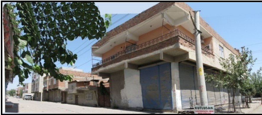
Resim 4.4. 1.adanın güney batıdan görünümü [Özen, 2007]
