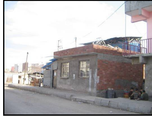
Resim 5.6 Yapılarda kullanılan malzemeler [Özen, N., 2007]
