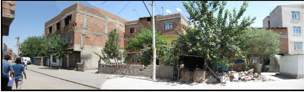
Resim 4.14. 2.adanın güneybatısından bir görünüm [Özen, 2007]
