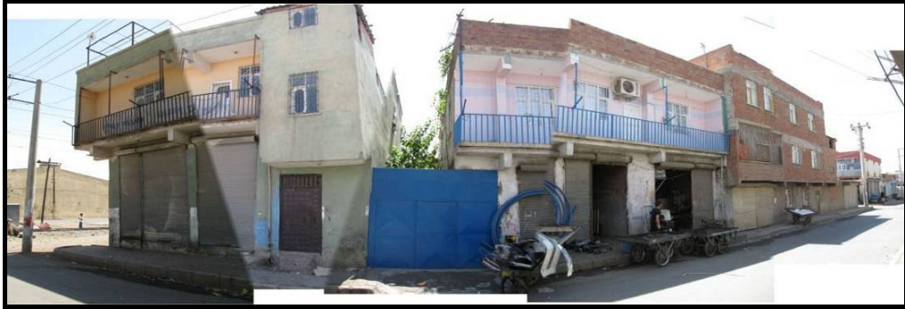
Resim 4.10. 2.adanın kuzeybatısından bir görünüm [Özen, 2007]
