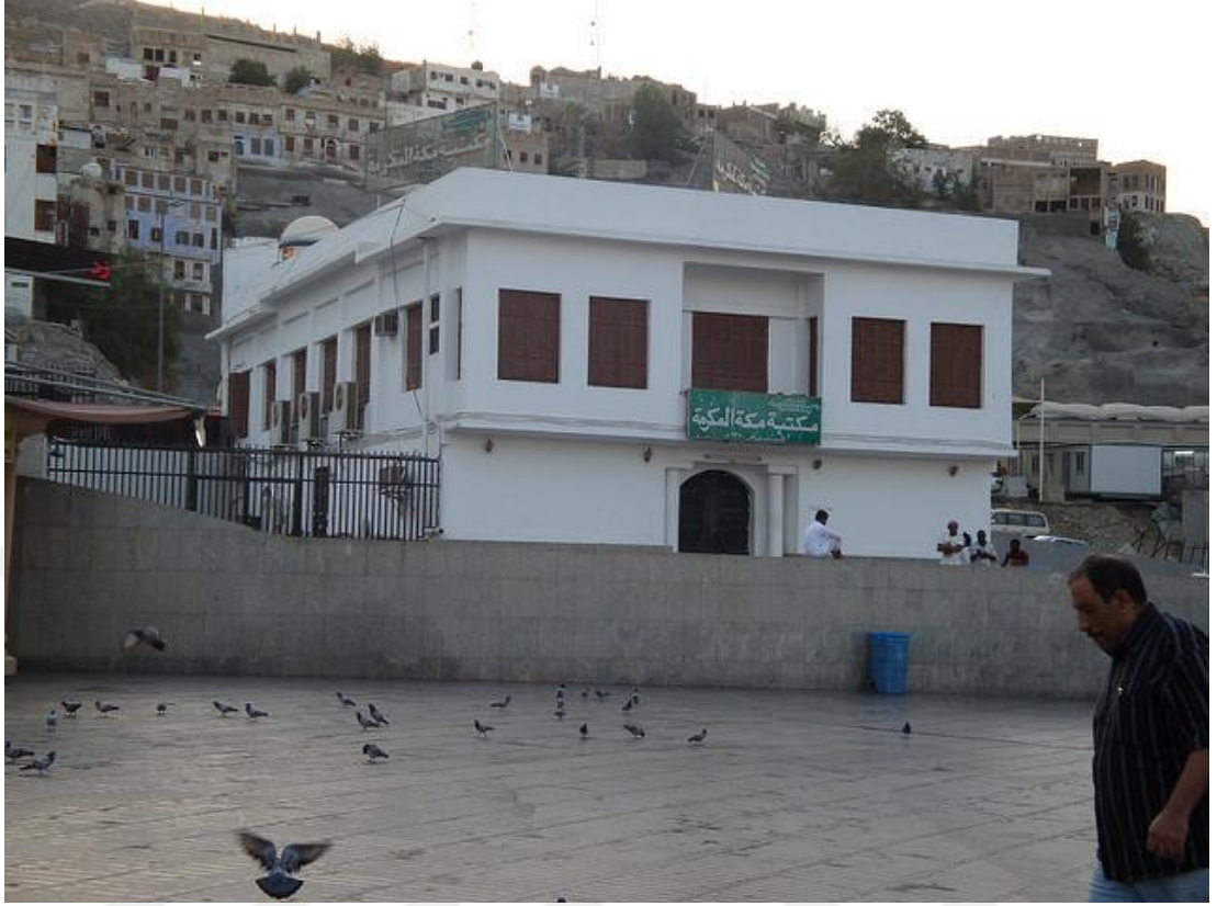
Resim 29: Mevlid-i Nebi Yıkıldıktan Sonra Yerine İnşa Edilen Kütüphane Binası
