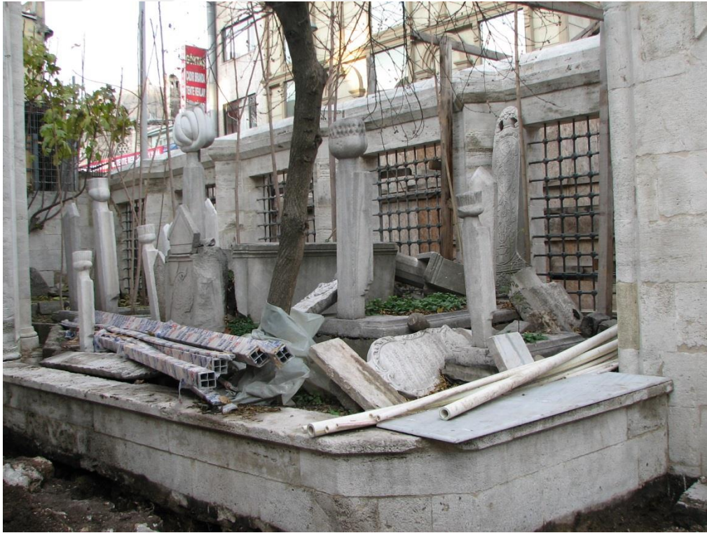
Restorasyon Öncesi Gazanfer Ağa Haziresi (Zeynep Tarım 2011)
