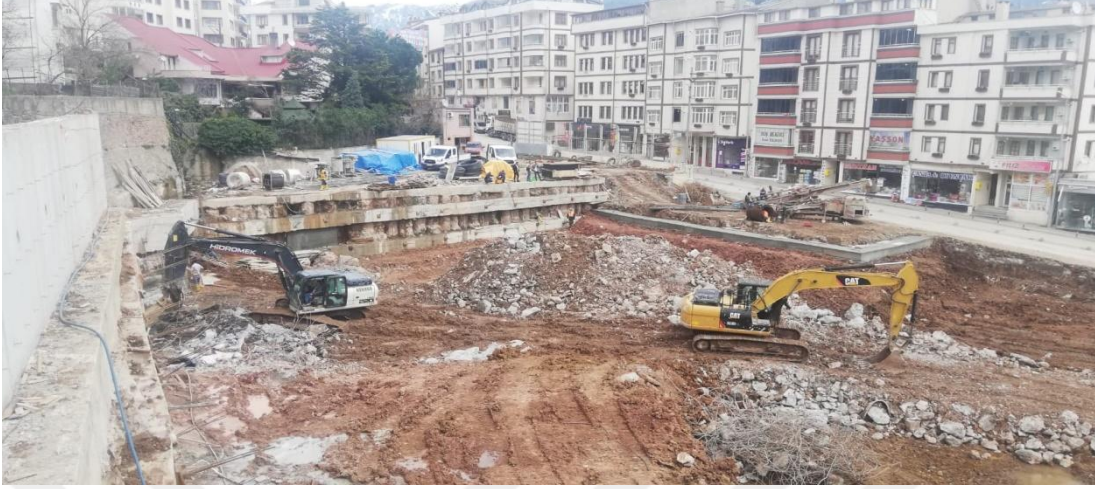
Ek-3. Çalışma alanındaki iksa uygulama aşamasına ait fotoğraflar
