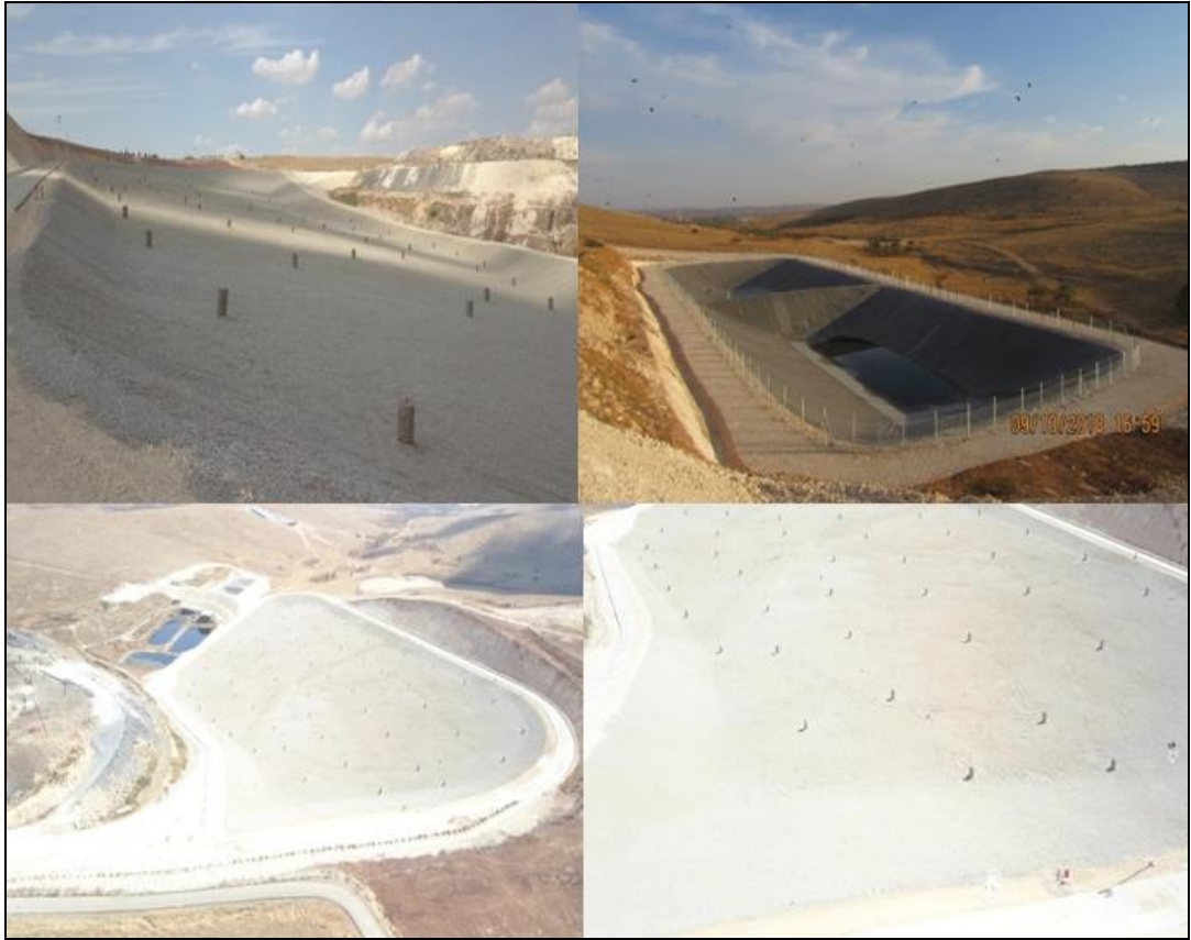
Şekil 3.1. Merkez düzenli depolama tesisi
