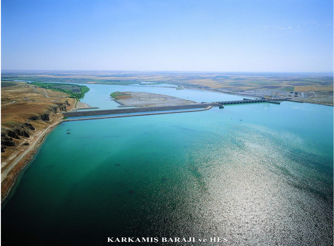
Fotoğraf 2. Karkamış Barajı ve Hidroelektrik Santrali (temelsu, 2022).
