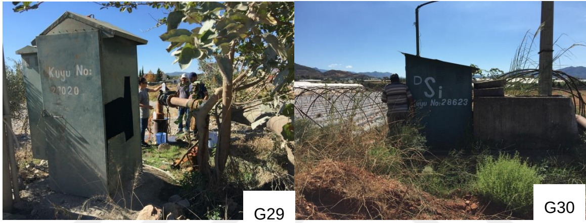
Şekil 2.14. Yeraltısuyu işletme kuyuları.
