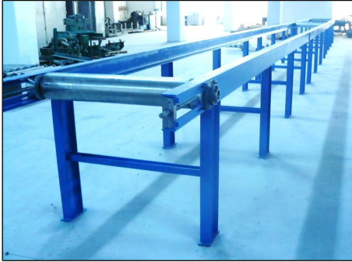
Şekil 3.8. Şasi ve bant tamburları ( Bant tamburları montaj aşaması)
