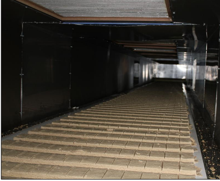
Şekil 3.1. Soğutma tüneli içi
