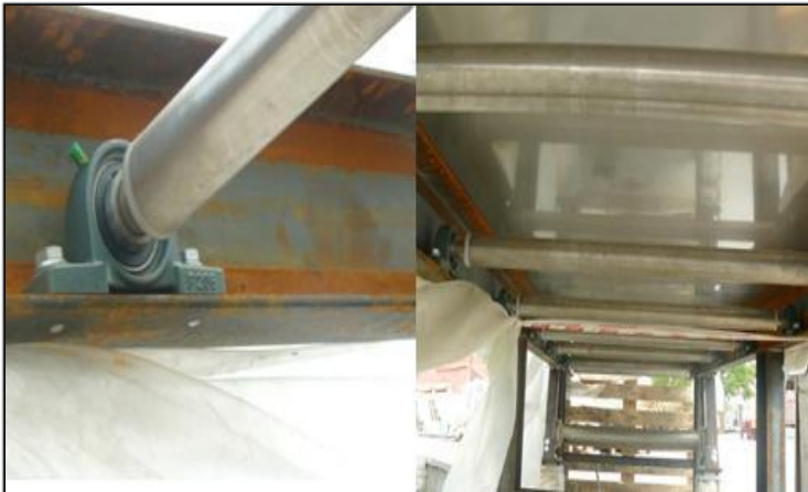
Şekil 3.11. Avara makara montajı
