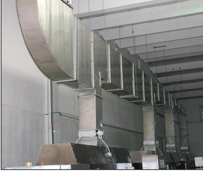
Şekil 3.3. Soğutma sistemi boru hattı
