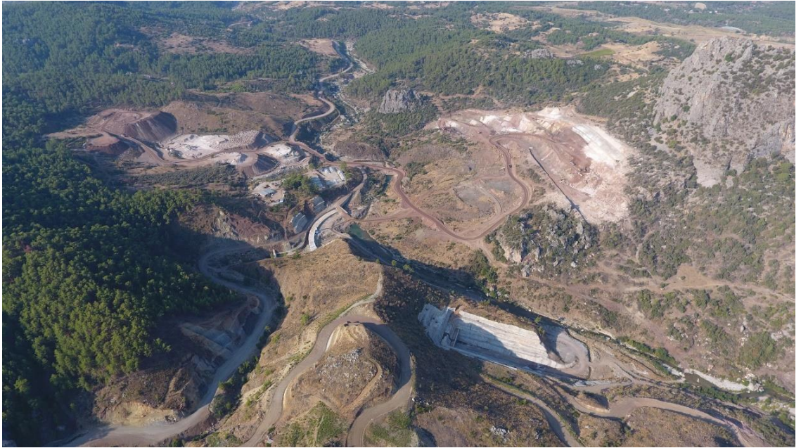
Şekil 4.8. Küçük Aksu Barajı (Anonim 2019)
