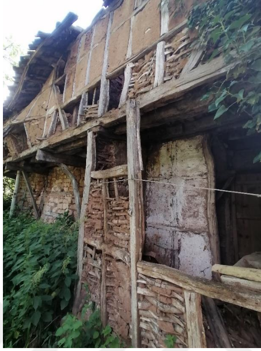
F. 16. Yağcılar Mahallesi eski yapı örneği
