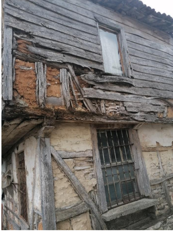
F. 11. Aralarında kerpiç örme çubuklar bulunan eski bir köy evi örneği
