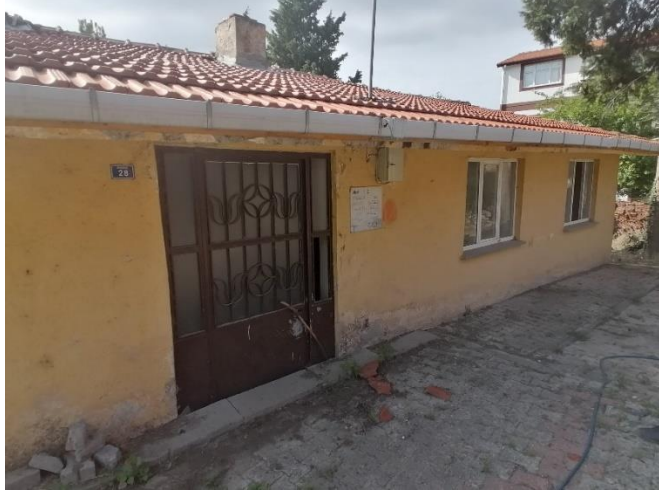
F. 10. Ahatlı Mahallesi'nden eski köy okulu yapısı.
