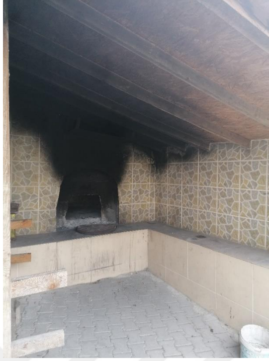
F. 17. Duraklı Mahallesi revize edilmiş eski köy ortak fırını
