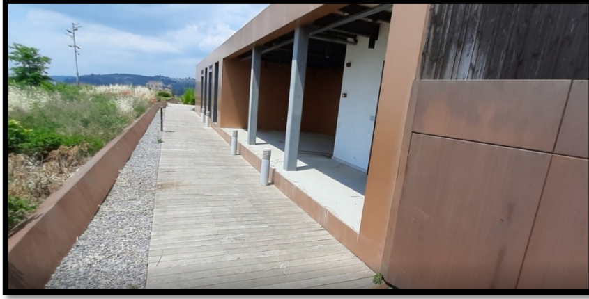
Şekil 45. Alan içerisinde yer alan yapıların çevresi
