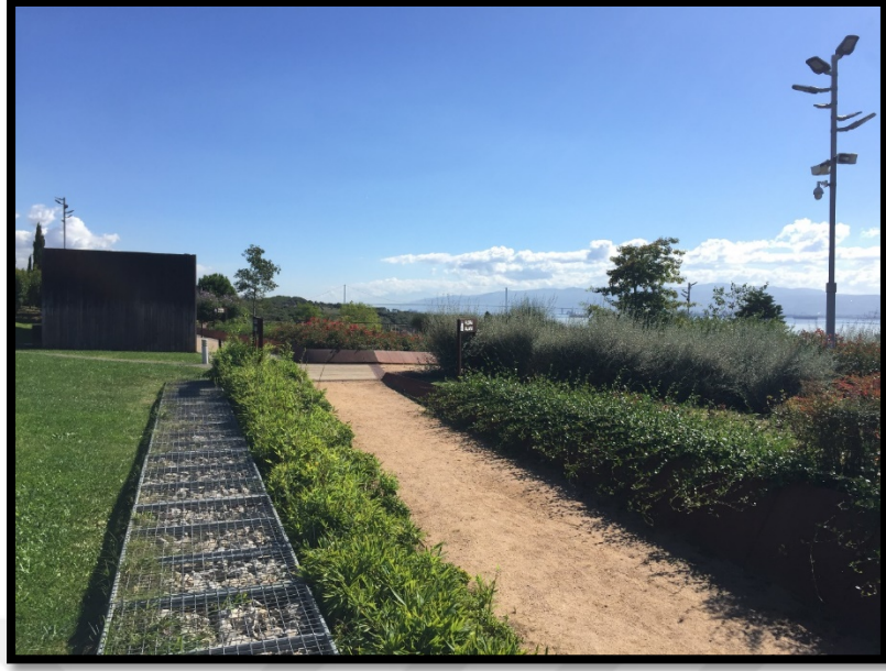
Şekil 11. Park içerisindeki sıkıştırılmış toprak yaya yolu
