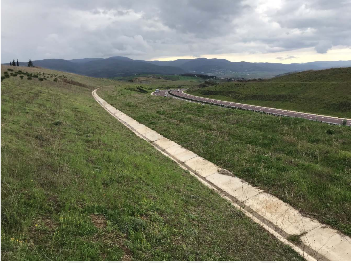
Şekil 9-34 Kabaklı heyelan sahasında oluşturulan şevlerdeki kafa hendekleri
