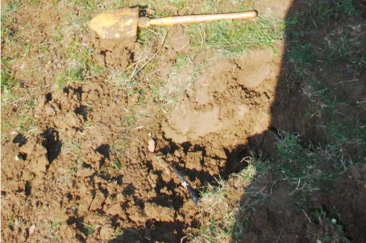
Şekil 7-1. Makaslama örneği alınması için araştırma çukurunun açılması
