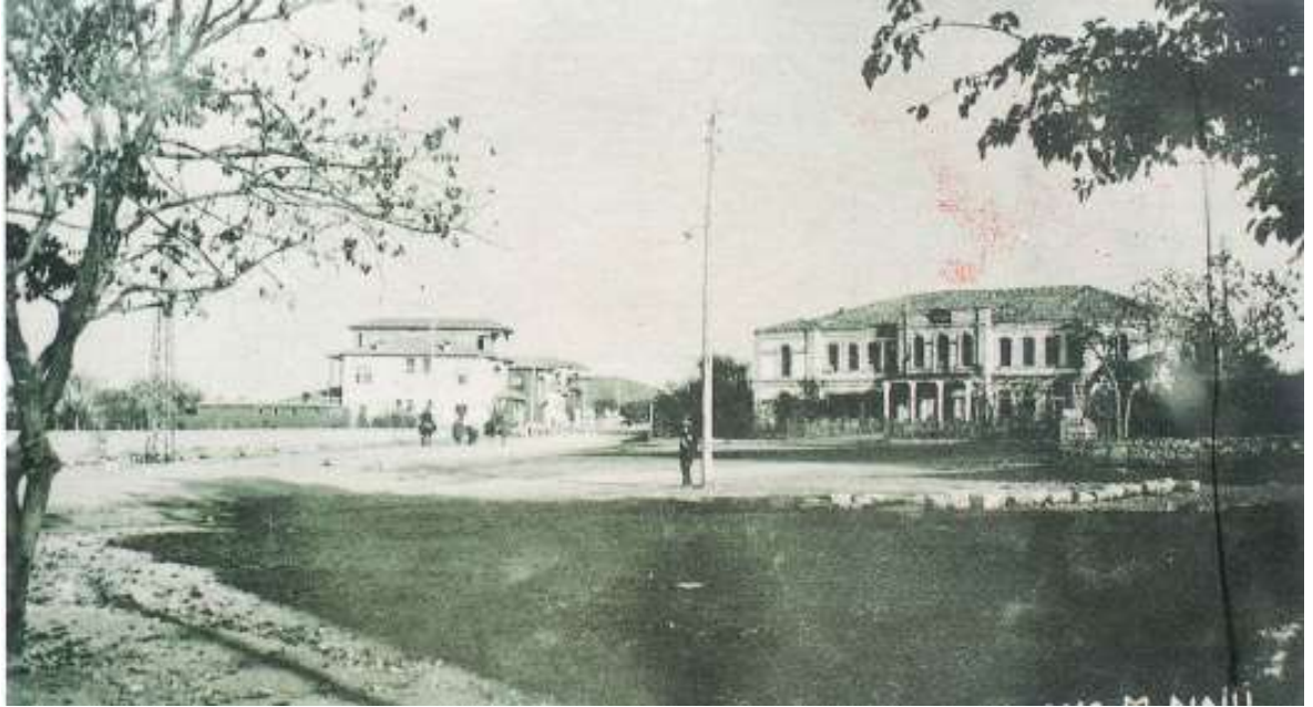
Şekil 1.4. 1930 yılına ait fotoğraf Askerlik Şubesi Binası(Kent Müzesi) ve Vali Konağı Genel Görünüm (Celal Yalvaç Arşivinden aktaran Gögebakan, 2004)
