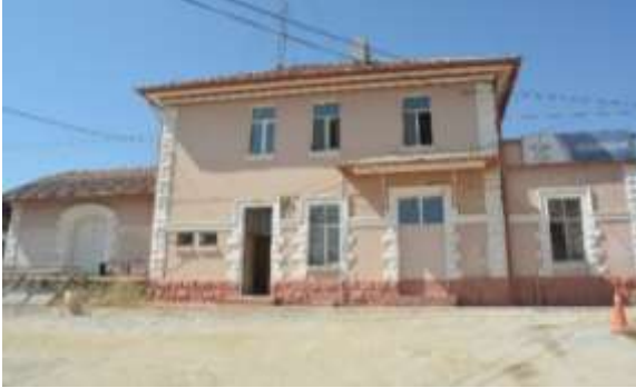
Şekil 4.91.-4.92. Doğanşehir Gar Binası Doğu Cephesi Kapatılan Açıklık ve Özgün Olmayan Elemanlar (2020)
