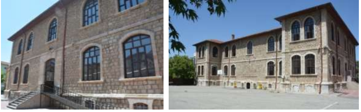
Şekil 4.37.-4.38. Gazi İlköğretim Okulu Güney ve Batı Cepheleri (2019)
