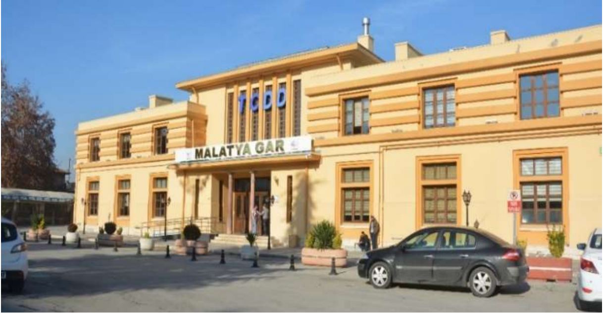
Şekil 4.72. Malatya Merkez Gar Binası Giriş (2019)
