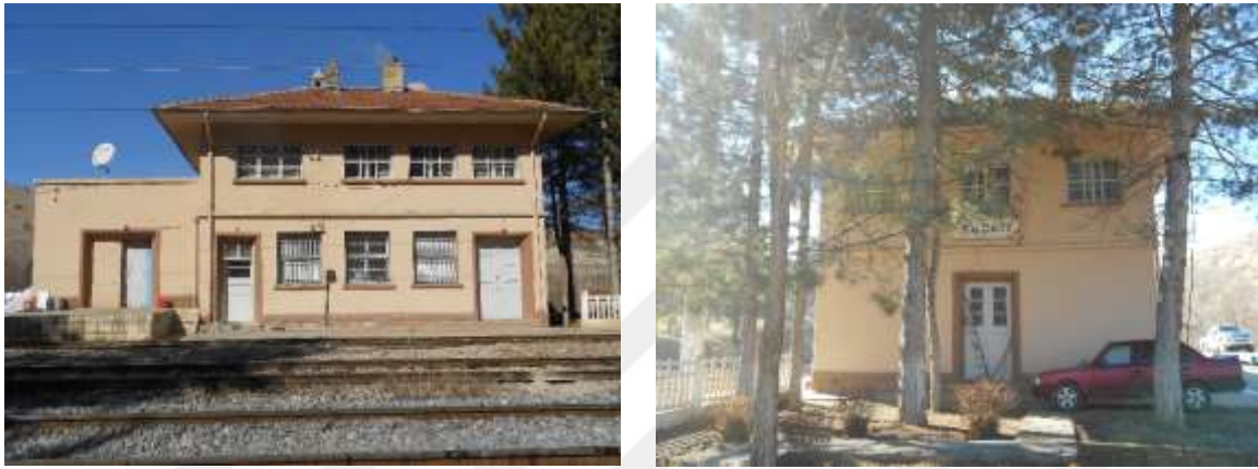
Şekil 5.5. Suçatı Tren Garı (TCDD 5. Bölge Müdürlüğü arşivi)
