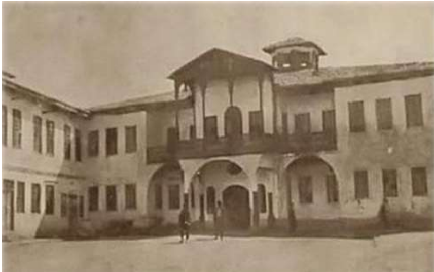
Şekil 4.113. Mutasarrıf Binası (Adnan Işık arşivinden aktaran Demirbağ, 2013).
