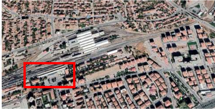
Şekil 4.71. Merkez Gar Binası Hava Fotoğrafı (Google Earth, 2021)
