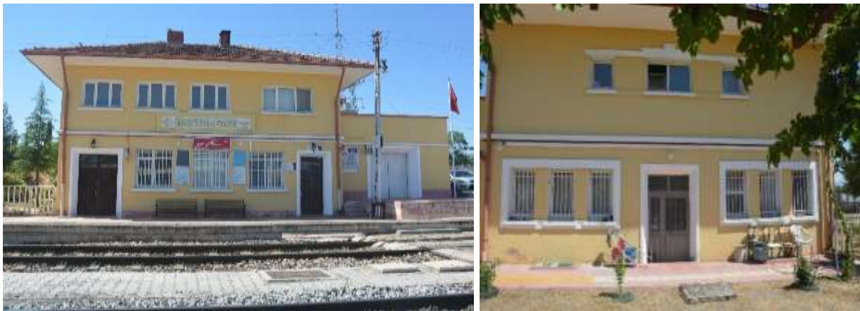
Şekil 4.80-4.81. Battalgazi Gar Binası Güneydoğu ve Kuzeybatı Cephesi (2020)
