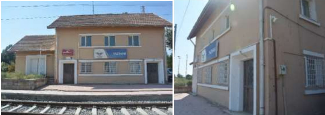
Şekil 4.99. Yazıhan Gar Binası Güneydoğu Cephesi (2020)
