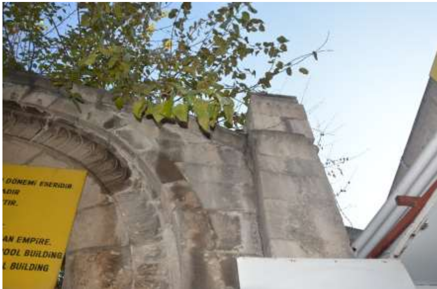
Şekil 4.25. Derme İlkokulu Kapısı Yan Burç (2019)
