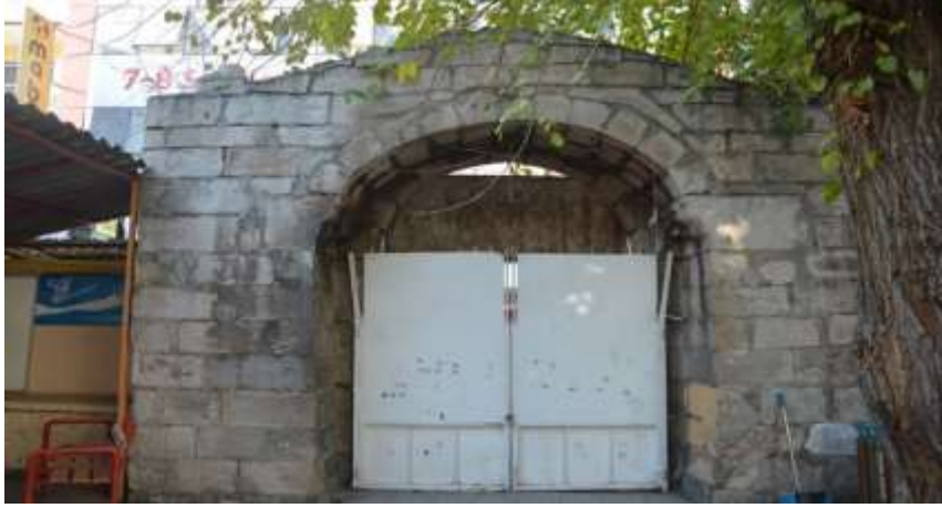
Şekil 4.26. Derme İlkokulu Kapısı Okul Bahçesi Yönü (2019)
