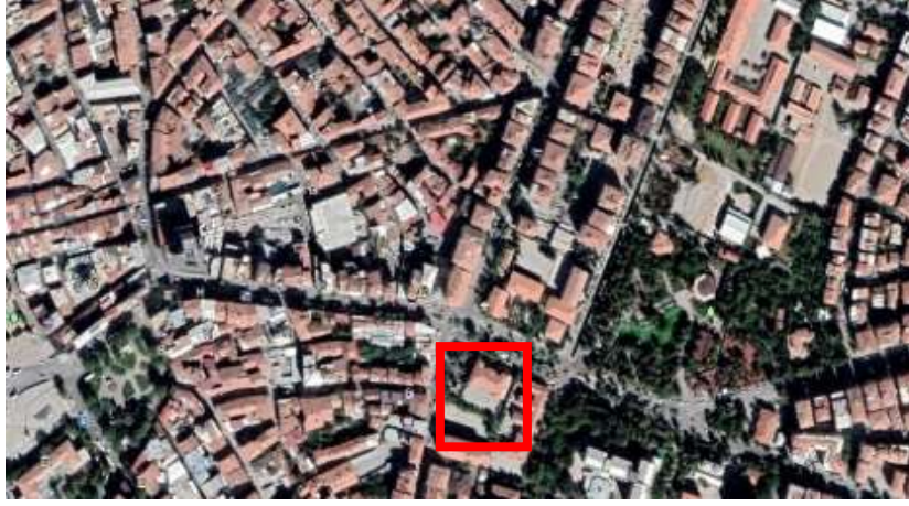
Şekil 4.29. Gazi İlköğretim Okulu Hava Fotoğrafi (Google Earth, 2021)
