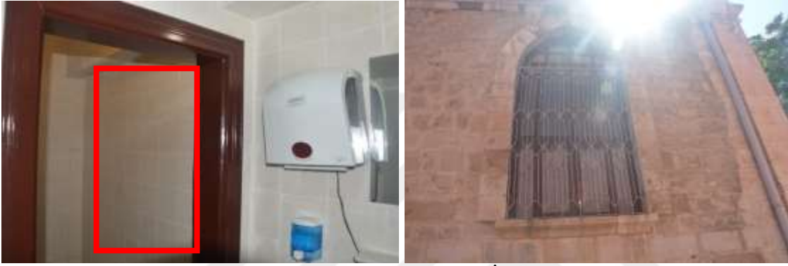
Şekil 4.103. Atatürk Evi Binası Kapatılan Pencerenin İçeriden ve Cepheden Görünümü (2021)
