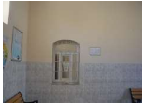
Şekil 4.91.-4.92. Doğanşehir Gar Binası Doğu Cephesi Kapatılan Açıklık ve Özgün Olmayan Elemanlar (2020)
