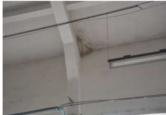
Şekil 4.53.- 4.54. Şehit Kemal Özalper Meslek Lisesi Sıva Dökülmeleri ve Küflenme (2020)
