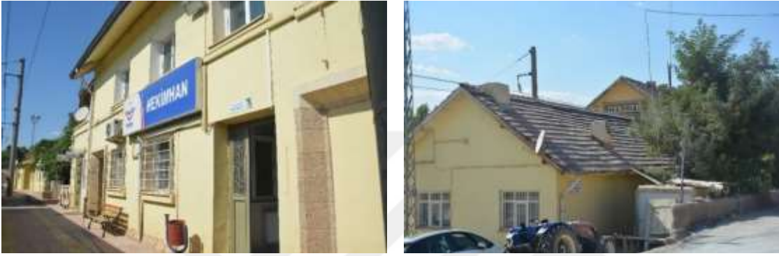
Şekil 4.94.-4.95. Hekimhan Gar Binası Güneydoğu Cephesi ve Depo (2020)
