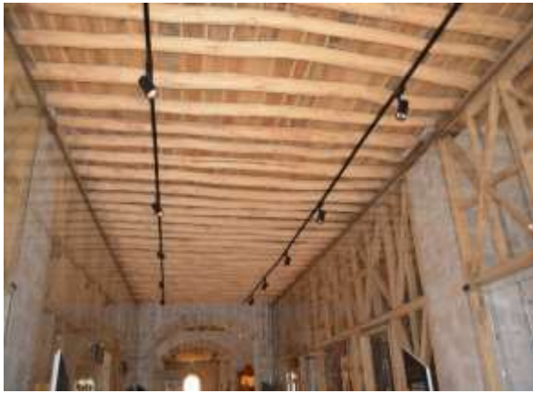
Şekil 4.8.-4.9. Askerlik Şubesi (Kent Müzesi) Koridor ve Oda Döşeme Ahşap Kesitleri (2019)
