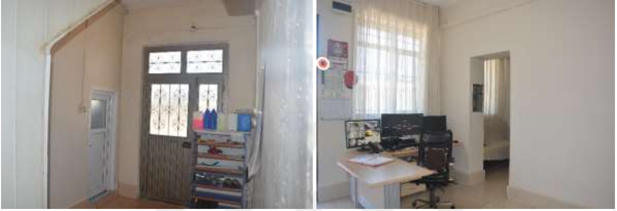
Şekil 4.82.-4.83. Battalgazi Gar Binası Özgün Olmayan Kapı ve Döşeme (2020)
