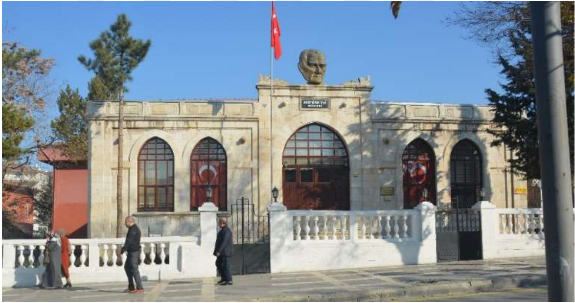
Şekil 4.102. Atatürk Evi Binası Giriş Cephesi (2019)
