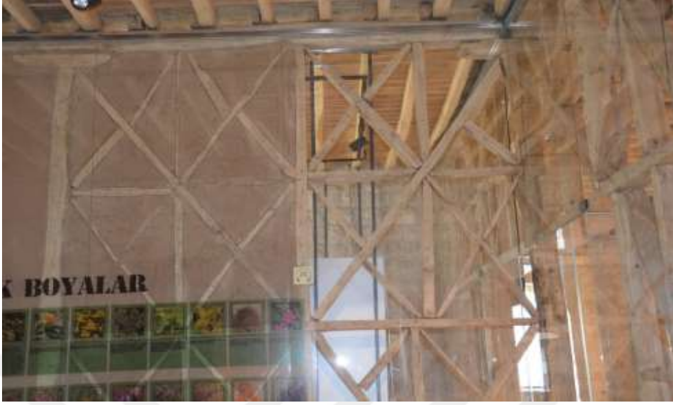
Şekil 4.6. Askerlik Şubesi (Kent Müzesi) Hımsı Tekniği İle İnşa Edilen Duvar (2019)
