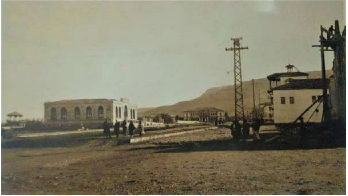
Şekil 1.3. 1927 Yılına Ait Fotoğraf, Sağ Tardafta Gazi Okulu İnşası, Gazi Okulunun Yanında O Dönemde Malatya Ortaokulu ve Çarşı İlk Mektebi Olarak Kullanılan Yapı, Arkada Görülen Günümüz Kent Müzesi ve Fotoğrafın Solunda Yer Alan Yapı Günümüz Atatürk Müzesi (Adnan Işık Arşivinden aktaran Demirbağ, 2013)
