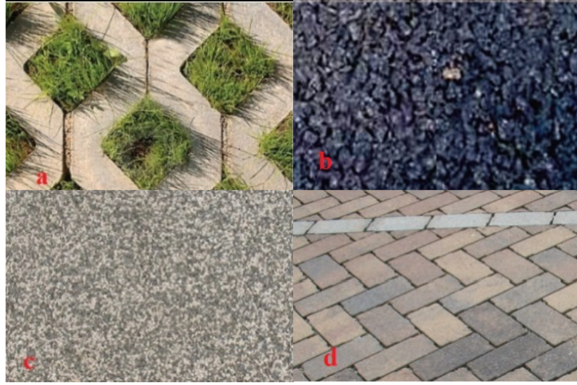
Şekil 1.1 Geçirimli kaplama tipleri: a) Izgara tipi beton parke taşları, b) Geçirimli asfalt, c) Geçirimli beton, d) Geçirimli kilit taşı beton kaplamalar (Tennessee Department of Environment and Conservation [TDEC], 2014)
