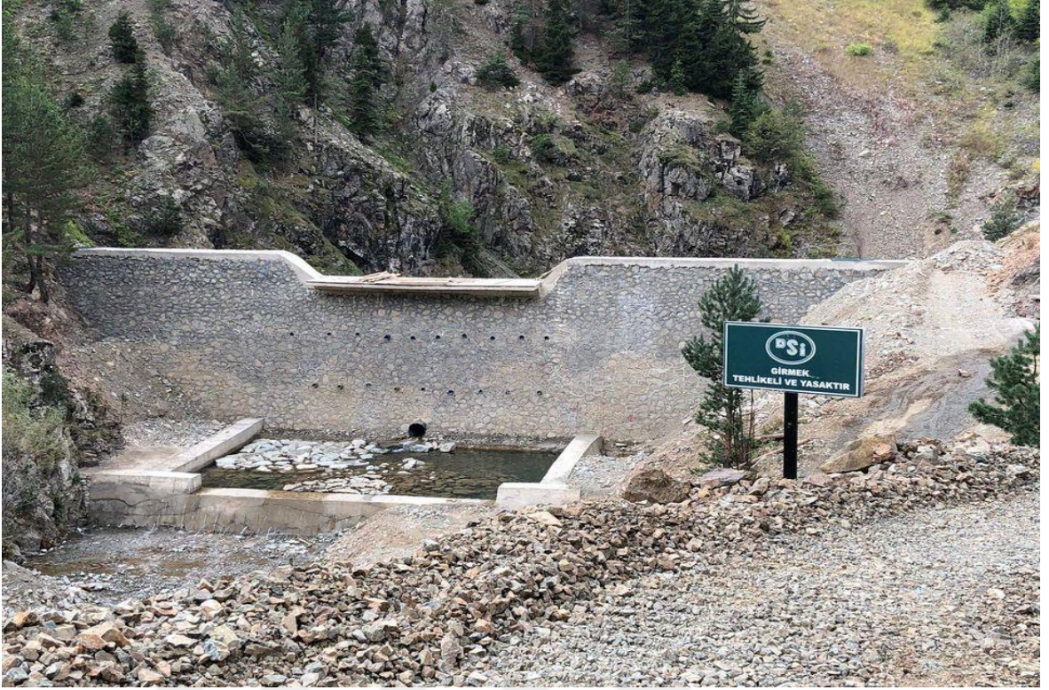
Şekil 1.4. DSİ tarafından inşa edilmiş bir tersip bendi Artvin Yusufeli ilçesi Balalan Köyü (DSİ 26. Bölge Müdürlüğü Web Sitesi)
