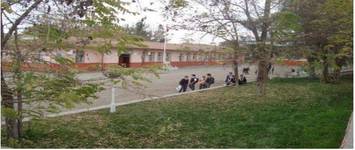
Görsel 6.2. Atatürk ilkokulu eski okul binası (1956).
