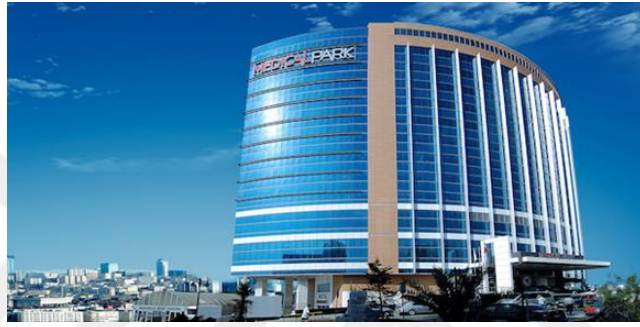
Şekil 17. Perde Blok Örneği (Medical Park Hastanesi)
