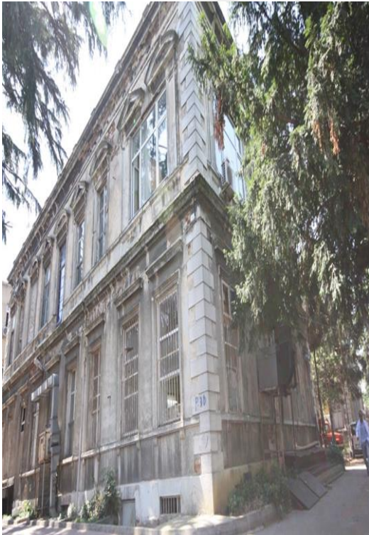
Şekil 32. Binaya Ait Görsel
