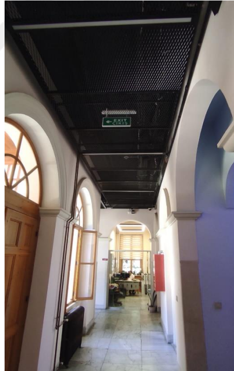
Şekil 49. Görsellerde Eski Hali Ve Restorasyon Sonrası Yapılan Metal Asma Tavan Örneği
