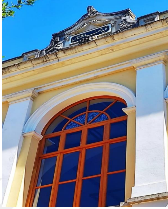
Şekil 30. Binaya Ait Restorasyon Sonrası
