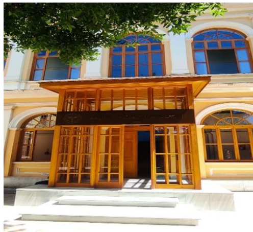
Şekil 37 Binaya Ait Restorasyon Sonrası Giriş Kapısı Görseli
