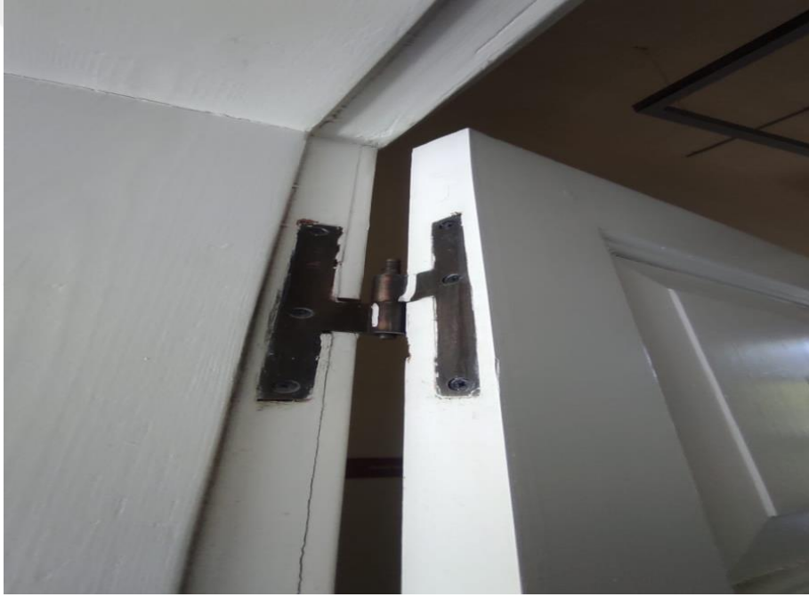
Şekil 42. Sağlam Durumda Olan Kapı Menteşeleri Kullanılmıştır
