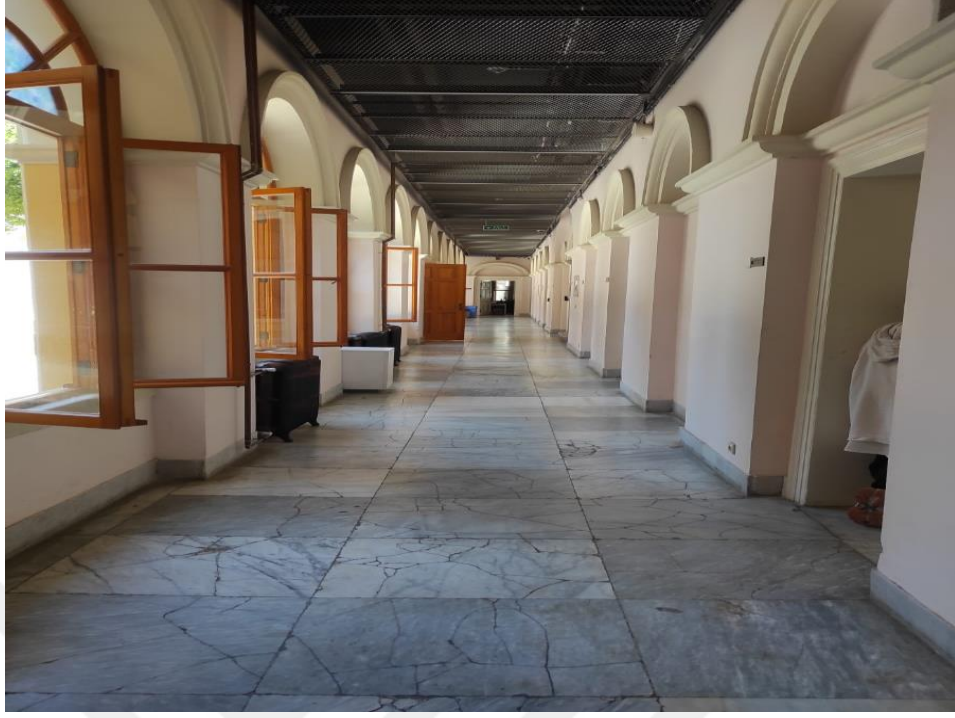
Şekil 47. Pencere Açıklıkları, Duvarların Gücünü Önemli Ölçüde Azaltır
