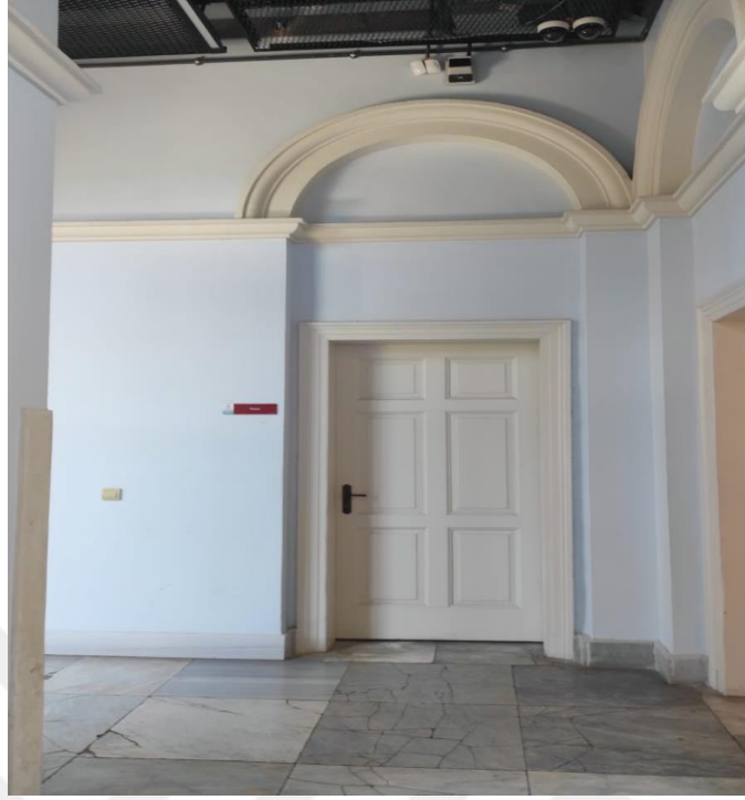
Şekil 43. Restorasyon Sonrası İç Mekan Kapısı
