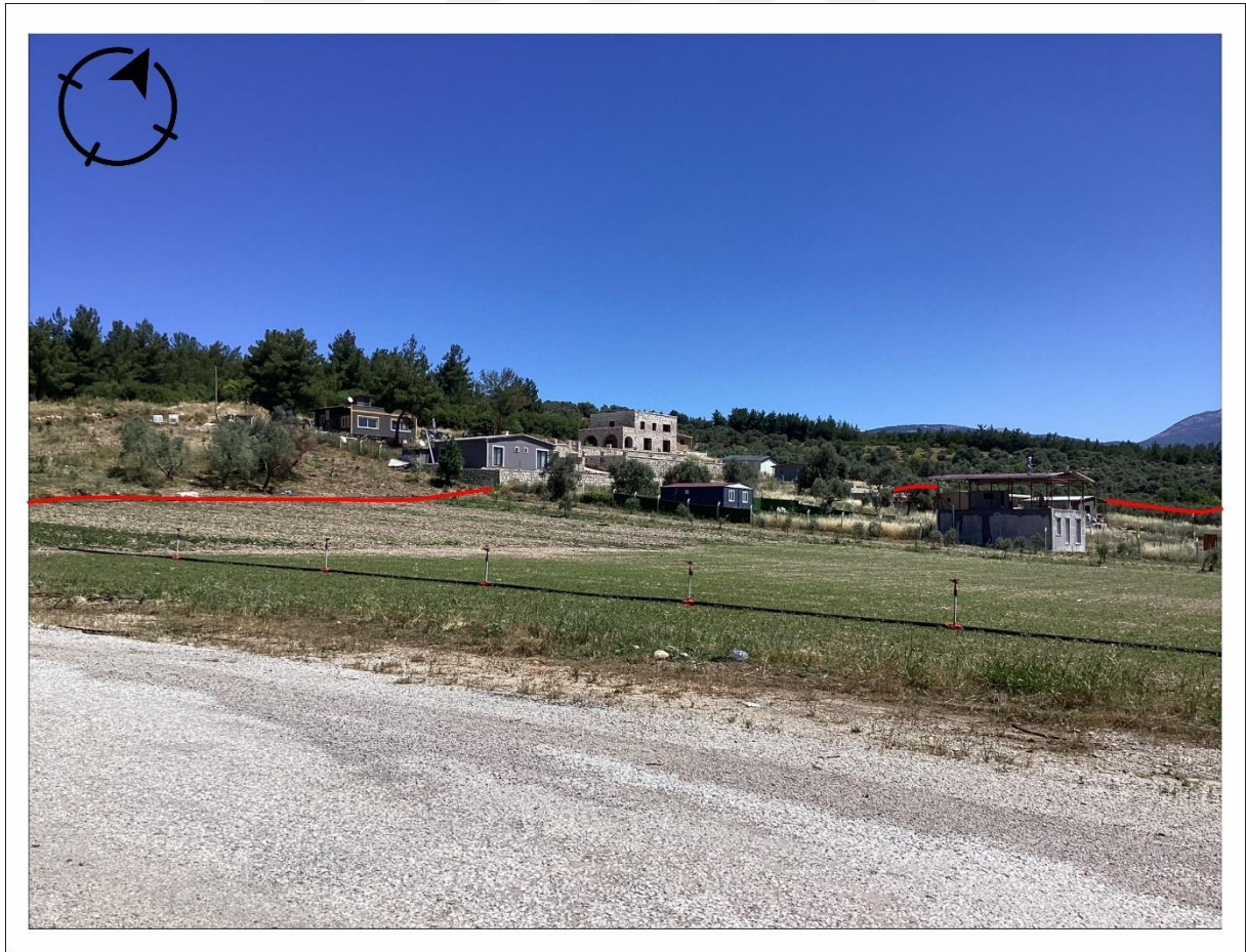
Şekil 5.1. Fay üzerine inşa edilmiş yeni yapılar.
