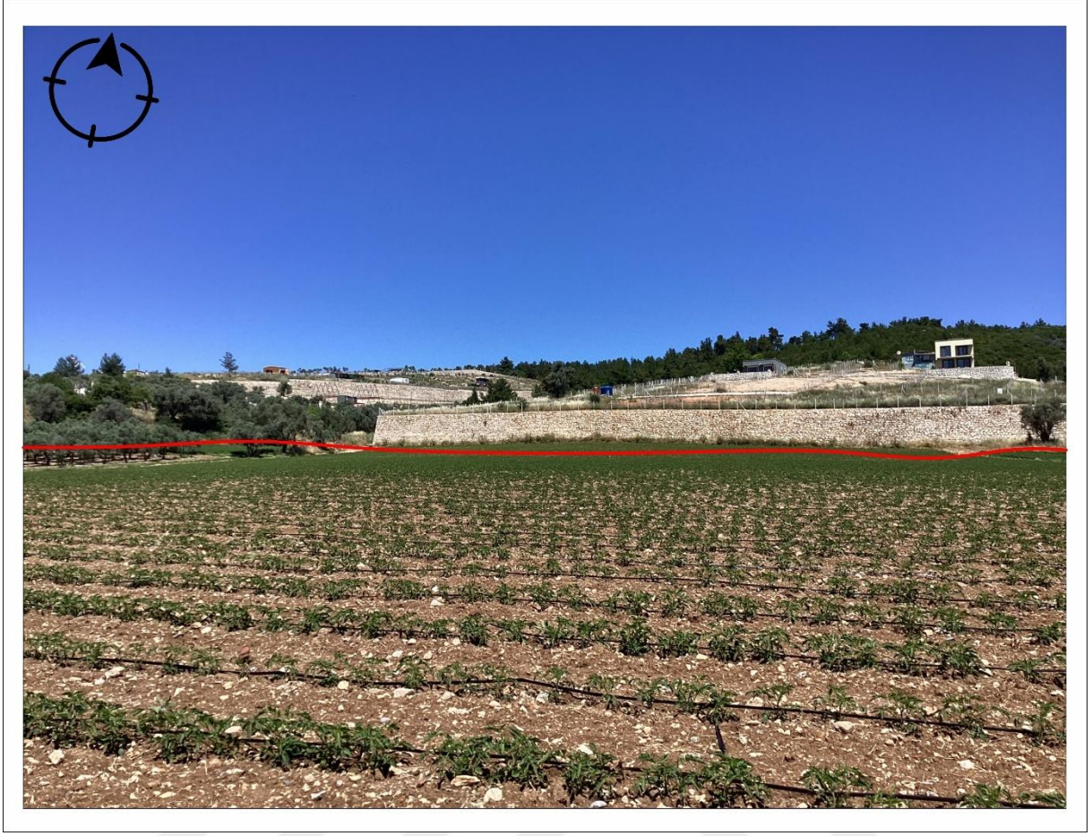
Şekil 5.2. Fay üzerine inşa edilmiş istinat duvarı
