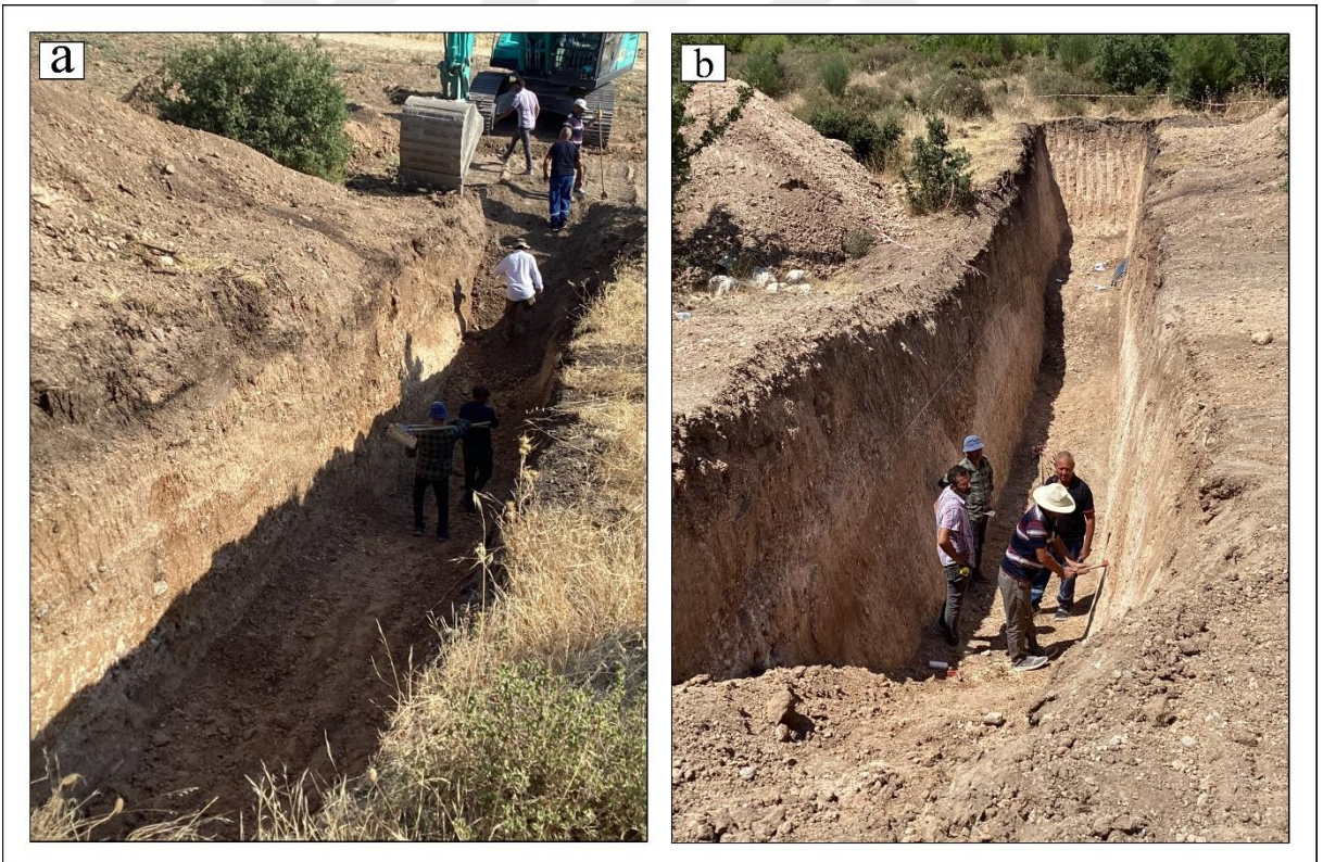
Şekil 2.11. Meşelik Hendeği Duvarlarının Temizlenme Aşaması (A), Girdleme Öncesi Ölçüm İşlemleri (B)
