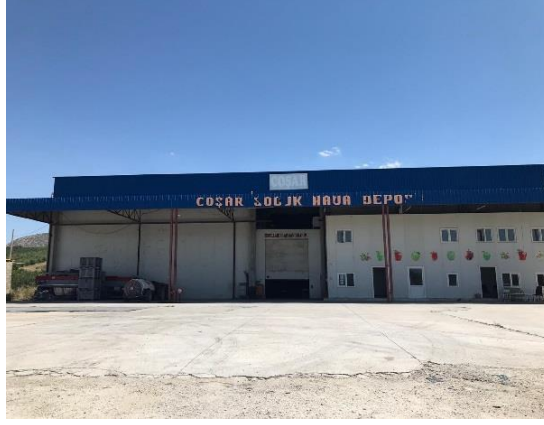
Foto 7. Gelendost’da bulunan Soğuk Hava Deposu
