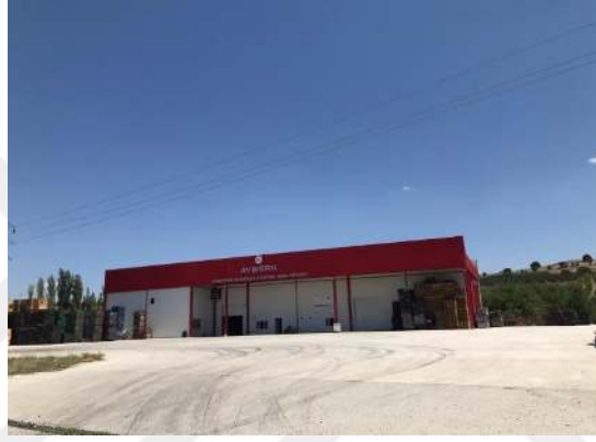
Foto 8. Gelendost Afşar Köyünde bulunan soğuk hava deposu
