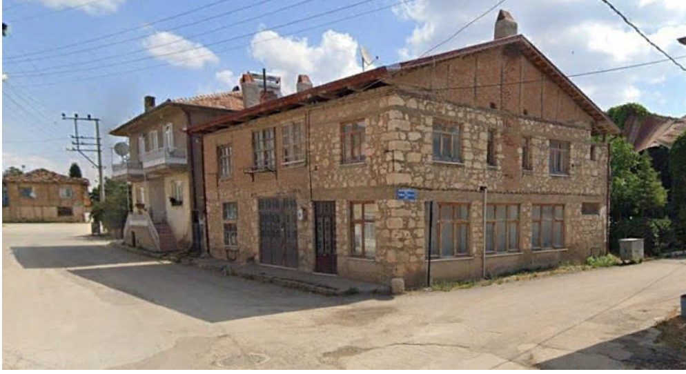
Foto 21. Gelendost Muharrem Mahallesinde bulunan taş ev
