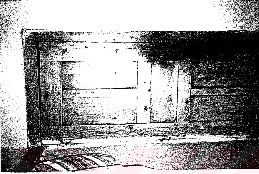
Oda Kapısı Arka Cephesi
