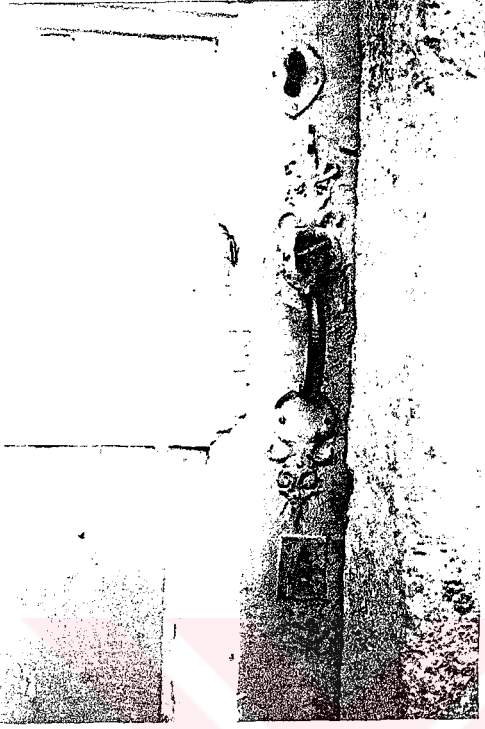
Resim 5.27-28. Giriş Kapılarında Yer Alan Zemberek ve Kapazlama Kilit
