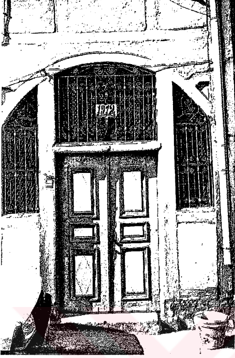
Resim 5.19-20. Afyon Geleneksel Evlerinde Dış Duvarla Aynı Düzlemde Yapılmış Giriş Kapıları
