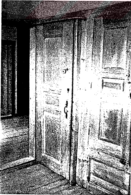
Resim 5.33-34. Afyon Oda Kapılarının Açık Halde Özel Yuvasına Oturması
