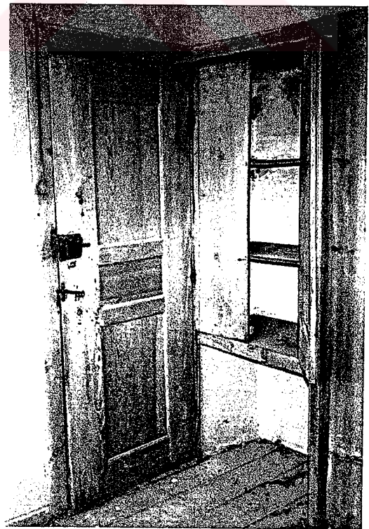
Resim 5.33-34. Afyon Oda Kapılarının Açık Halde Özel Yuvasına Oturması
