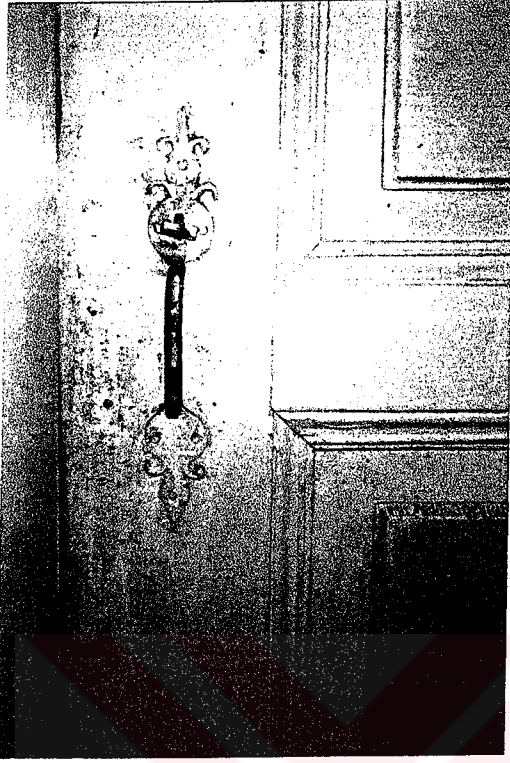
Resim 5.35-36. Oda Kapılarında Zemberek ve Kapazlama Kilit
