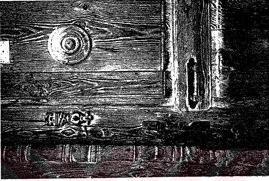
Giriş Kapısı Detayı
