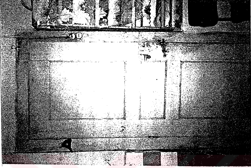
Oda Kapısı Arka Cephesi
