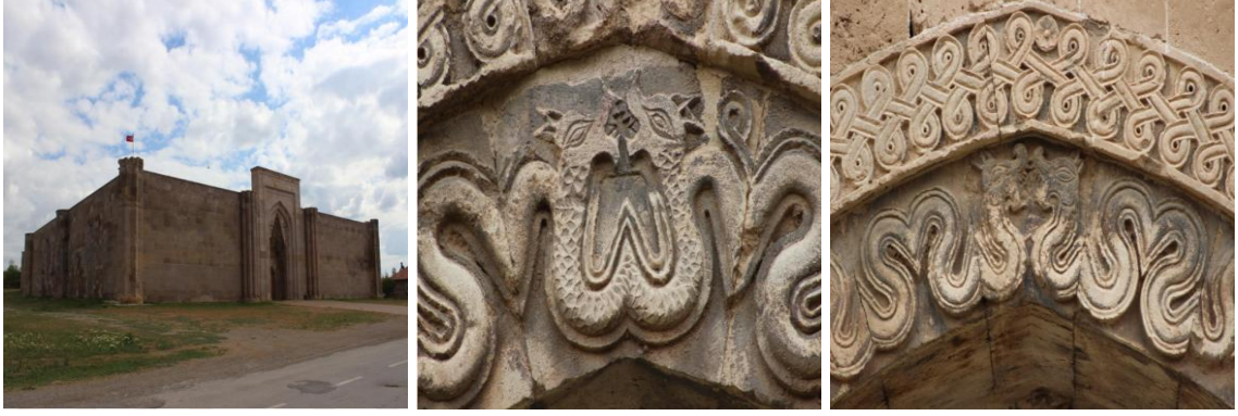
Resim 3. 9. Tuzhisar Sultan Hanı Güneybatı Cephesinden Görünümü.
