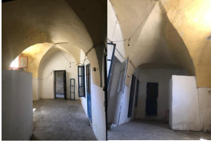
Şekil 6.20 366 Parsel Numaralı Konutun Zemin Kat Eyvan Tonoz Örtülü Odaları
