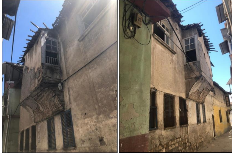
Şekil 2.4 İncelenen 366 parsel numaralı yapı
