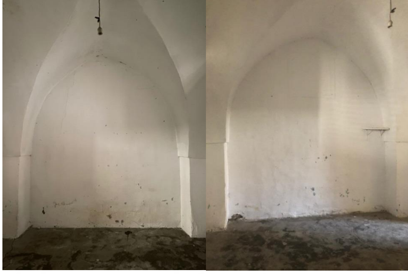
Şekil 6.24 366 parsel numaralı konutun zemin kat duvarları
