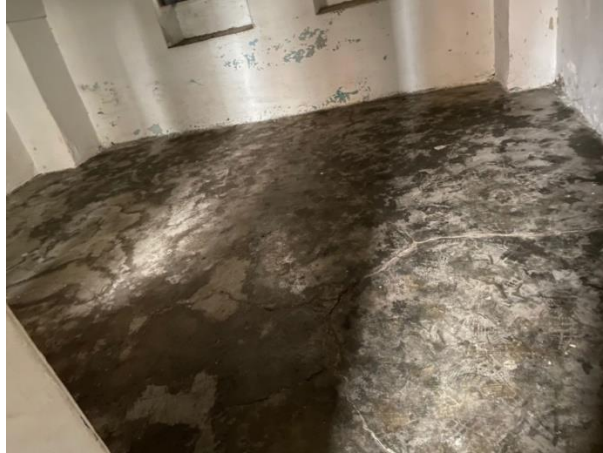
Şekil 6.26 366 parsel numaralı konutun zemin kat şap zemini
