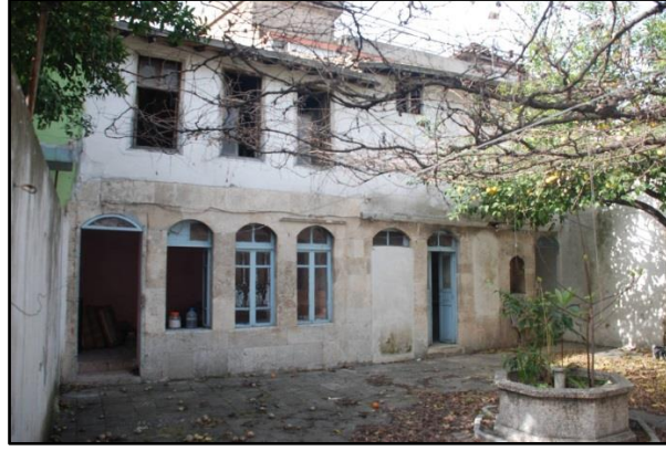
Şekil 6.79 328 parsel yapısı avlu görünümü
