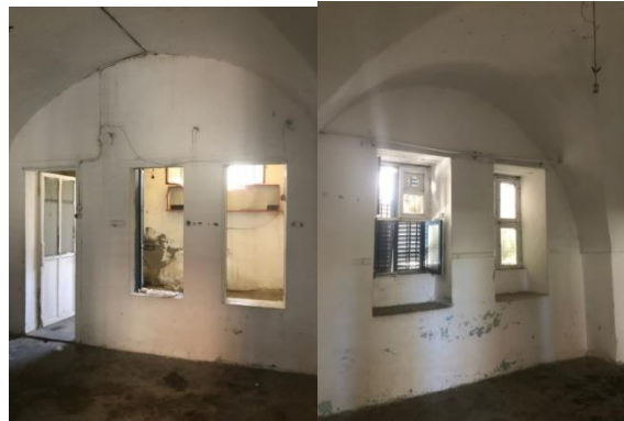
Şekil 6.23 366 Parsel Numaralı Konutun Zemin Kat Tonoz Örtülü Odaları
