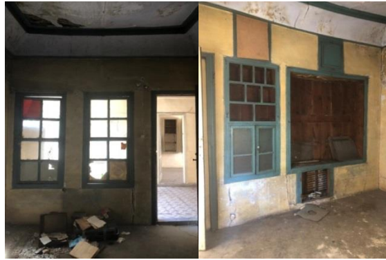
Şekil 6.47 366 parsel numaralı konut 6 numaralı oda pencere ve kapı, kitabiye ve mahmel
