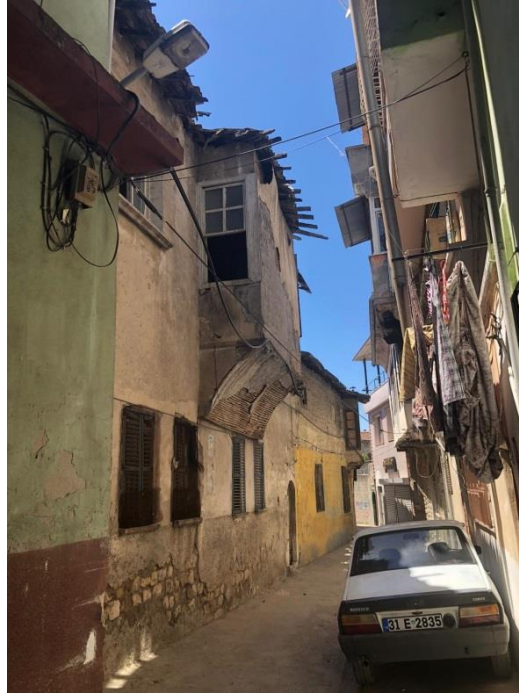
Şekil 6.11 366 Parsel Numaralı Konutun Ayyıldız Sokaktan Görünüşü
