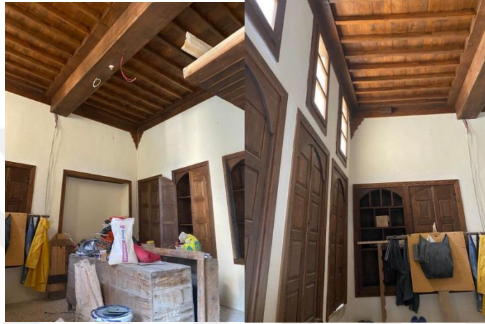
Şekil 6.62 283 parsel yapısına ait iç mekan görüntüsü
