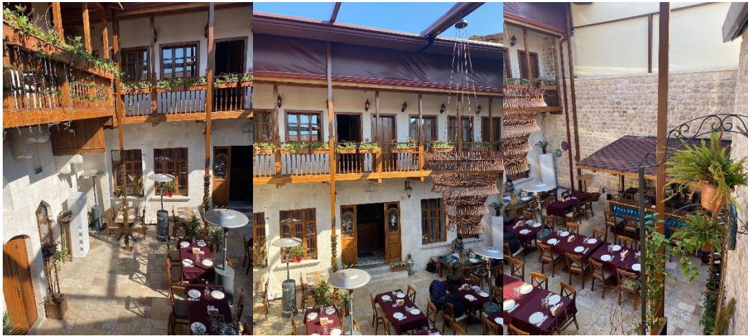
Şekil 6.69 591 parsel yapısına görüntü
