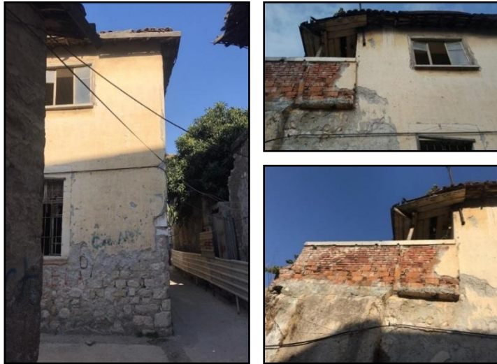
Şekil 2.3 İncelenen 115 Parsel Numaralı Yapı
