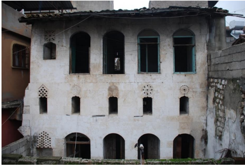
Şekil 6. 56 Ana yapının kuzey doğu cephesi
