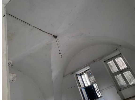
Şekil 6.27 366 parsel numaralı konutun çapraz tonozu
