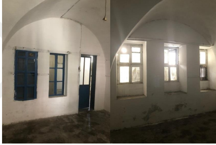
Şekil 6.28 366 parsel numaralı konutun zemin kat odaları, pencereler
