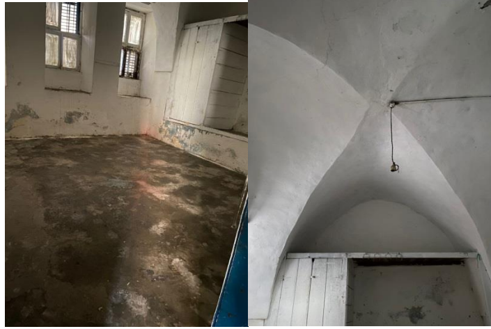
Şekil 6.30 366 parsel numaralı konutun zemin kat odaları şap döşeli zemin, çapraz tonoz
