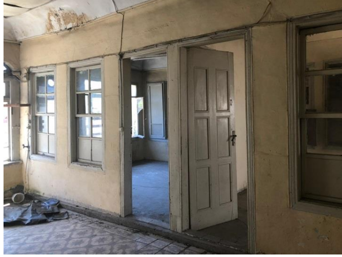
Şekil 6.36 366 numaralı konut orta sofaya açılan odaların kapı ve pencereleri 1.kat
