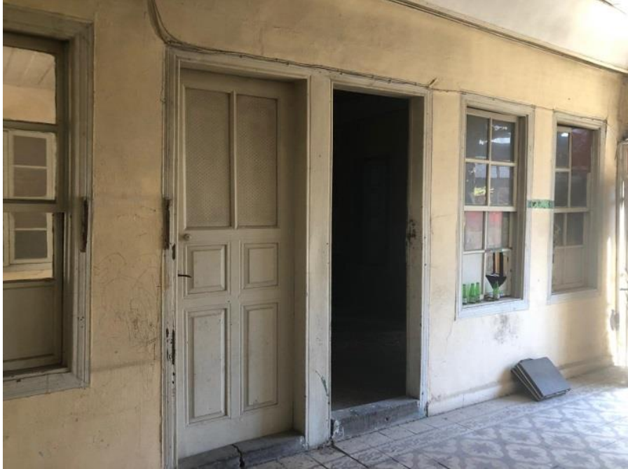
Şekil 6.35 366 numaralı konut orta sofaya açılan odaların kapı ve pencereleri 1.kat
