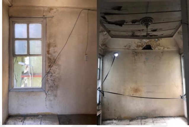
Şekil 6.44 366 parsel numaralı konut cumba pencere ve tavan
