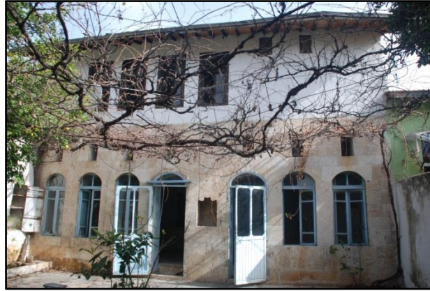
Şekil 6.78 328 parsel yapısı cephe görünümü
