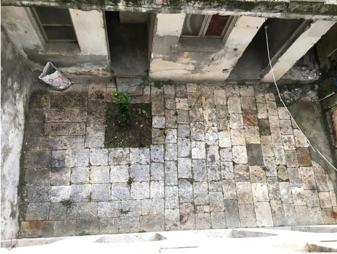
Şekil 6.55 Avlu No:1 görünüşü ve betonarme müştemilat
