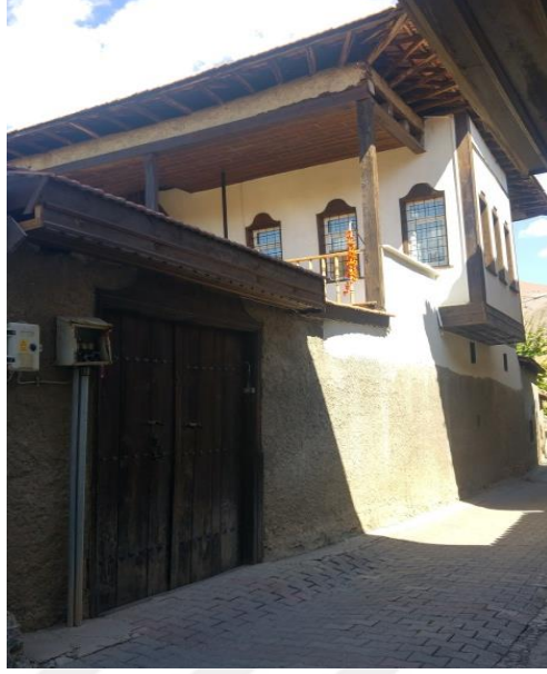
Şekil 3.19. Tapikler Evi Sokaktan Avluya Geçiş Kapısı
