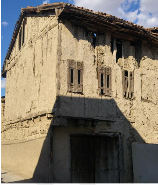
Şekil 3.18. Alanlıoğlu Evi Hımsı Duvarı
