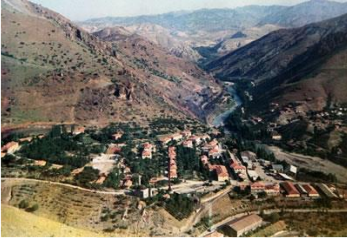
Şekil 3.14. Cüreğir Maden Sitesi (mimarlık dergisi.com 2019)
