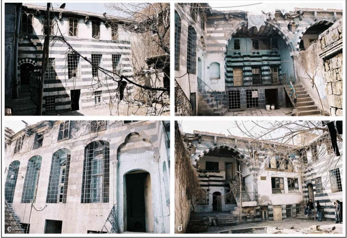
Şekil 4.30. Almaşık duvar tekniğinin kullanıldığı cephe örnekleri (Dalkılıç fotoğraf arşivi)
