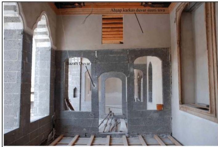
Şekil 5.1. Bazalt duvar üzeri ahşap karkas duvar örneği (Dalkılıç fotoğraf arşivi)
