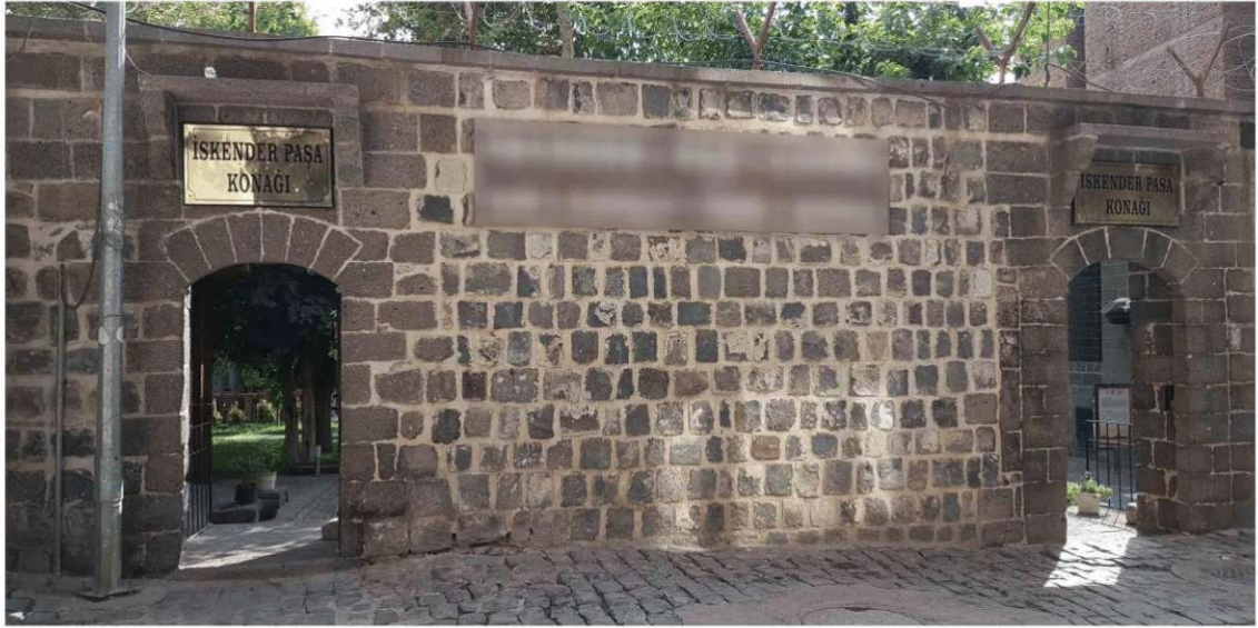
Şekil 4.10. Kaba yonu taşın avlu bahçe duvarında kullanılması
