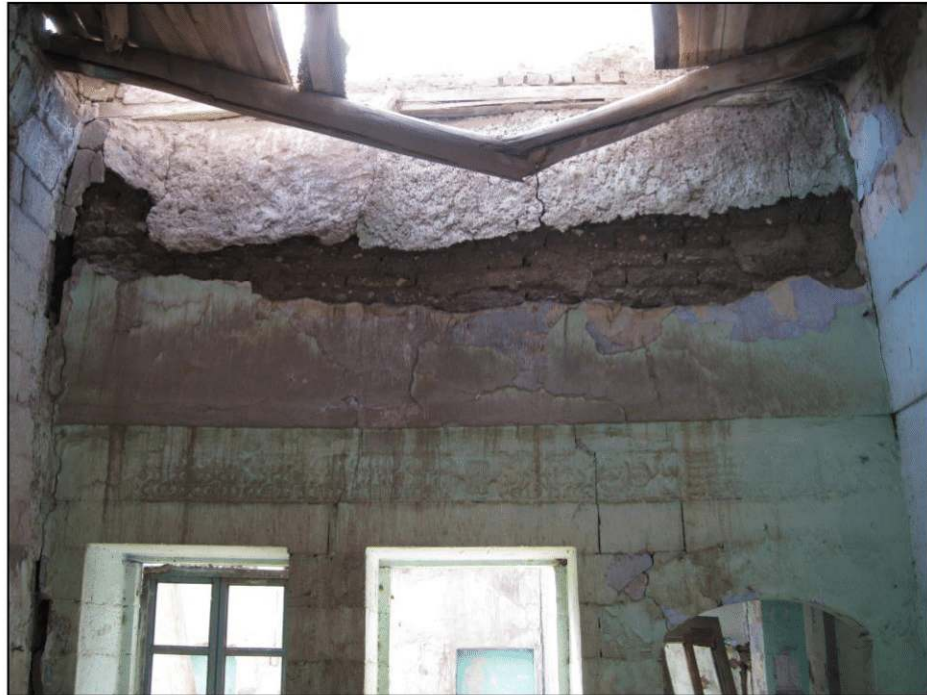
Şekil 4.45. Kerpiç malzemenin kullanıldığı pencere üst kısımları
