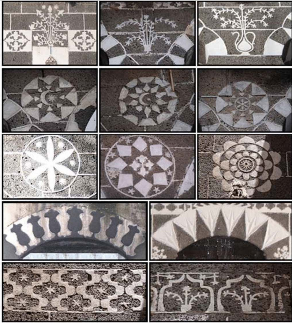
Şekil 3.7. Cas sıva ile yapılan cephe süslemeleri (Dalkılıç ve Bekleyen 2011)
