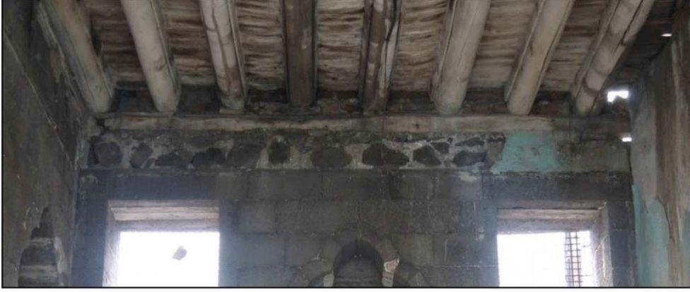
Şekil 4.9. Pencere üstlerinde moloş taş kullanım örneği
