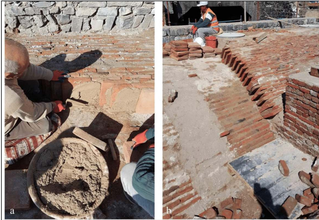
Şekil 4.115. Geleneksel yöntemler tonoz yapım aşamaları
