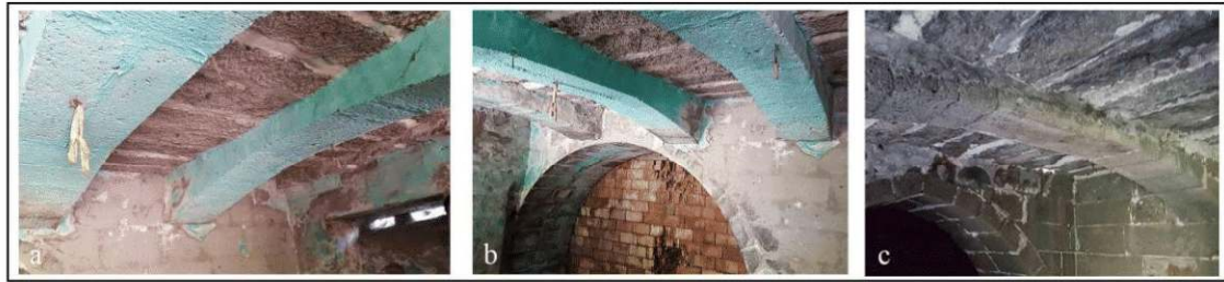
Şekil 4.54. Sal taşlı döşeme ve taş kemer örnek resimler
