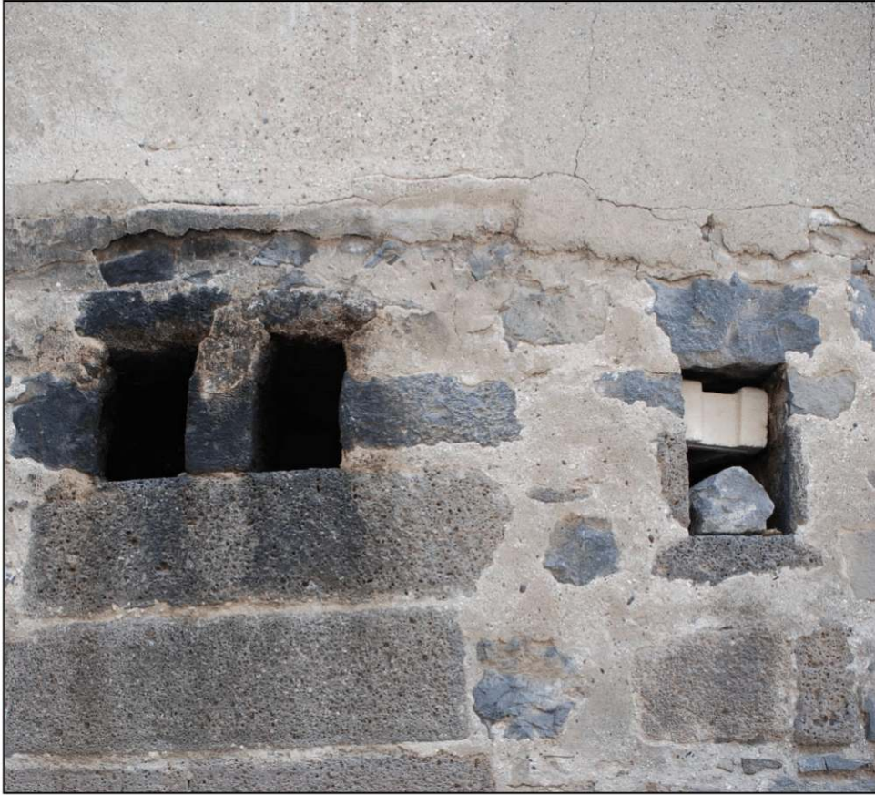
Şekil 4.180. Sokak cephesinde bacaların duman çıkış noktaları
