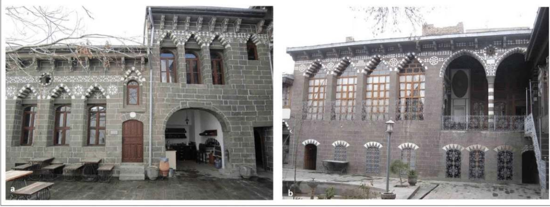
Şekil 4.15. İnce yonu taşın kullanıldığı cephe örnekleri. Ahmet Arif Evi Müzesi (a), Cahit Sıtkı Tarancı Evi kuzey cephesi (b) (Dalkılıç fotoğraf arşivi)
