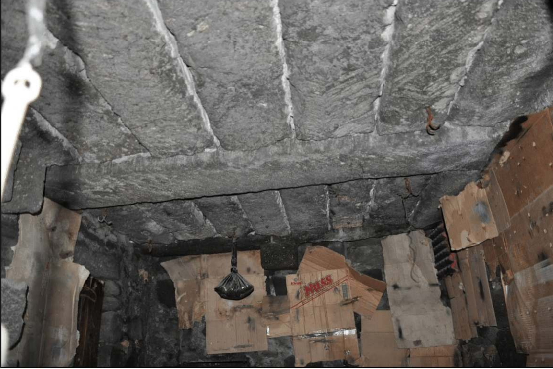
Şekil 4.62. Sal taşı ile düz kiriş tekniğiyle yapılan zemin kat döşeme örneği
