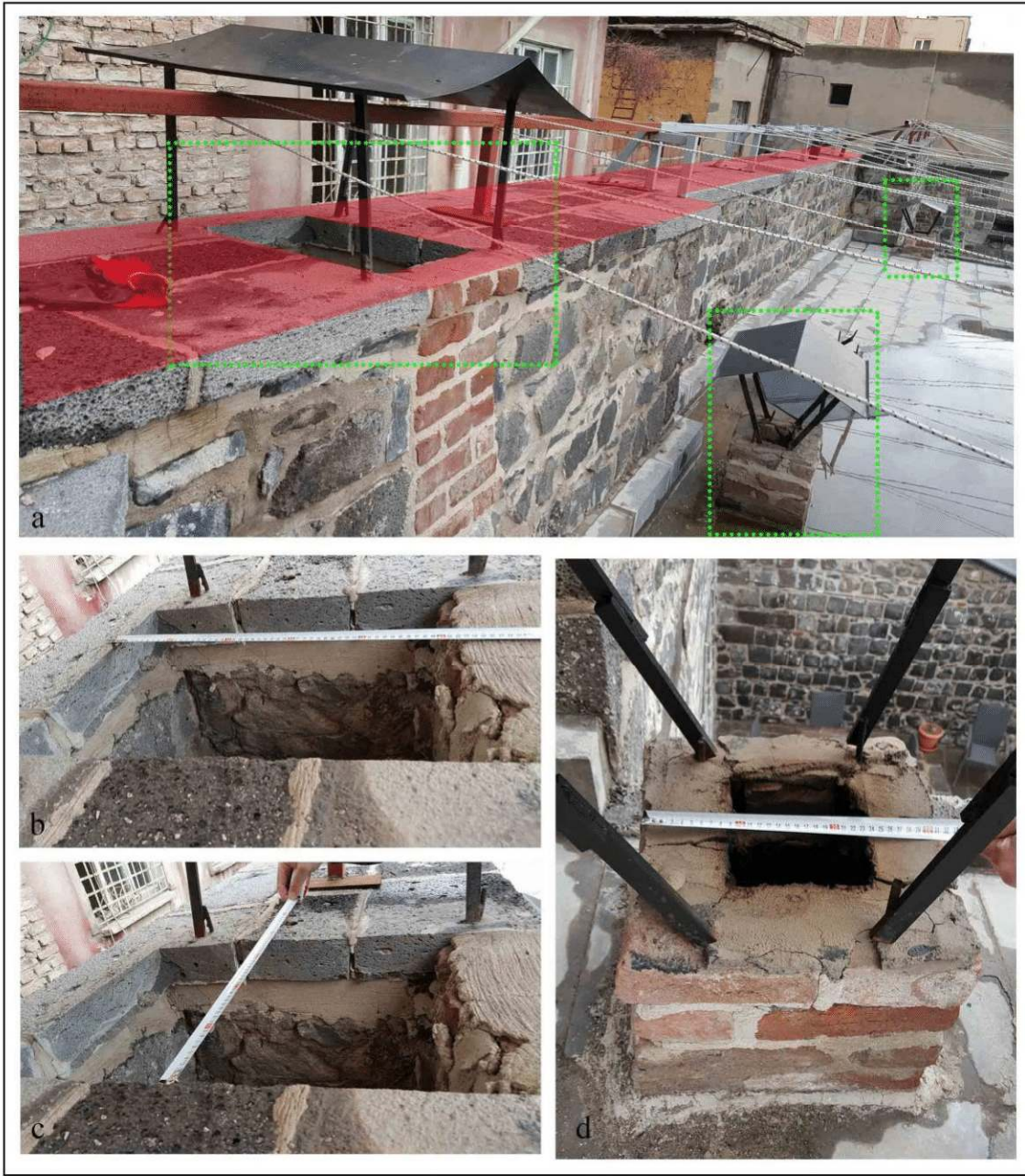
Şekil 4.182. Damdan tahliye edilen duman baca örnekleri
