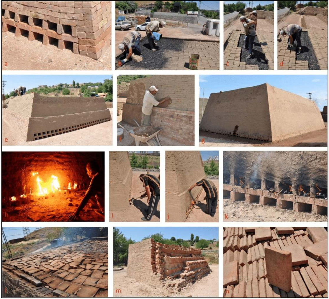
Şekil 4.38. Harman tuğlası fırınının kurulması ve yakılması (Dalkılıç ve Nabikoğlu 2017)
