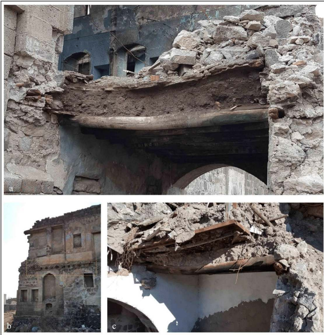
Şekil 4.65. Döşeme katmanlarının incelenmesi
