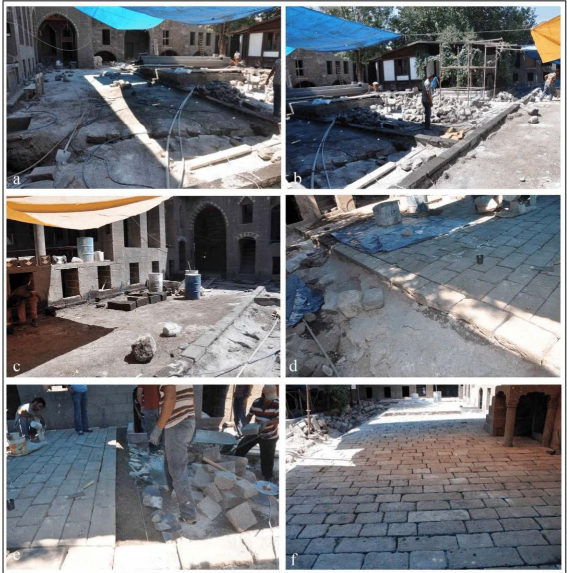
Şekil 4.79. Avlu döşemesi yapımı örnek resimleri (Dalkılıç fotoğraf arşivi)
