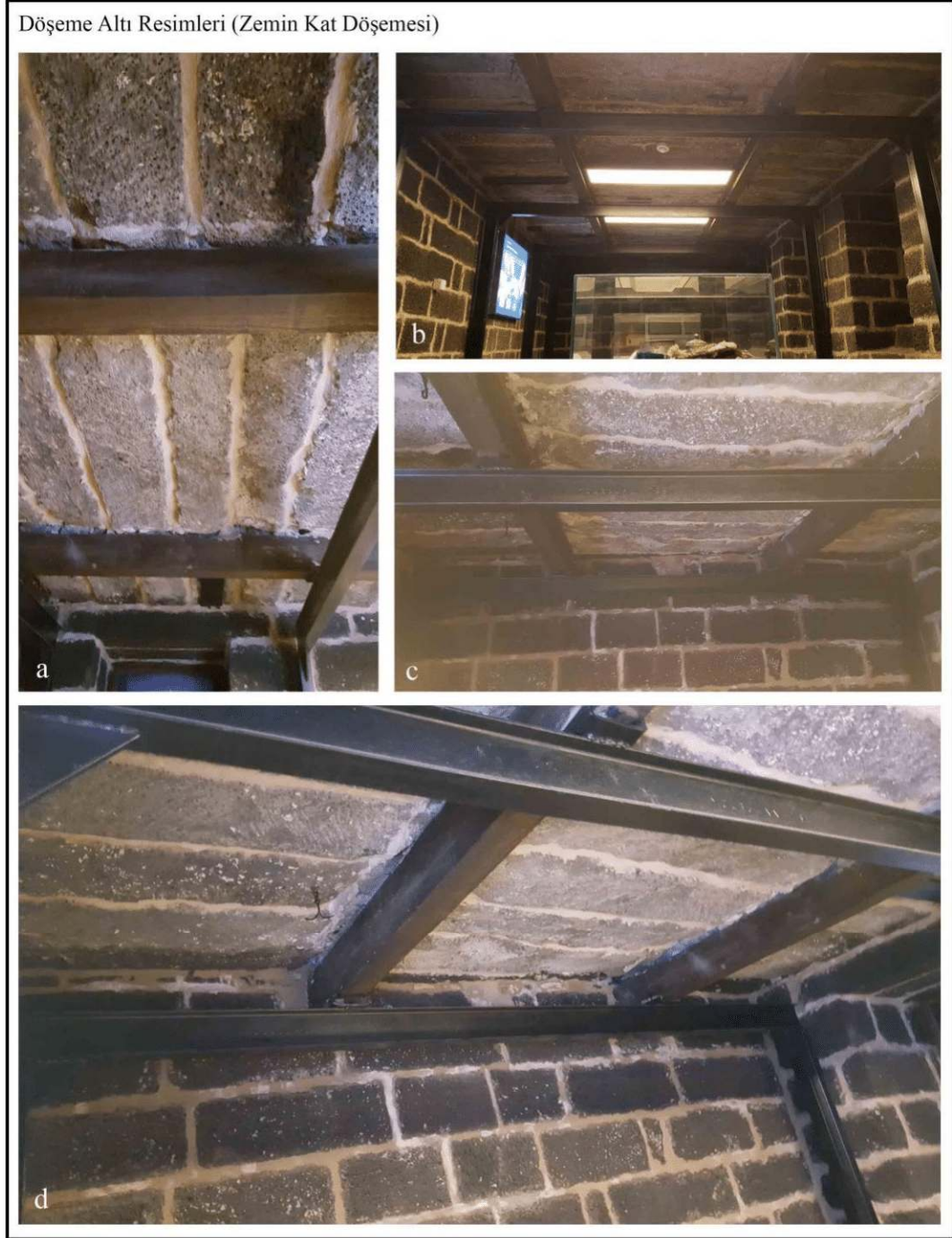
Şekil 4.56. Ziya Gökalp Müzesi bazalt döşemesinin alt bodrum kattan görünümü
