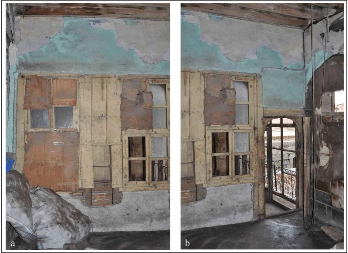
Şekil 4.36. Ahşap karkas (bağdadi) ara bölme duvar örnekleri (Ada 409 Parsel 11, 2015)
