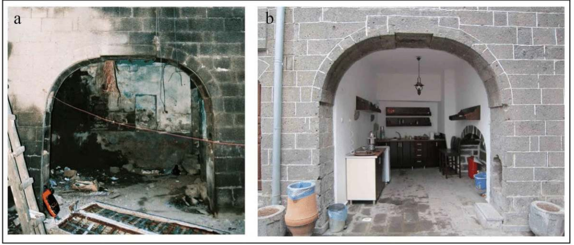
Şekil 4.143. Diyarbakır geleneksel evlerinde bulunan bursa kemerı örnekleri
