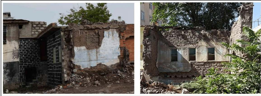
Şekil 4.43. Kerpiç malzemenin kullanıldığı yapı örneği
