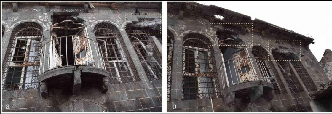
Şekil 4.16. İnce yonu bazaltının cephede detay fotoğrafı
