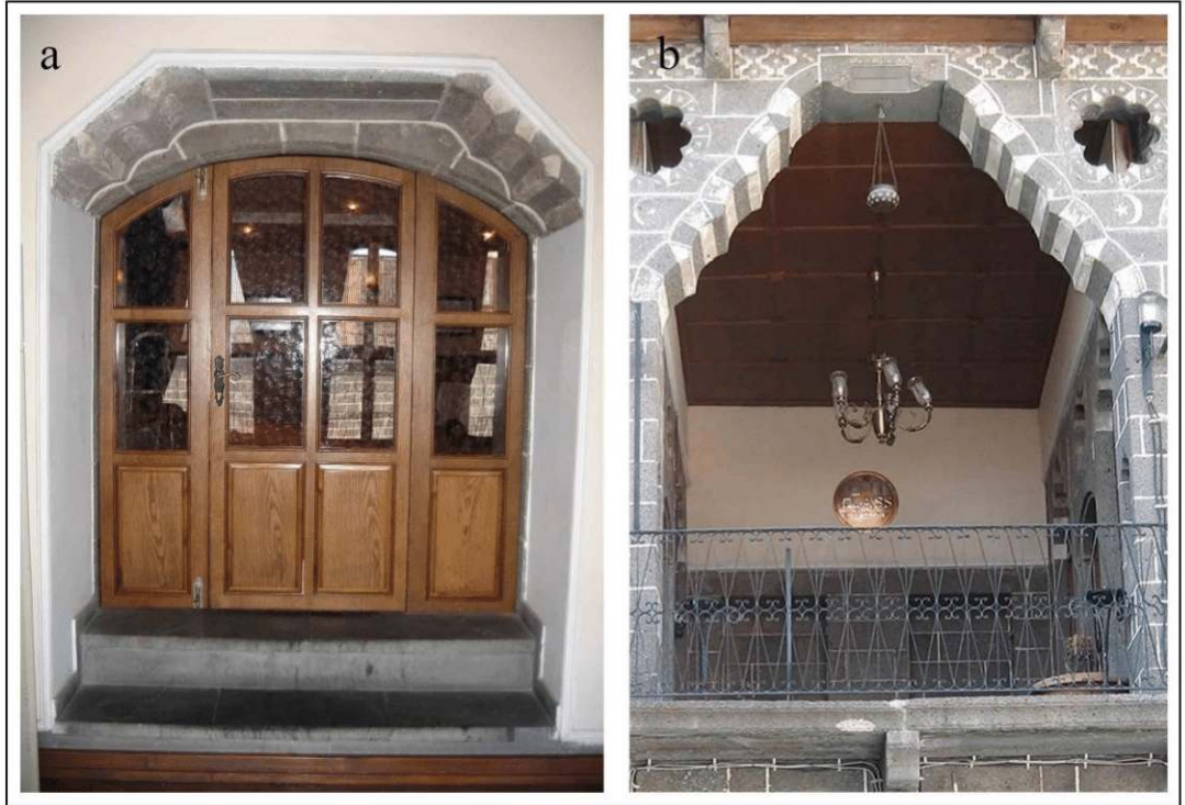
Şekil 4.132. Altı dilimli köşeli kemer ve on dilimli köşeli kemer örneği
