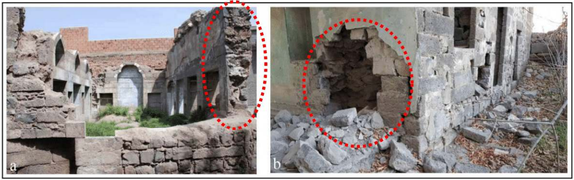
Şekil 4.27. Sandık duvar tekniğinin belirgin olarak görüldüğü detay fotoğrafları
