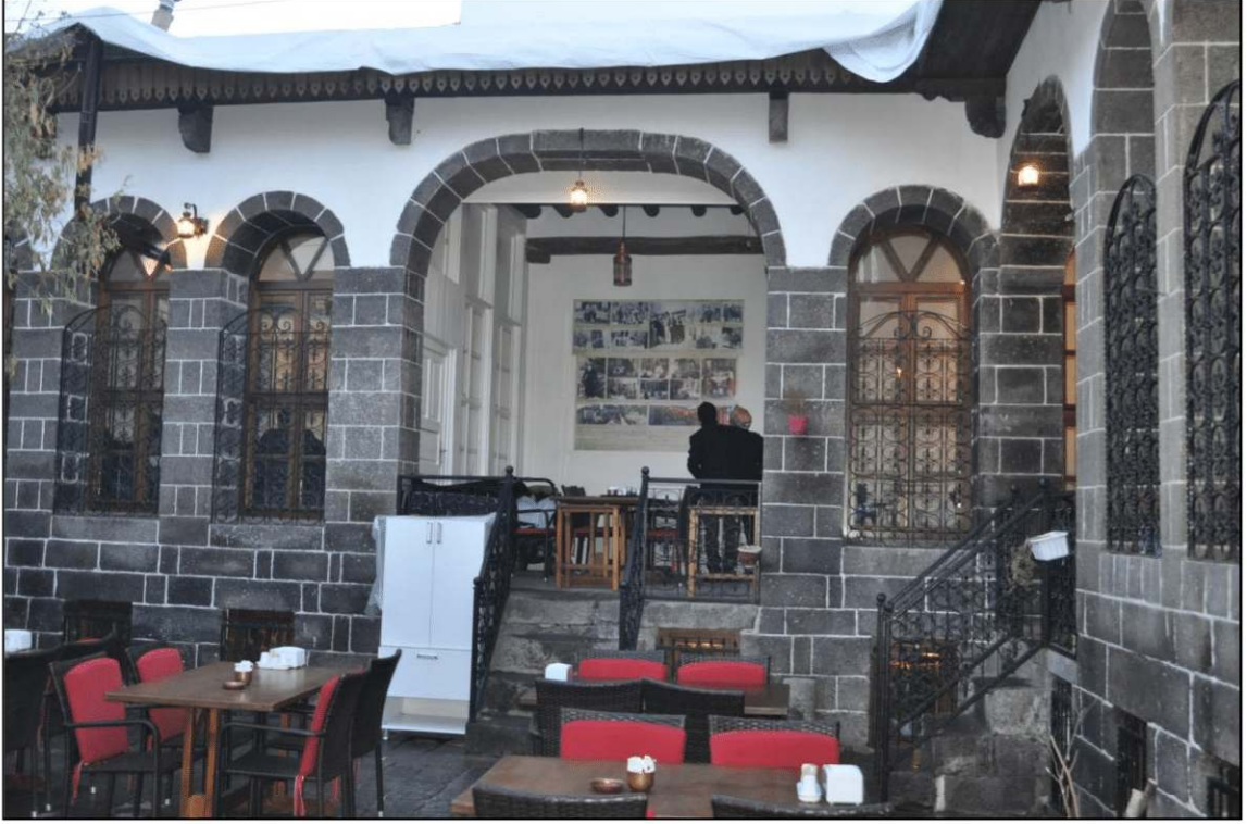
Şekil 4.13. İnce yonu taşın kullanıldığı avlu cephesi görünüşü. (Diyarbakır Evi, Ada 380 Parsel 11)
