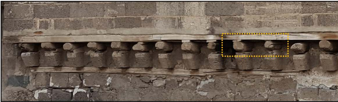
Şekil 4.73. Taş bingi üzerine, ahşap kiriş detayı
