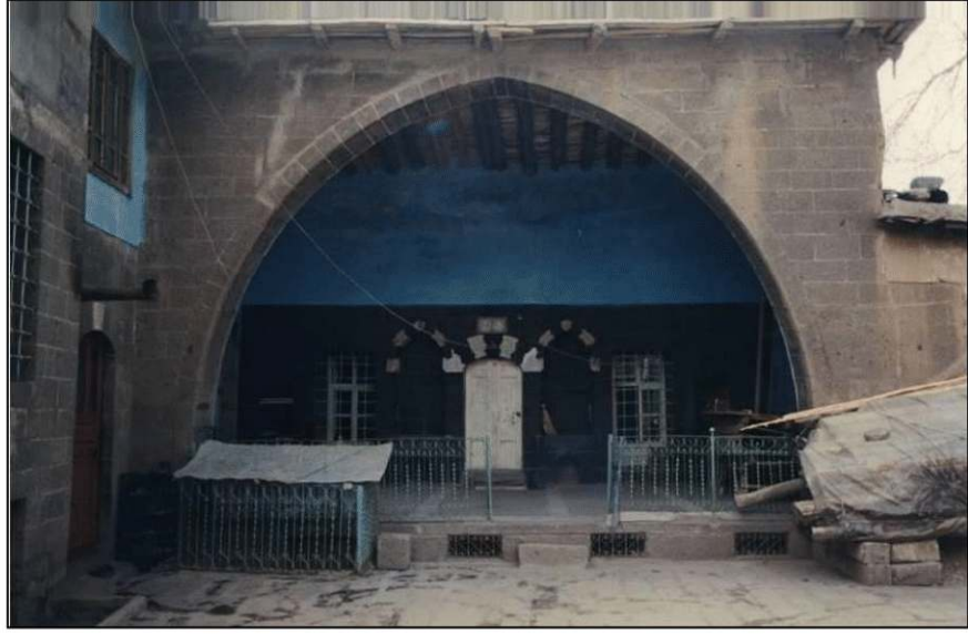
Şekil 4.131. Diyarbakır geleneksel evlerinde bulunan tek gözlü en geniş açıklıklı kemer (Dalkılıç Fotoğraf arşivi)
