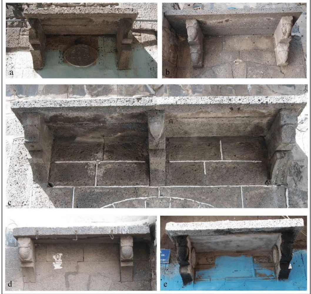
Şekil 4.236. Sokak giriş kapıları üzeri saçak yapımı (Dalkılıç fotoğraf arşivi)
