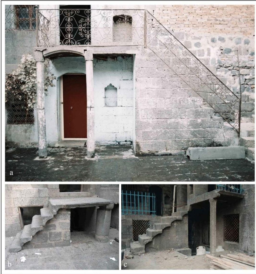
Şekil 4.167. Diyarbakır geleneksel evleri taş dolgu destekli merdiven örnekleri (Dalkılıç fotoğraf arşivi)
