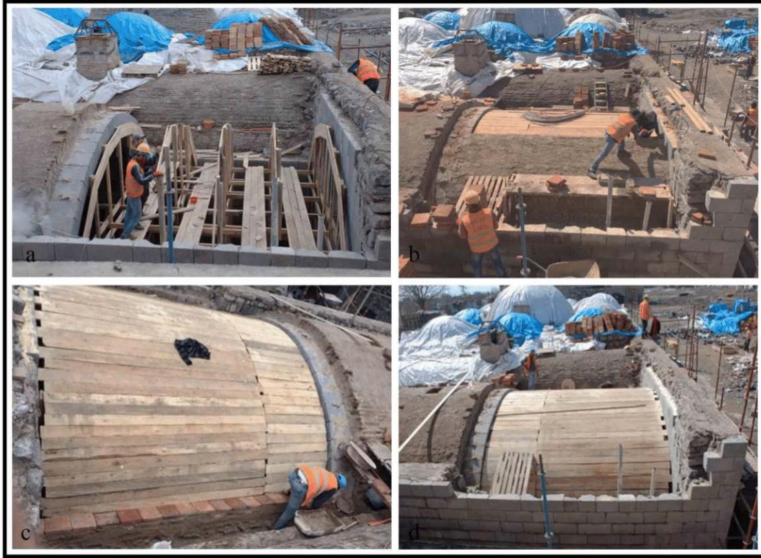
Şekil 4.114. Geleneksel yöntemler ile yapılan tonoz yapım aşamaları (Dalkılıç fotoğraf arşivi)
