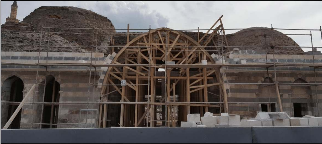
Şekil 4.119. Kemer yapım örneği (Restorasyon çalışmaları )
