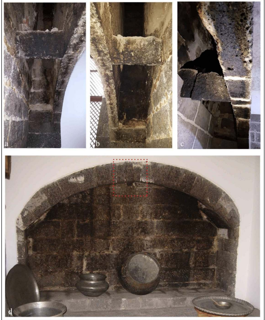
Şekil 4.177. Bağlayıcı destek taşı detay resimleri
