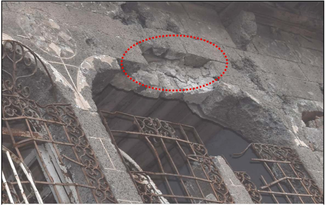
Şekil 4.28. Sandır duvar örgü tekniğinin belirgin olarak görüldüğü detay fotoğrafı
