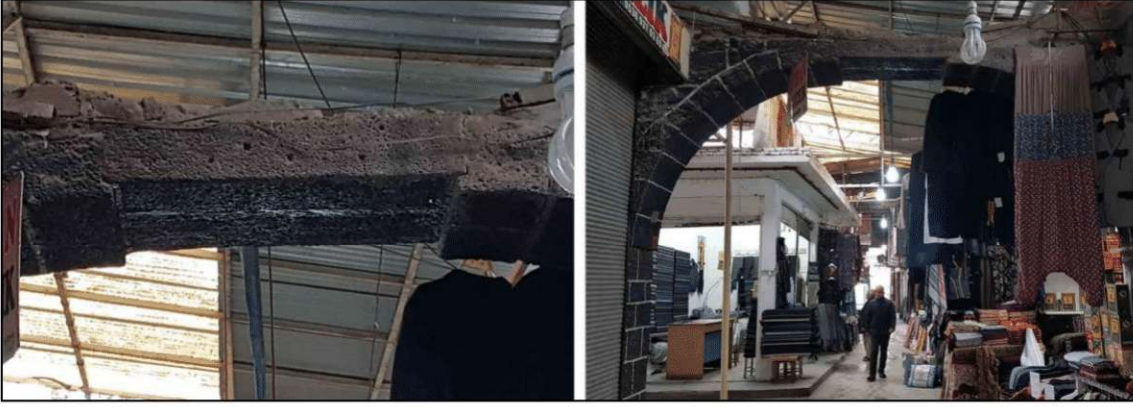
Şekil 4.59. Kemer kilit taşı oturum detay resmi
