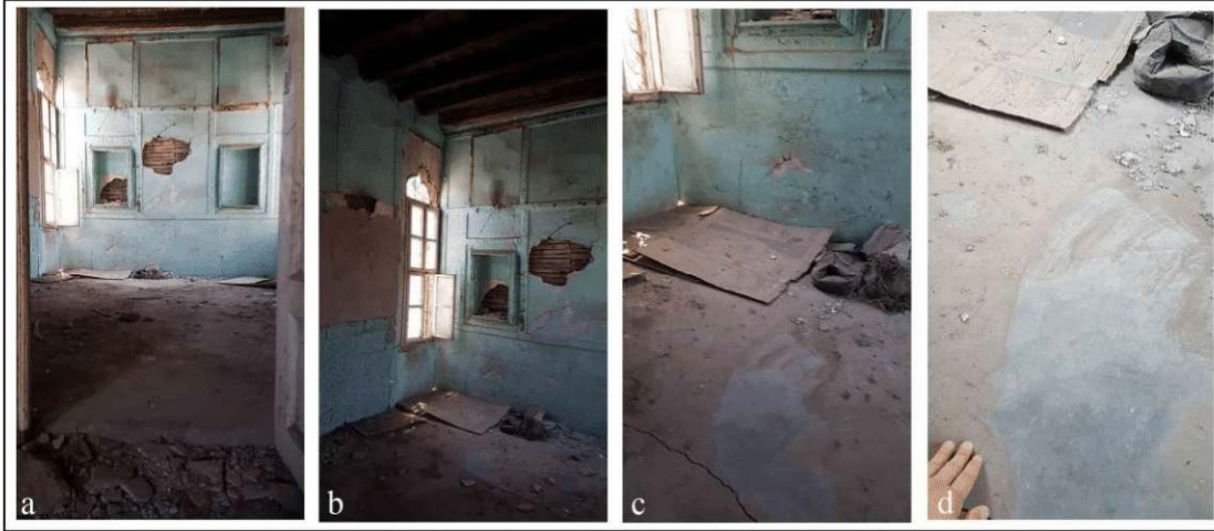
Şekil 4.64. Horasan tesviye harçlı toprak döşeme (Parlak dokulu)
