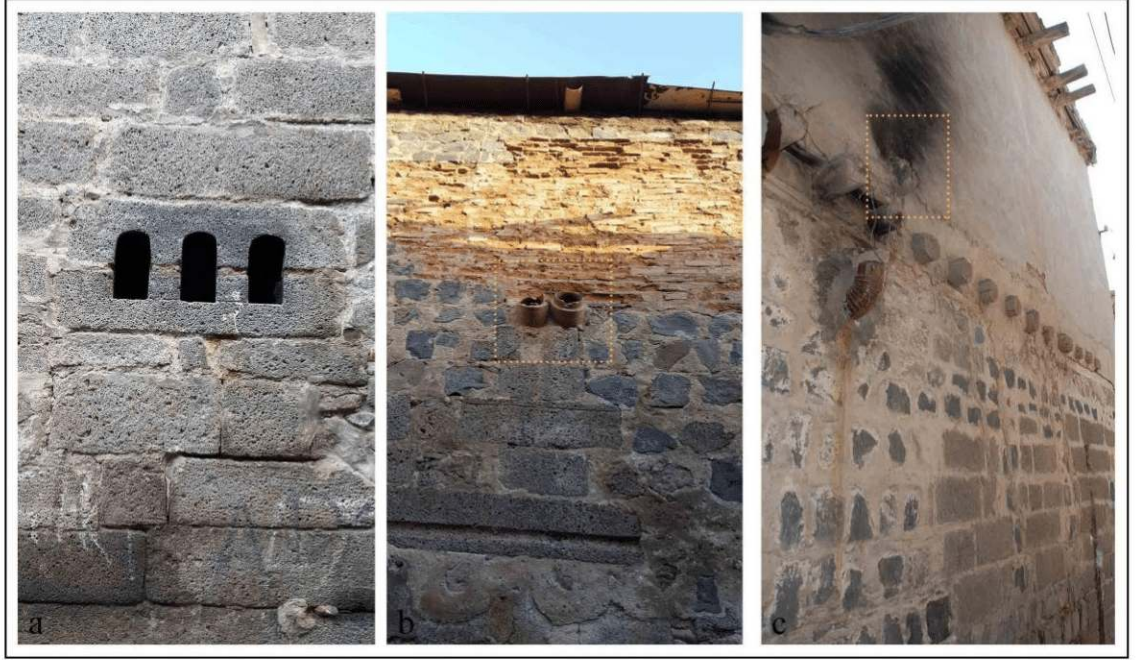
Şekil 4.181. Sokağa cephesinden tahliye edilen duman baca örnekleri
