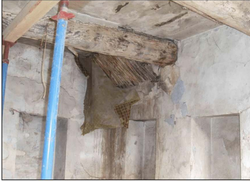
Şekil 4.66. Ahşap kiriş destekli üzeri bazalt döşeme
