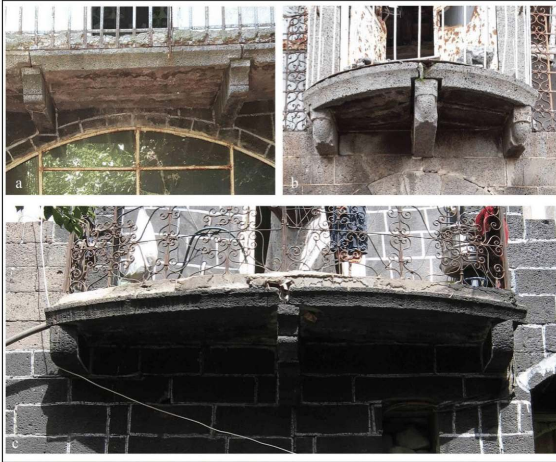
Şekil 4.85. Gezemek ve balkonlarda sal taşlarının kullanılması
