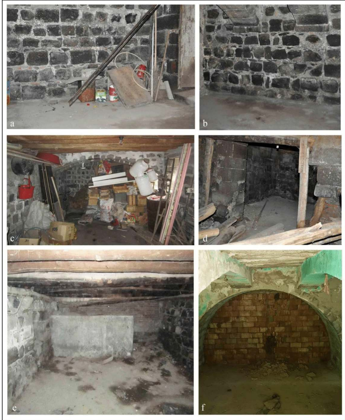
Şekil 4.48. Kil-toprak karışımlı bodrum döşemesi örnekleri
