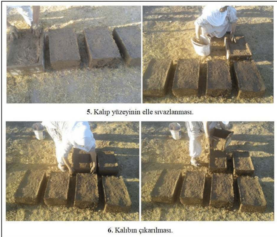
Şekil 4.42. Kerpicingin hazırlanması (5. ve 6. Aşamaları) (Dinç 2015)
