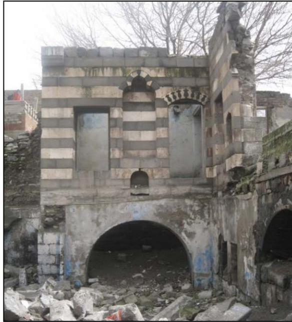
Şekil 4.136. Bodrumda beşik kemer kullanımı
