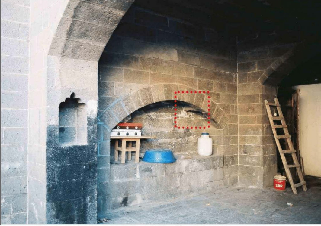
Şekil 4.178. Bağlayıcı destek taşının farklı yerde yapıldığı ocak örneği
