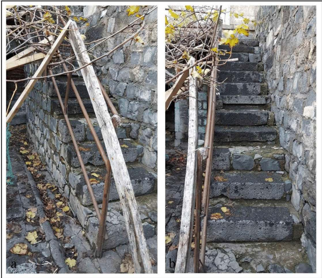
Şekil 4.169. İşçilikleri az, taş dolgu destekli merdiven örneği
