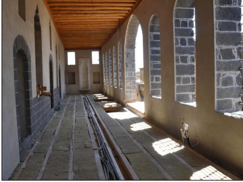
Şekil 5.6. Günümüz restorasyonlarında ahşap kirişli döşeme uygulaması
