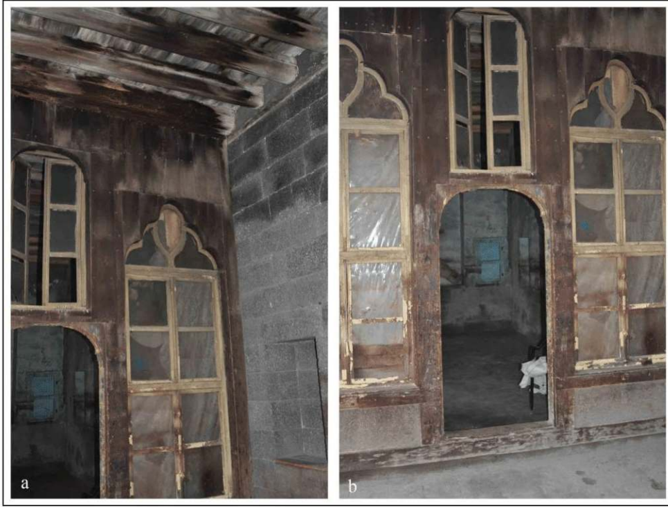
Şekil 4.33. Ahşap karkas ara bölme duvarı örnek resimleri
