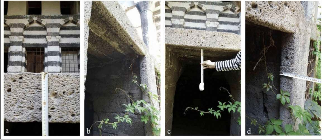
Şekil 4.75. Geleneksel evler eyvan döşeme kalınlıkları
