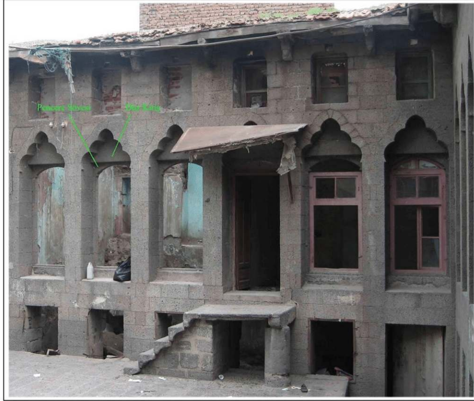
Şekil 4.148. Dilimli kemer içinde düz kiriş ve basık kemerli pencere sövesi örneği
