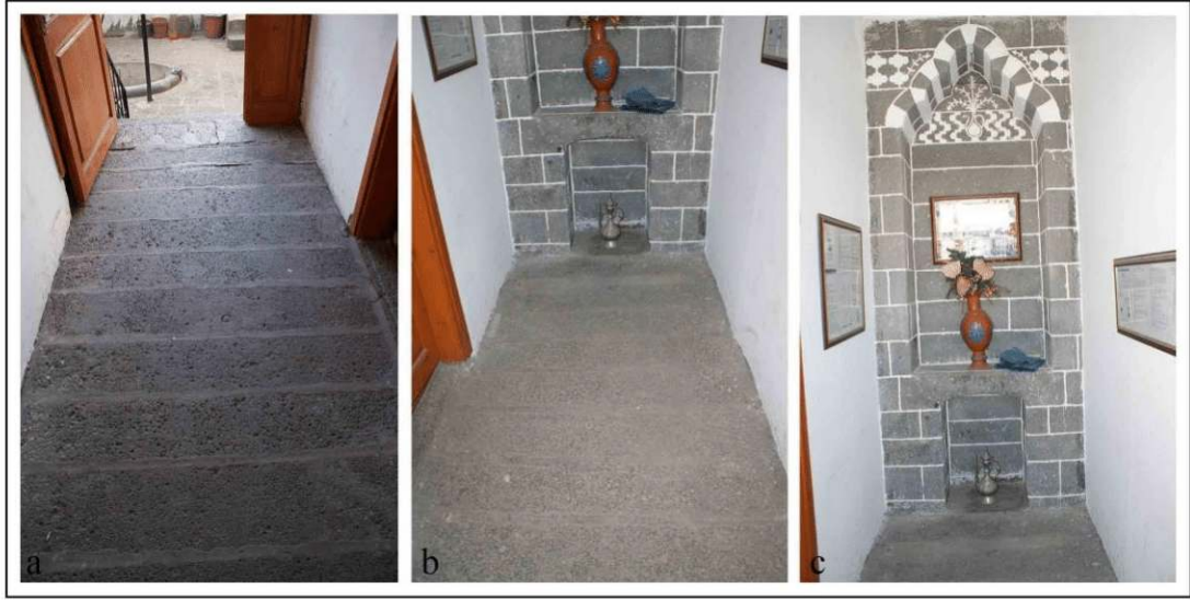
Şekil 4.63. Sal taş ile yapılan zemin kat döşeme örnekleri
