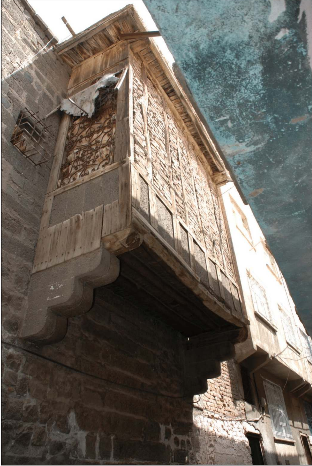
Şekil 4.199. Dolgu malzemesi tuğladan yapılan cumba örneği (Dalkılıç fotoğraf arşivi)
