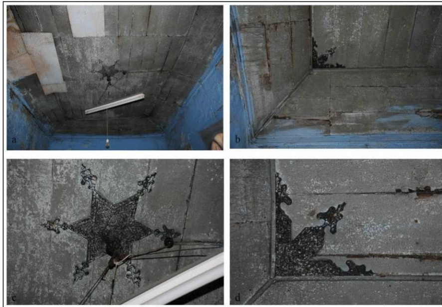
Şekil 4.102. Ahşap kiriş altı süslemeli tavan kaplama resimleri (Dalkılıç fotoğraf arşivi)
