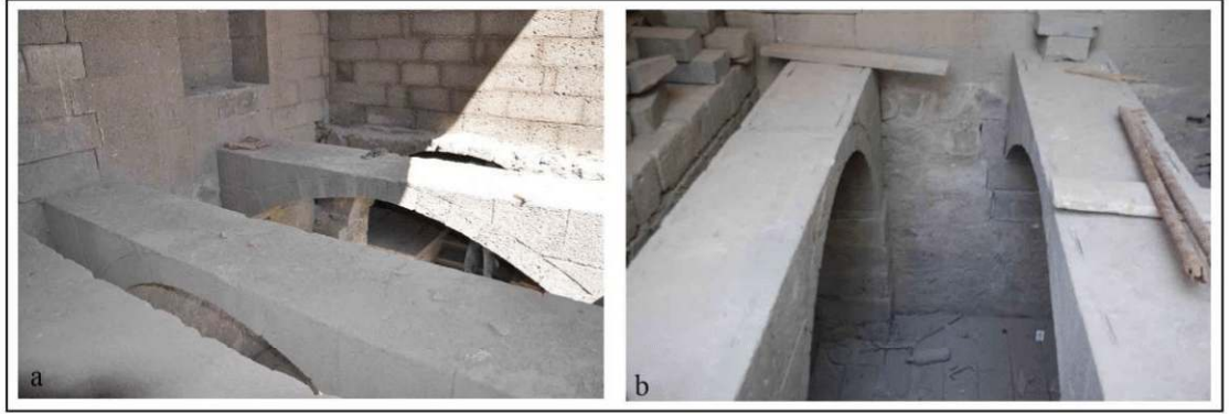
Şekil 5.7. Günümüz restorasyonlarında sal taşı döşemesi yapım aşaması (Dalkılıç fotoğraf arşivi)
