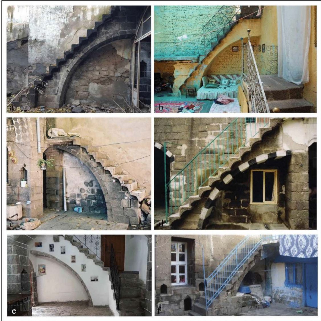
Şekil 4.164. Kemer destekli merdiven örnek resimleri (Dalkılıç fotoğraf arşivi)
