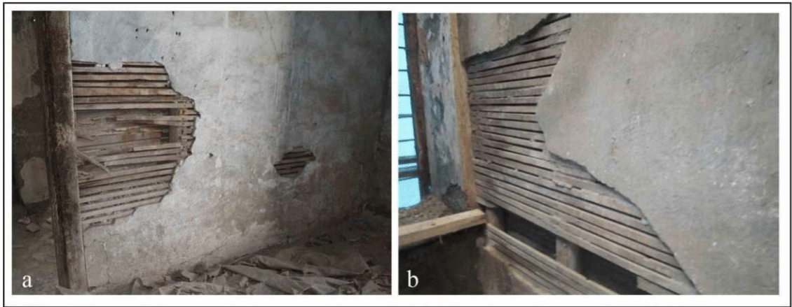
Şekil 4.34. Bağdadi tekniğinde, çıta üstü sıvalı ara bölme duvarı
