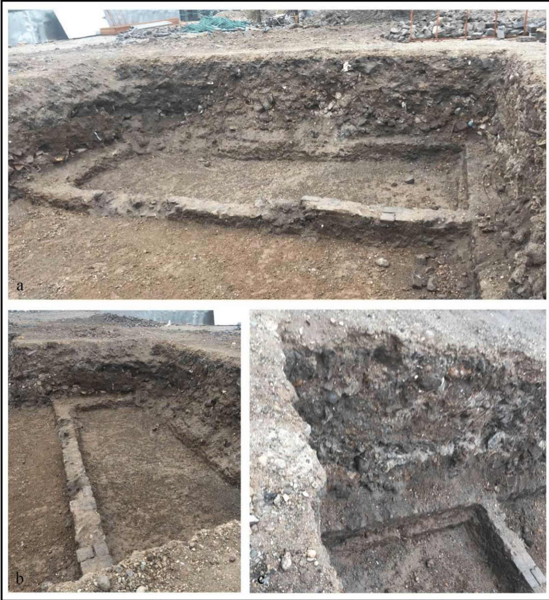
Şekil 4.1. Diyarbakır Geleneksel evlere ait, kazı çalışmaları sırasında açığa çıkan temel görüntüleri
