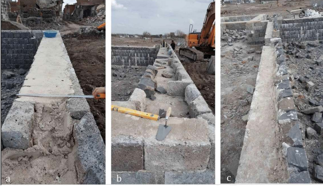
Şekil 5.2. Rekonstrüksiyon çalışması, duvar yapımı geleneksel yapı örneği
