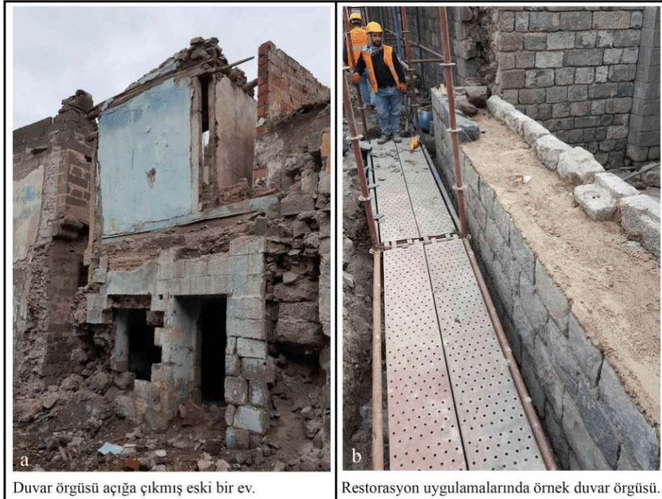
Şekil 5.3. Günümüz restorasyonlarında duvar örgüsü uygulaması
