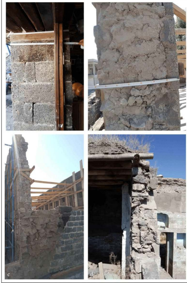
Şekil 4.46. Geleneksel evlerdeki duvar kalınlık ölçümleri (2018)
