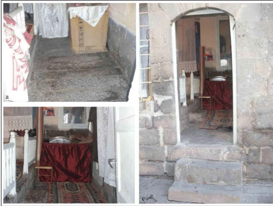
Şekil 4.60. Zemin kat döşemesi bazalt taşından yapılmış ev örnekleri (Dalkılıç fotoğraf arşivi)
