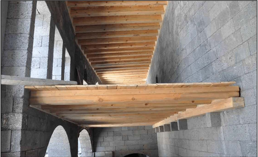
Şekil 5.4. Günümüz restorasyonlarında ahşap kirişli döşeme uygulaması (Dalkılıç fotoğraf arşivi)
