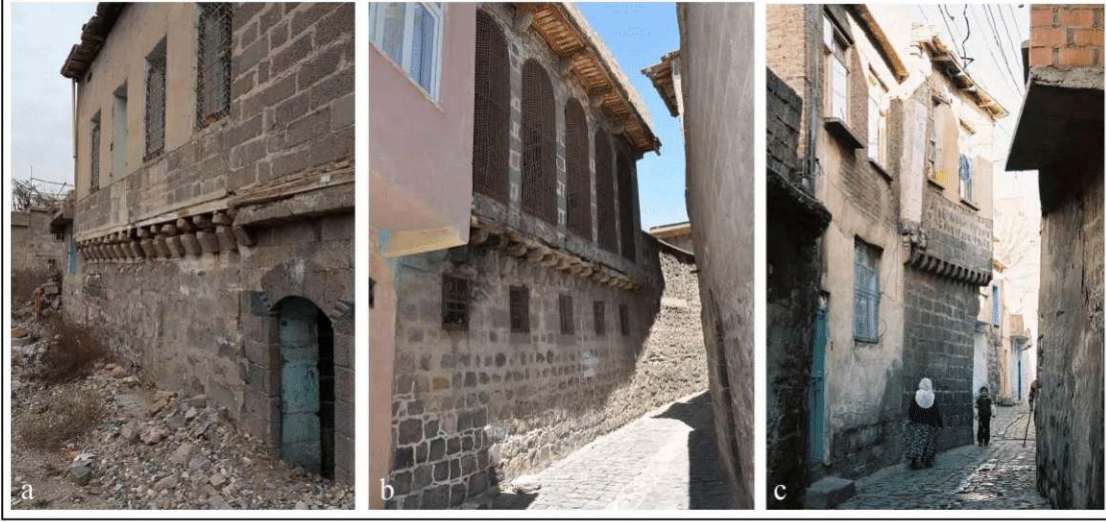
Şekil 4.72. Zemin üstü odaların genişletilmesi yöntemi
