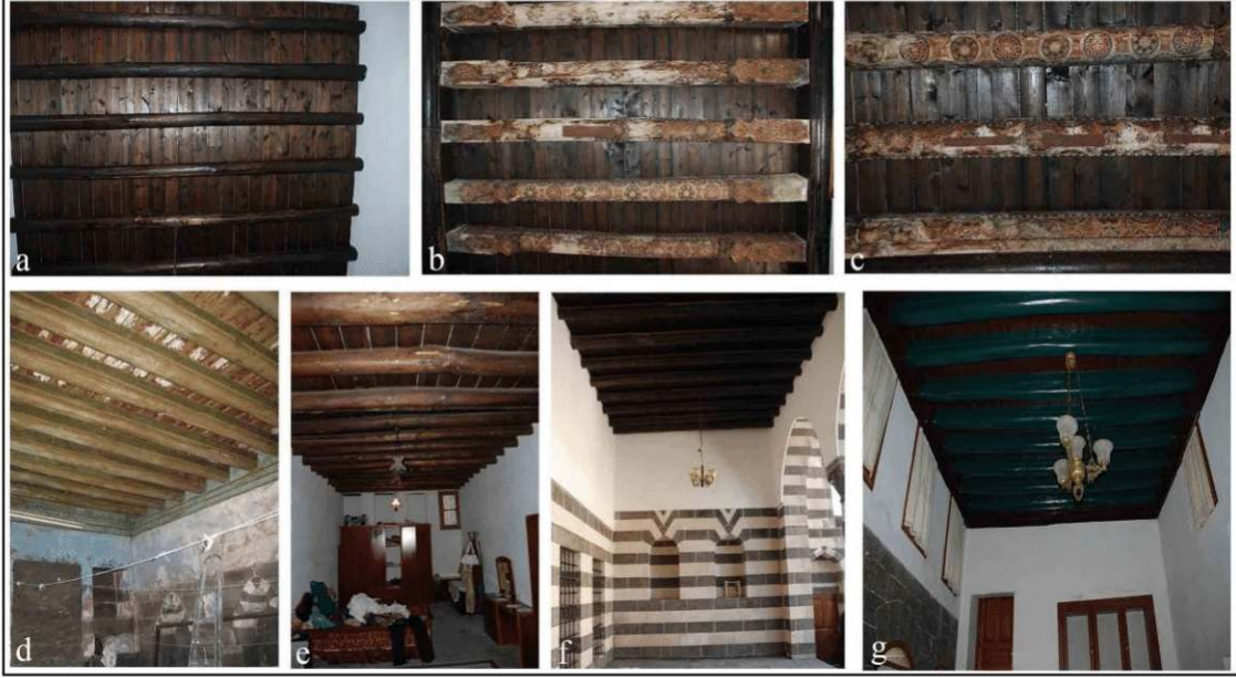
Şekil 4.99. Döşemeleri taşıyan ahşap kirişleri örnekleri (Dalkılıç fotoğraf arşivi)
