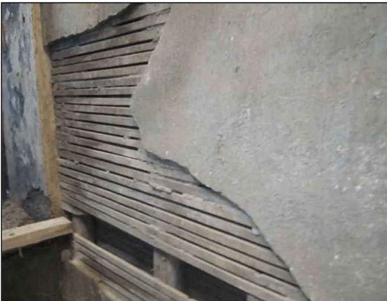
Şekil 4.192. Cumba duvarı detayı (Bağdadi duvar tekniğinde)
