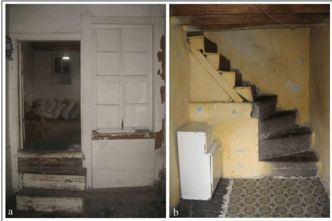
Şekil 4.170. Ahşap merdiven örnekleri (Dalkılıç fotoğraf arşivi)
