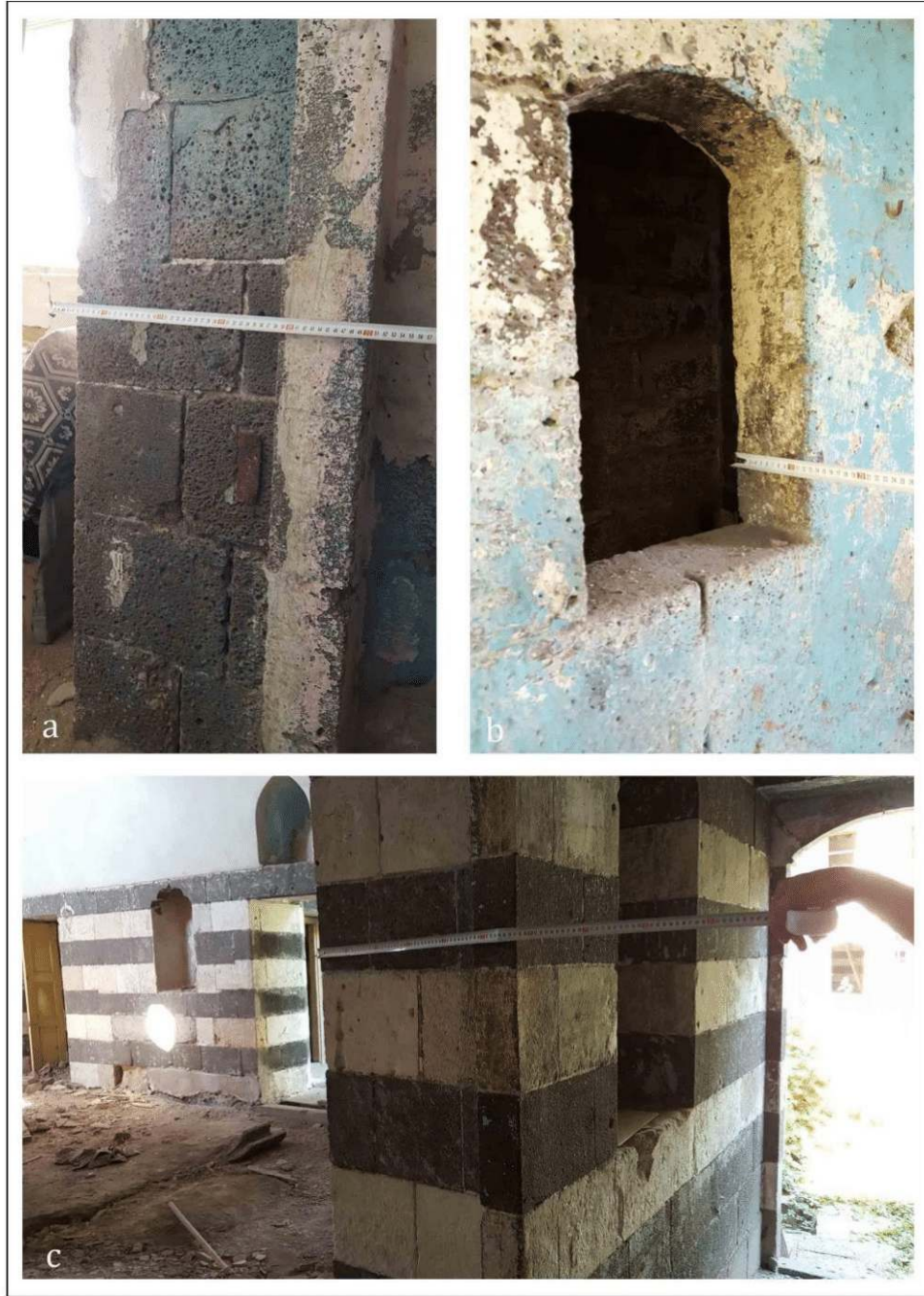
Şekil 4.47. Ara mekân duvar kalınlıkları ölçüleriyle belgelendirilmesi
