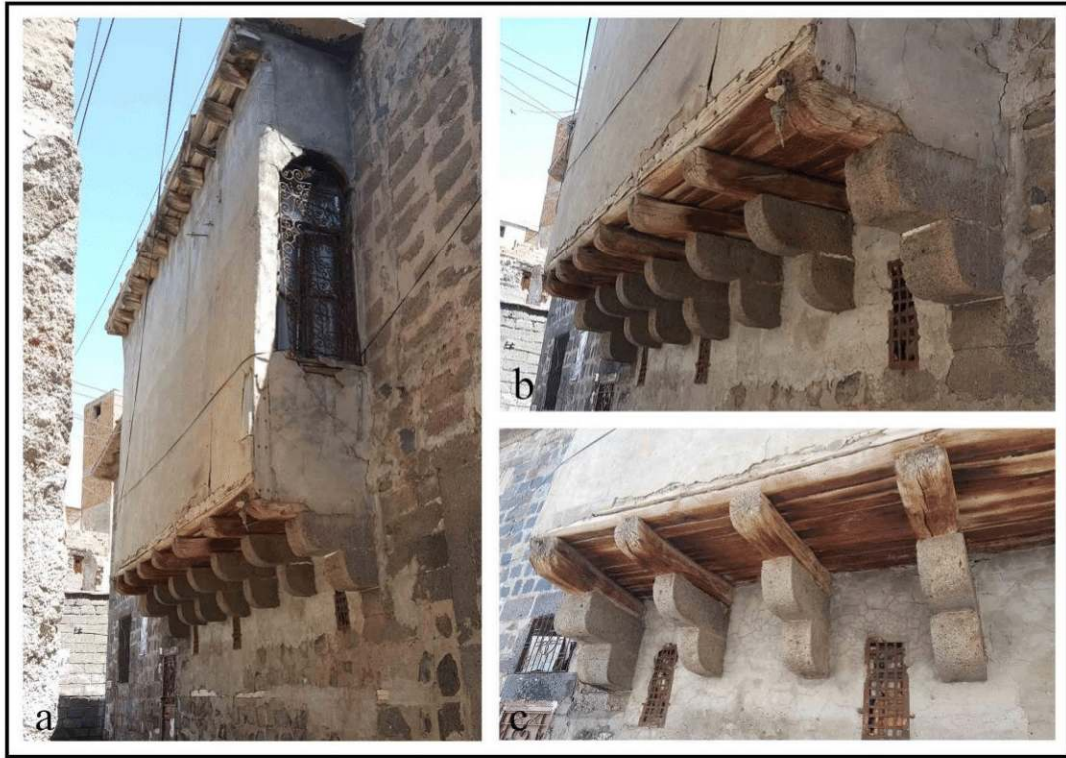
Şekil 4.197. Cumbaların çeşitli yapım şekilleri ile taşıyıcı taş bingi detayı resimleri
