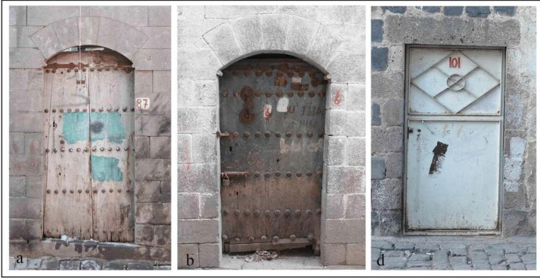
Şekil 4.151. Kapı üstü basık kemer ve düz lento ile geçilen örnekler
