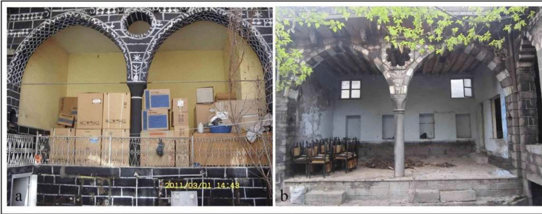
Şekil 4.134. Basık sivri kemerden yapılmış iki gözlü eyvan kemer resimleri
