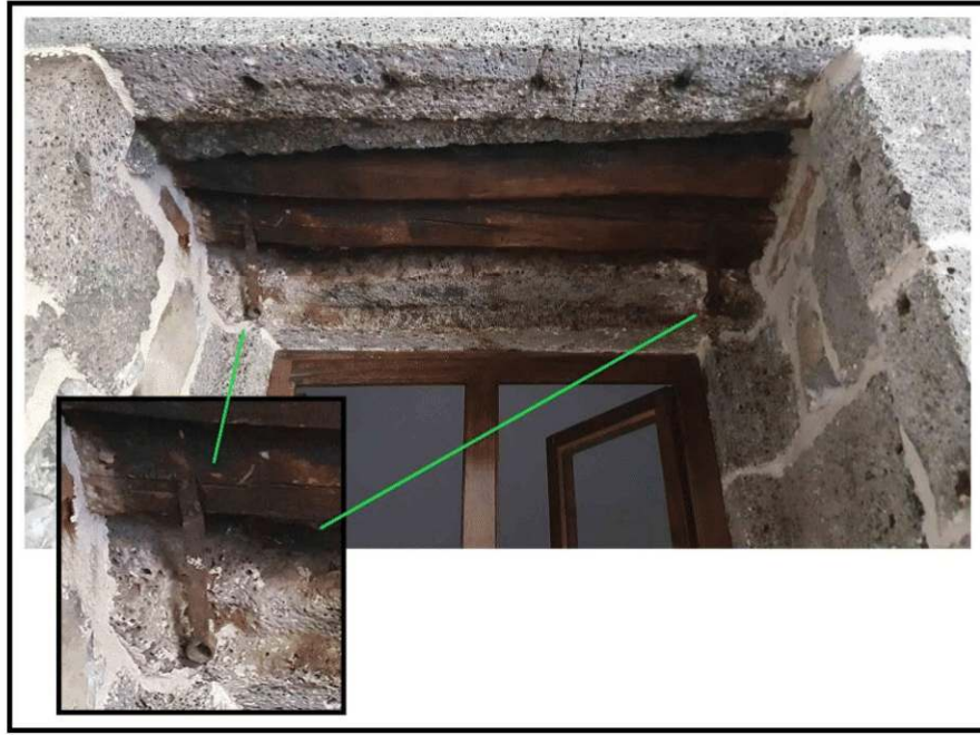
Şekil 4.207. Pencere kapaklarının montajı için kullanılan çengel detayı
