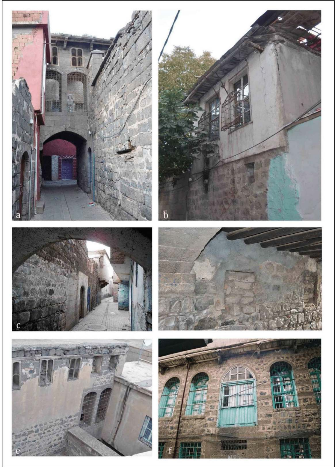
Şekil 4.21. Moloz ve kaba yonu taşların kullanıldığı geleneksel ev cephe örnekleri
