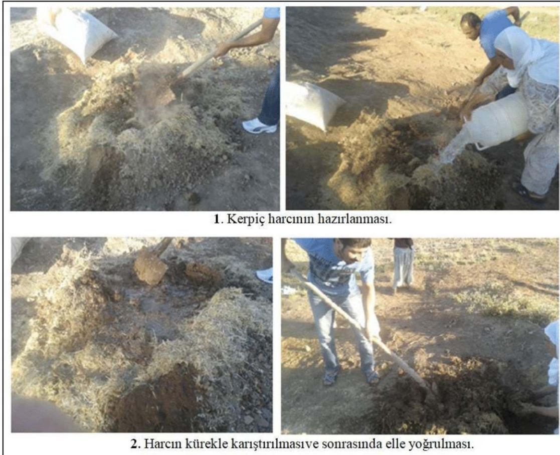
Şekil 4.40. Kerpicin hazırlanması (1. ve 2. Aşamaları) (Dinç 2015)
