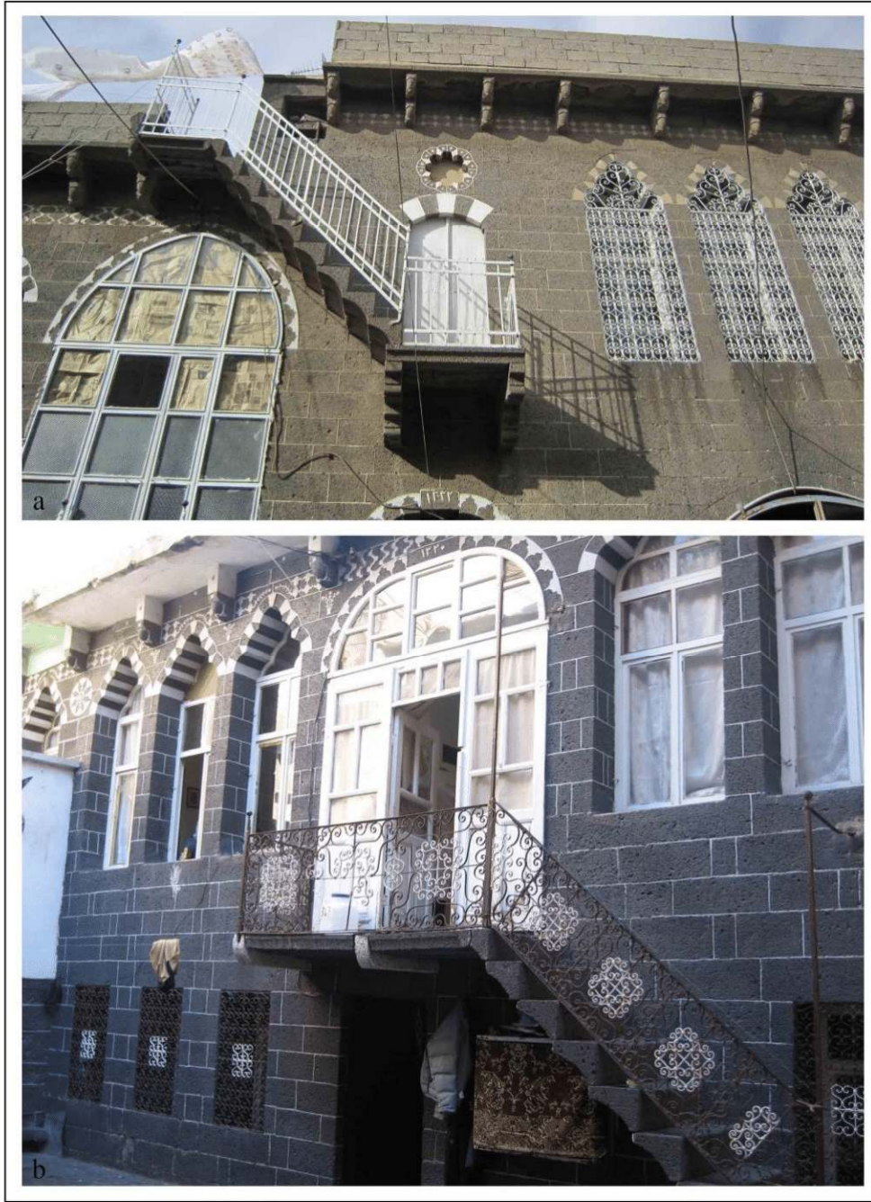
Şekil 4.160. Diyarbakır geleneksel evleri konsol merdiven örnekleri
