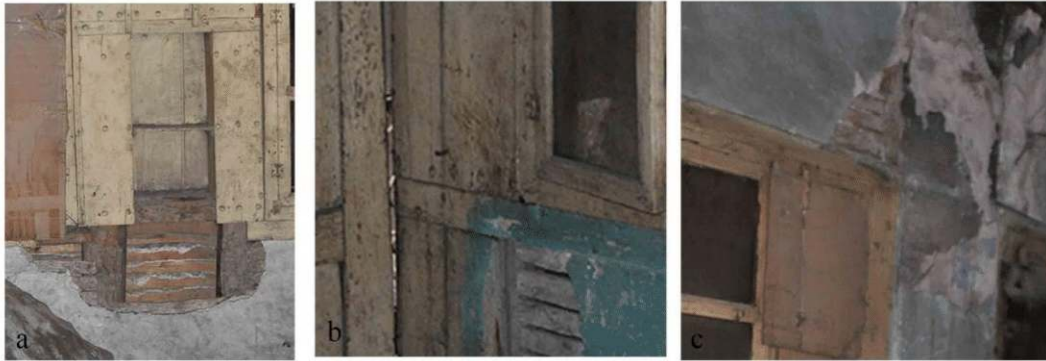
Şekil 4.35. Ahşap karkas (bağdadi) duvar taşıyıcı elemanların belirtilmesi
