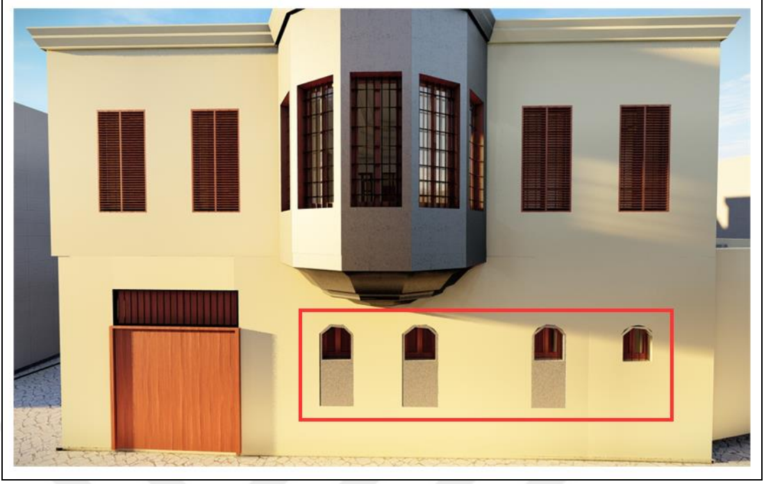
Şekil 3.15 Restorasyon öncesi sokak cephesi pencere boşlukları (Emine Göğüş Mutfak Müzesi, 2022, Kaynak: Yazar)
