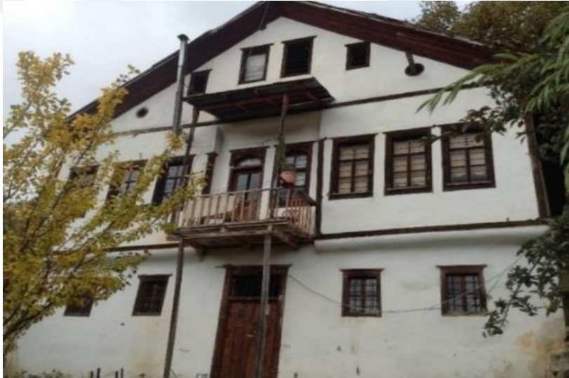
Şekil 7. Ali Erkan Konağı
