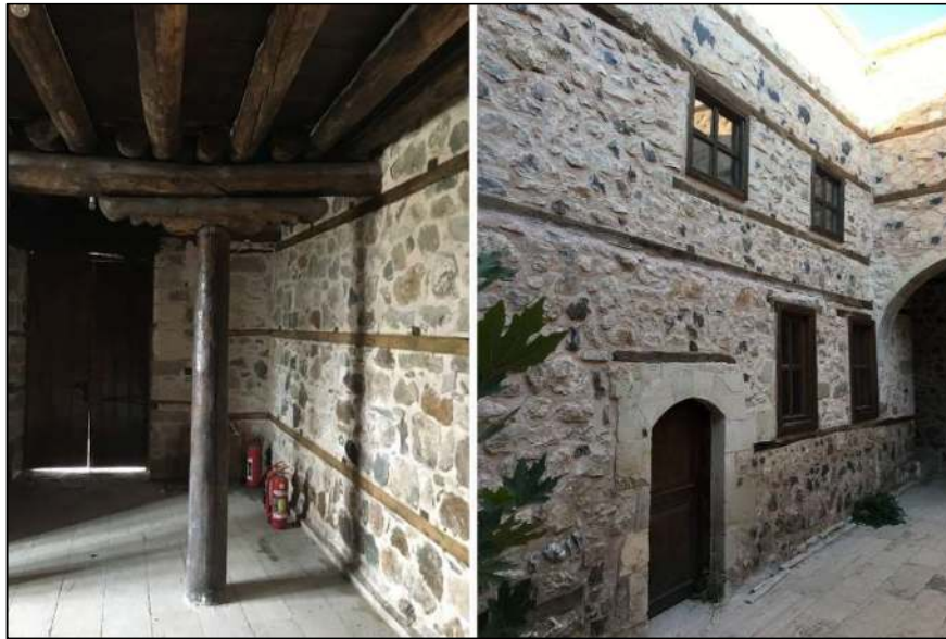
Şekil 4.27 Geleneksel Harput evleri taşıyıcı sistem (Akpolat, 2022)
