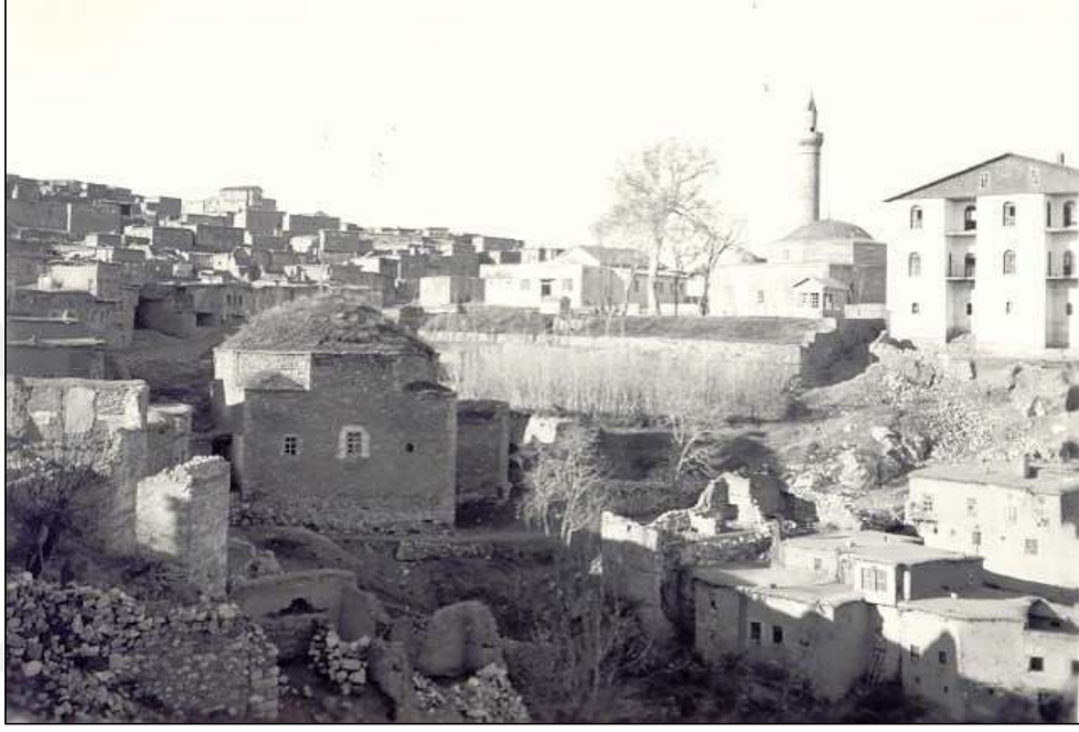
Şekil 3.30 Hoca Mescit Mahallesi ve çevresi (Anonim)
