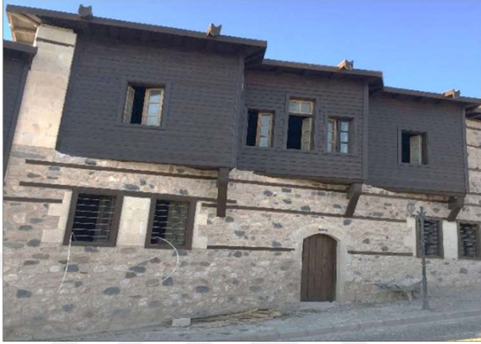
Şekil 5.68 Fehmi Baran II Evi güney cephesinden bir görünüm (Akpolat, 2021)
