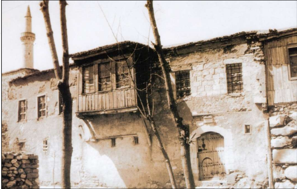
Şekil 4.22 Ağa Cami yakınında bir ev (Anonim, 1970)
