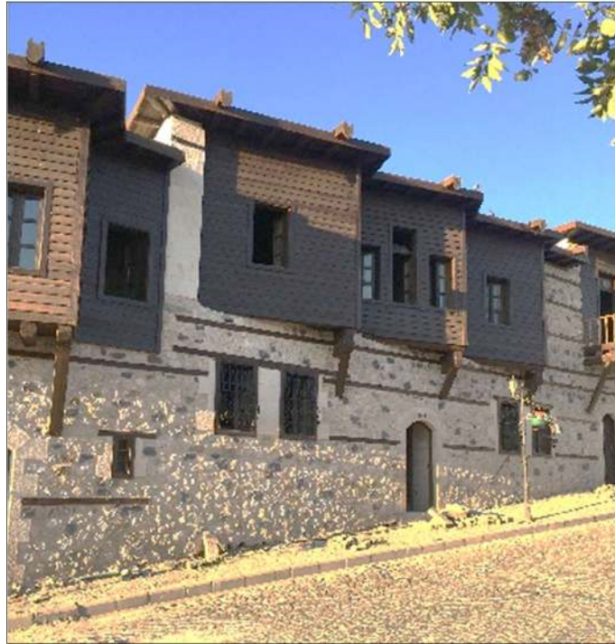
Şekil 5.76 Fehmi Baran II Evi güneybatı cephesi (Akpolat, 2021)
