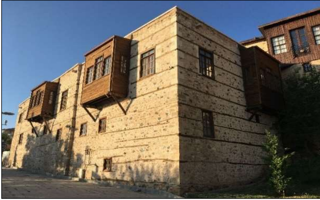
Şekil 5.10 Sağır Müftü Konağı güneybatı cephesi (Akpolat, 2021)
