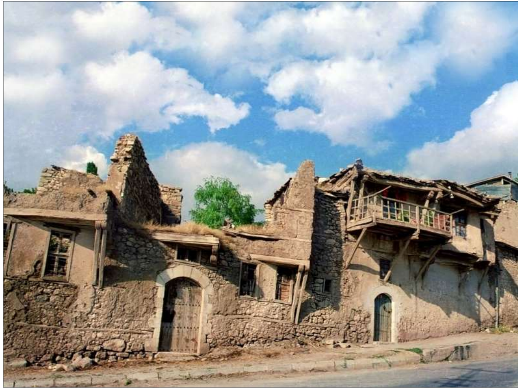
Şekil 5.90 Hüseyin Şaşkın Evi güneybatı cephesi (Anonim, 2005)
