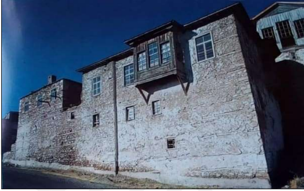
Şekil 5.9 Sağır Müftü Konağı güneybatı cephesi (Ataman, 1990)
