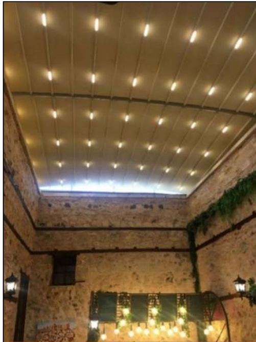
Şekil 5.18 Sağır Müftü Konağı'nın iç avlusuna çatı eklenmesi ( Akpolat, 2023)
