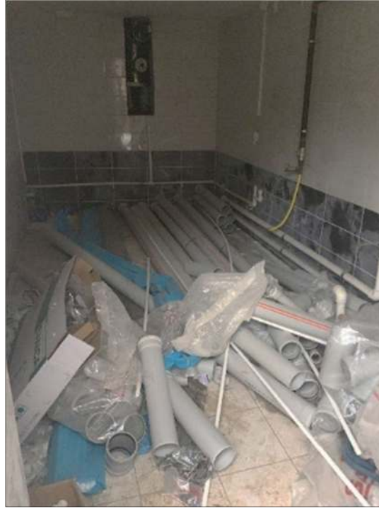
Şekil 5.78 Fehmi Baran II Evi ek yapı (Akpolat, 2021)
