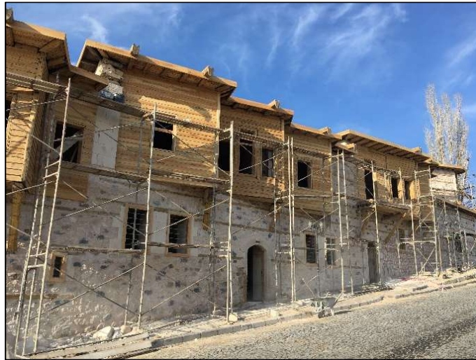
Şekil 5.71 Fehmi Baran II Evi güneybatı cephesi (Akpolat, 2021)
