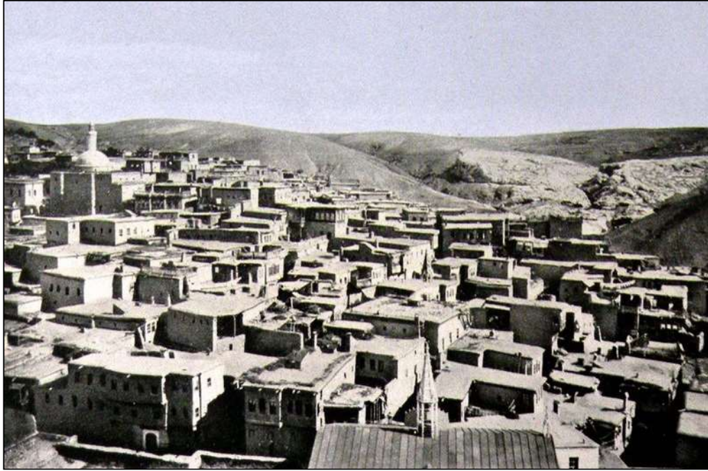
Şekil 3.10 Harput Gürcü Bey Mahallesi güneydoğu görünümü (Anonim, 19.yy)
