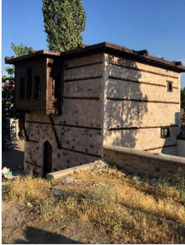
Şekil 5.97 Ahmet Ekşi Evi kuzeydoğu cephesi (Akpolat, 2021)
