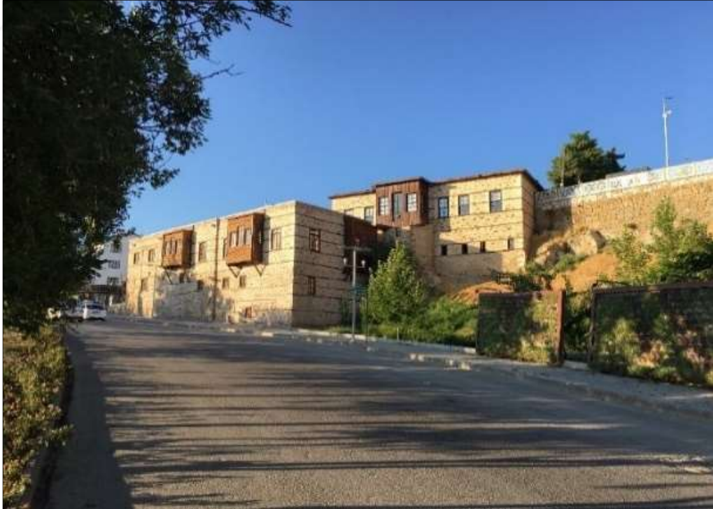
Şekil 5.5 Sağır Müftü Konağı güneybatı cephesi (Akpolat, 2022)
