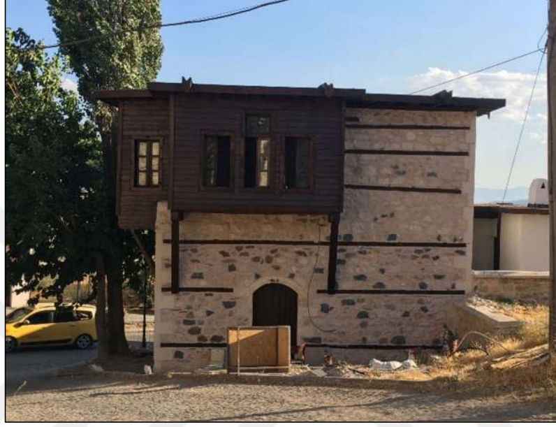
Şekil 5.100 Ahmet Ekşi Evi kuzeydoğu cephesi (Akpolat, 2021)
