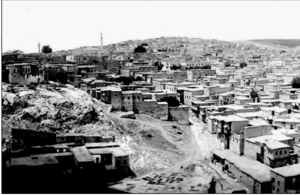
Şekil 3.20 Harput Kalesi'nden Gürcü Bey Mahallesi'nin görünümü (Bell, 1909)
