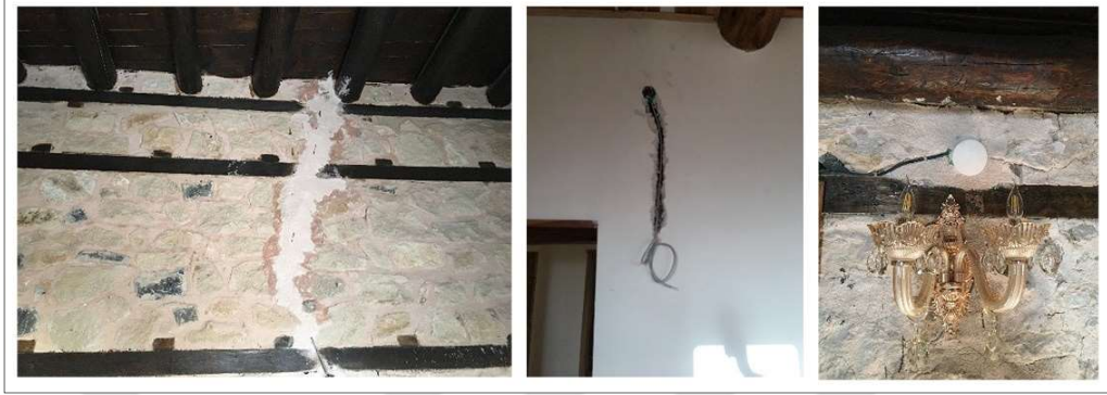
Şekil 5.15 Taş duvarın alçıyla kapatılması ve sıva üstü görülen tesisat (Akpolat, 2021)
