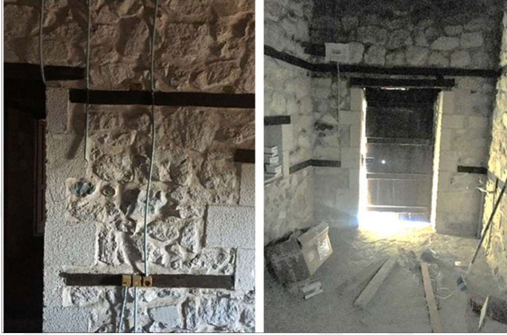
Şekil 5.53 Burcu Kaya Evi zemin kat oda ve sofasında sıva üstü uygulamalar (Akpolat, 2021)
