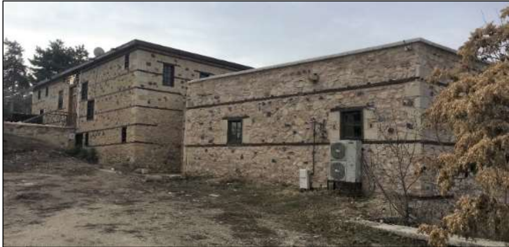
Şekil 5.14 Sağır Müftü Konağı kuzeydoğu cephesi (Akpolat, 2021)
