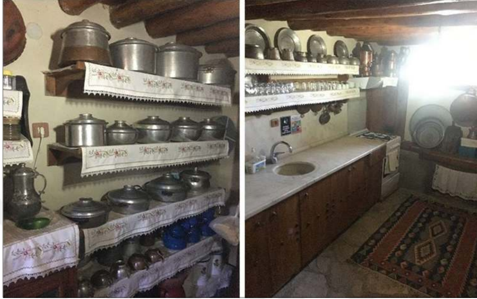
Şekil 5.40 Şefik Gül Evi zemin katta bulunan ahır ve merak bölümlerinin mutfak ve depoya dönüştürülmesi (Akpolat, 2021)
