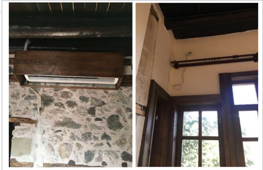
Şekil 5.16 Klima montajı tesisat bağlanması CCTV kabloların gözükmesi (Akpolat, 2021)
