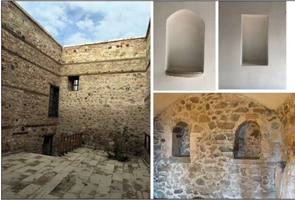
Şekil 4.28 Geleneksel Harput Evleri duvar görünümleri (Akpolat, 2022)
