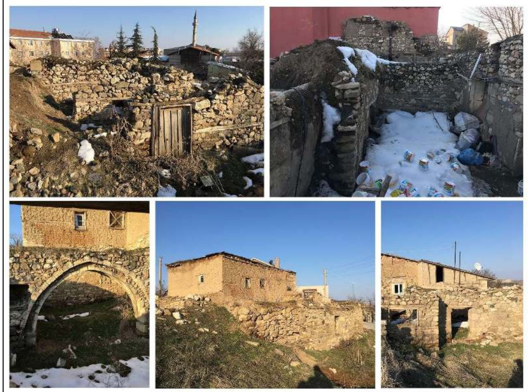
Şekil 6.2 Bakımsızlıktan dolayı büyük bir bölümü yıkılan evler (Akpolat, 2023)
