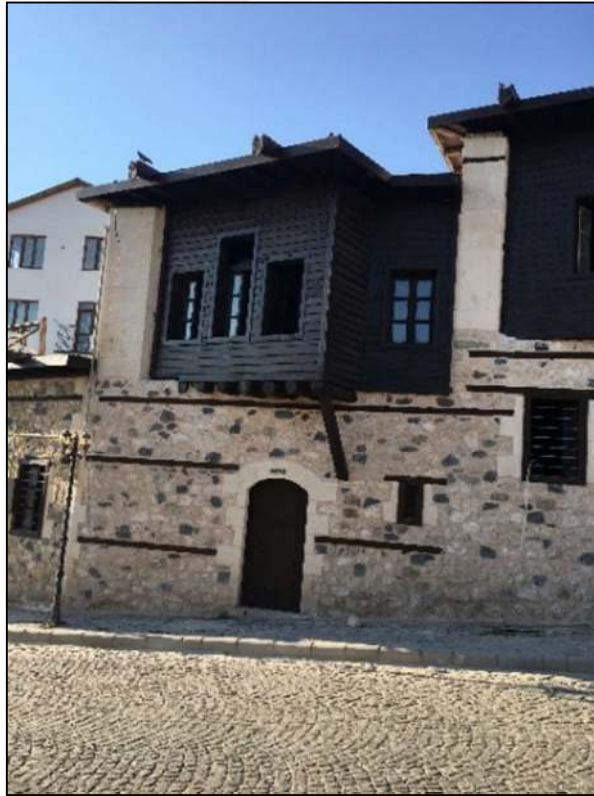
Şekil 5.61 Fehmi Baran I Evi güney cephe görünüm (Akpolat, 2021)
