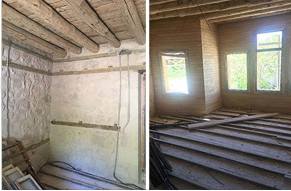
Şekil 5.65 Fehmi Baran I Evi üst kat oda (Akpolat, 2021)
