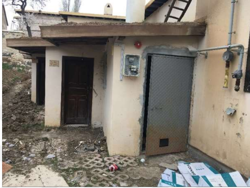
Şekil 5.77 Fehmi Baran II Evi ek yapı (Akpolat, 2021)
