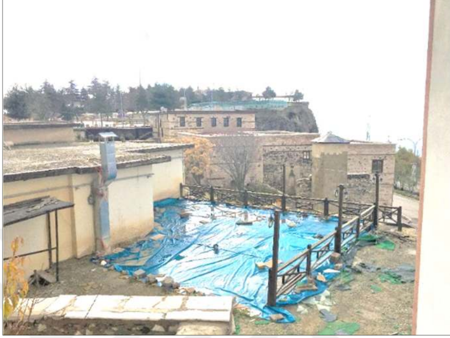
Şekil 5.51 Burcu Kaya Evi kuzeybatı cephesi (Akpolat, 2021)
