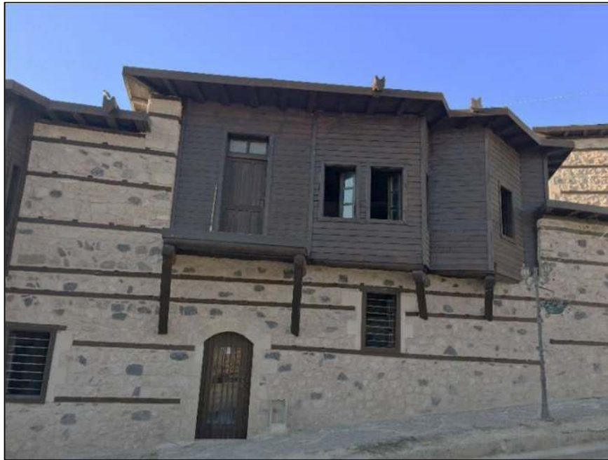
Şekil 5.87 Hüseyin Şaşkın Evi güney cephesinden görünüm (Akpolat, 2021)
