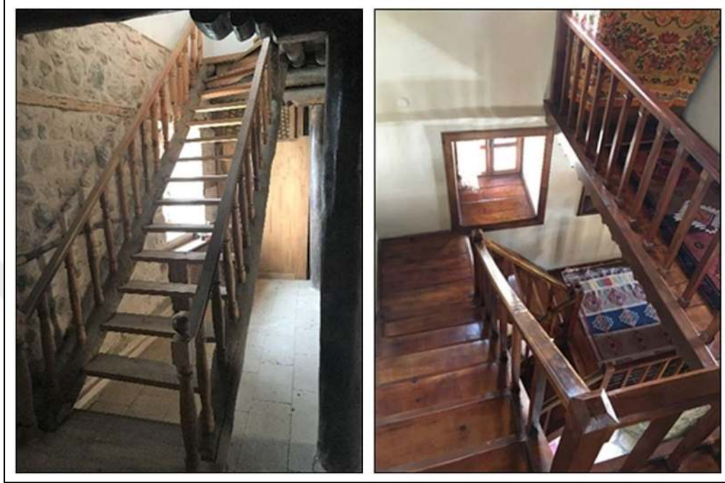
Şekil 4.20 geleneksel Harput evleri merdiven örneği (Akpolat, 2022)
