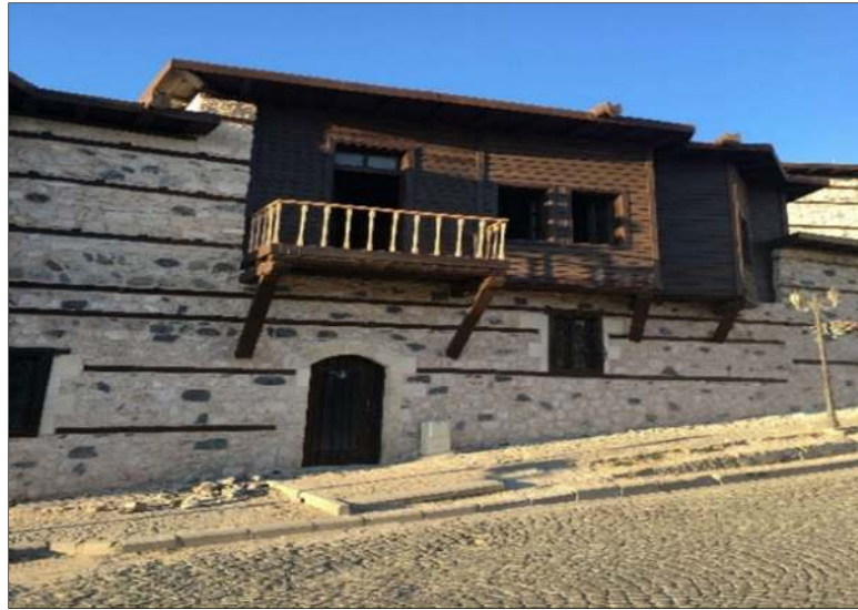
Şekil 5.84 Hüseyin Şaşkın Evi güney cephesinden görünüm (Akpolat, 2021)
