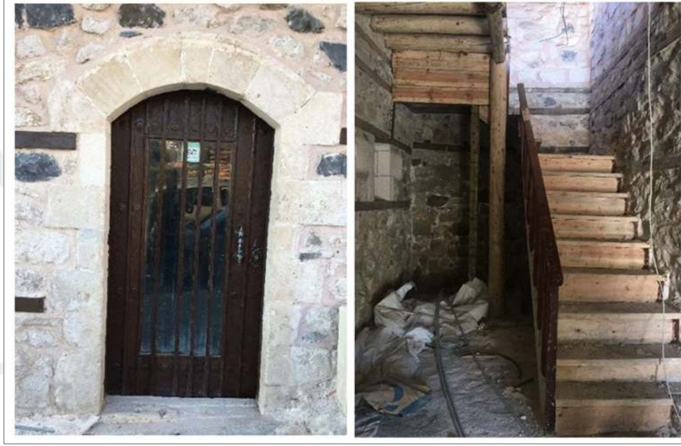
Şekil 5.88 Hüseyin Şaşkın Evi giriş kapısı (Akpolat, 2021)
