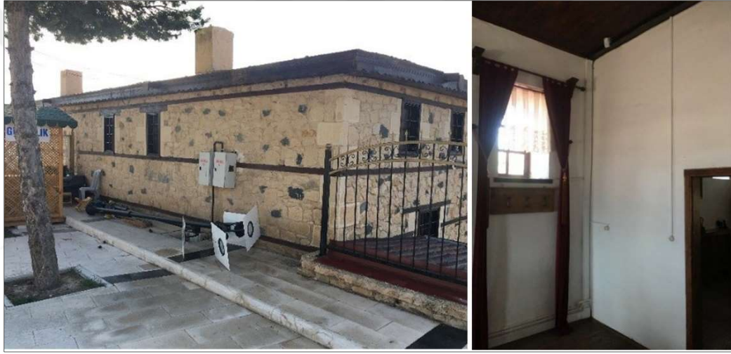
Şekil 5.28 Sunguroğlu Konağı kuzeydoğu cephesi ve Sunguroğlu Konağı zemin kat (Akpolat, 2021)
