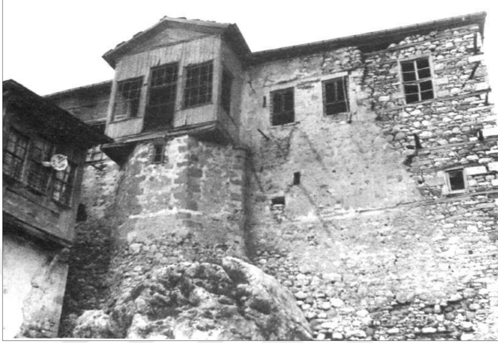
Şekil 5.19 Sunguroğlu Konağı güneybatı cephesi (Anonim, 1977)
