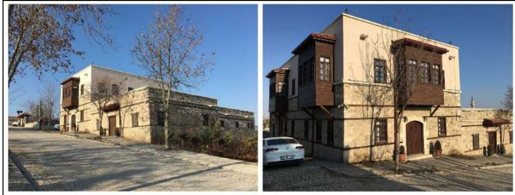
Şekil 5.118 Valilik Konuk Evi'nin restorasyon sonrası görünümü (Akpolat, 2023)
