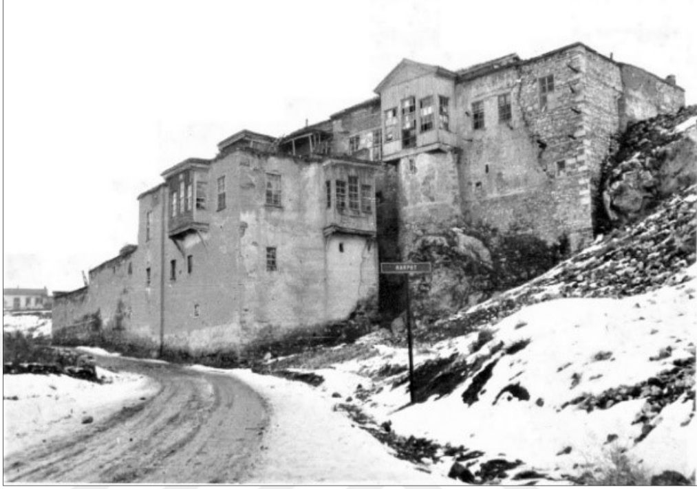
Şekil 5.4 Sağır Müftü Konağı güneybatı cephesi (Anonim,1970)
