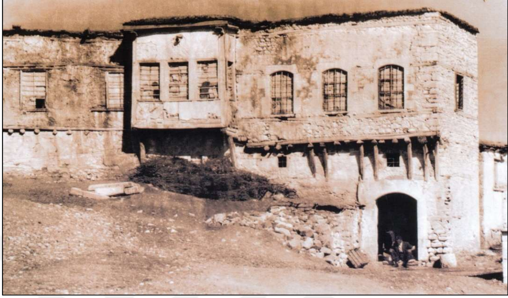
Şekil 4.21 Ağa Cami yakınında bir ev (Anonim, 1970)
