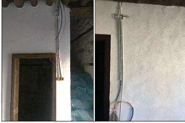
Şekil 5.105 Ahmet Ekşi sıva üstü tesisat (Akpolat, 2021)
