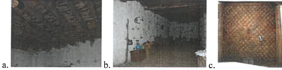
Şekil 2.40. a) Zemin kat tavan kaplaması bölümü; b) Oda tavan örneği (Şenocak 2016)
