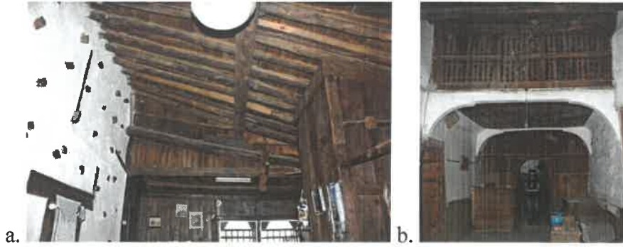
Şekil 2.47. a) Sofa örneği; b) Çatı arası kullanım örneği (Şenocak 2016)
